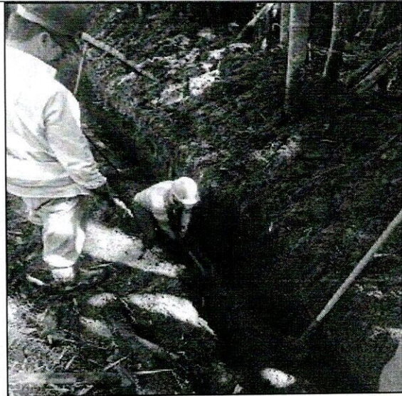
FOTO 4. Excavación en material común, Conglomerado - 0.0 a 3.0 Mt
