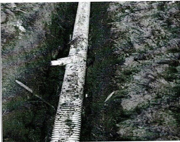
FOTO 5. Instalación Tubería 14"
