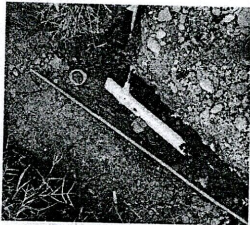
FOTO 15. Instalación de tubería PVC 3"
