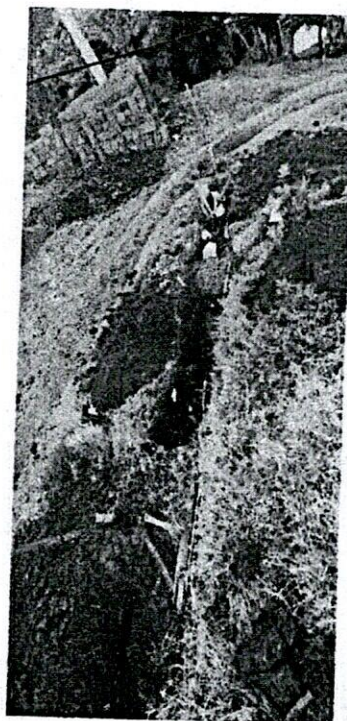
FOTO 8. Excavación parte baja
