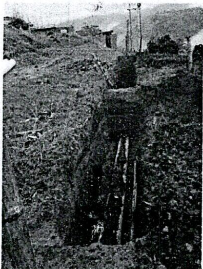
FOTO 9. Instalación de tubería 12"
