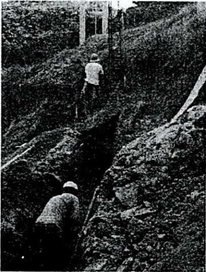
FOTO 5. Excavación en el potrero.
