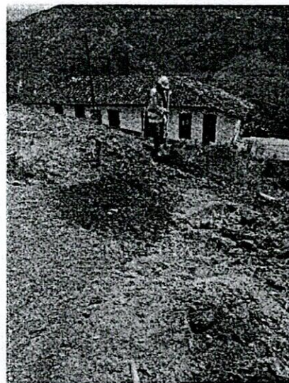
FOTO 20. Llenos y nivelación.
