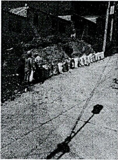
FOTO 3. Trincho en costales para contener
