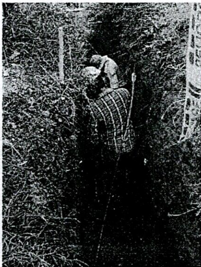
FOTO 19. Compactación de lleno
