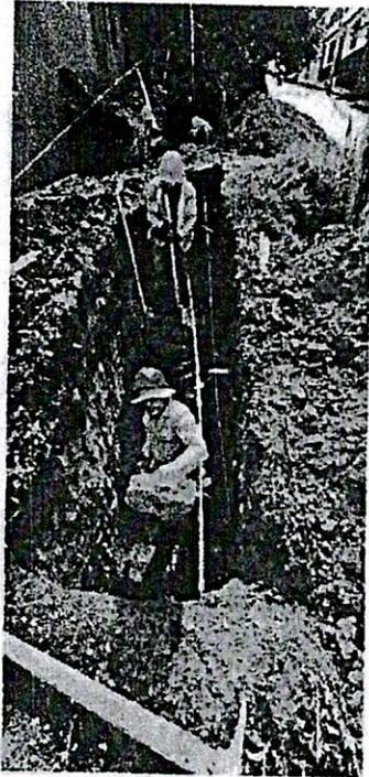
**FOTO 7. Excavación en zanja para alcantarillado**
