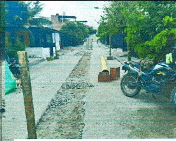
FOTO 4. Demolición de pavimento en concreto hidráulico
