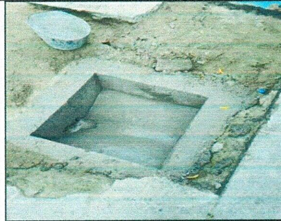
FOTO 11. Caja de inspección domiciliaria de 0,50m x 0,50m en concreto 3000 psi (incluye base, cañuela y tapa en concreto).
