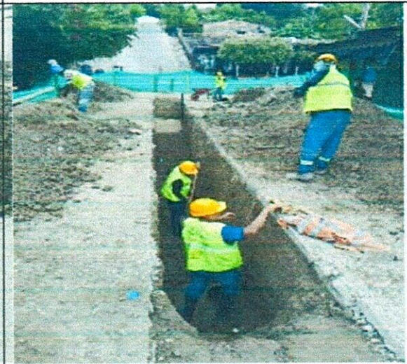
FOTO 6. Excavación en zanja - Material común 0,0 a 2,0 Mts
