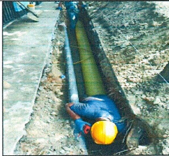
FOTO 7. Instalación de tubería PVC corrugada para alcantarillado
