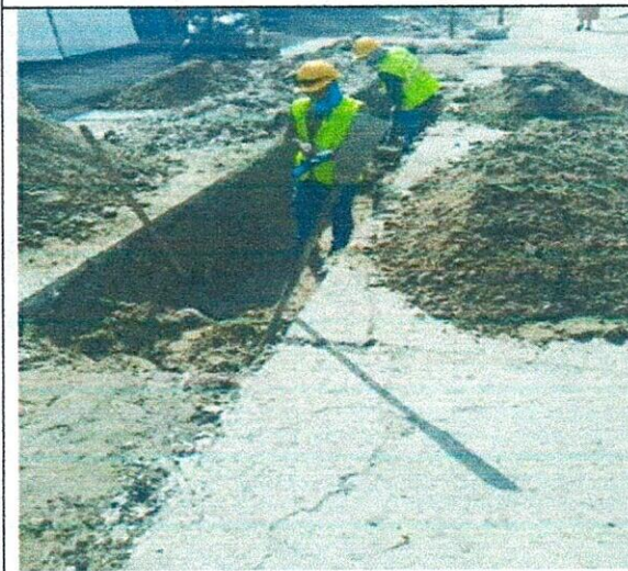
FOTO 5. Excavación en zanja - Material común 0,0 a 2,0 Mts
