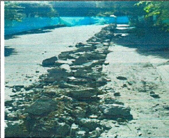
FOTO 3. Demolición de pavimento en concreto hidráulico.
