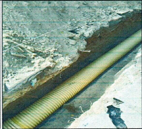
FOTO 8. Instalación de tubería PVC corrugada para alcantarillado
