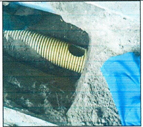
FOTO 10. Instalación empalme para PVC corrugada para domiciliaria de alcantarillado.
