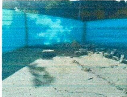
Cerramiento en polisombra vute verde de H=2m. parales en quadua y cinta plástica
