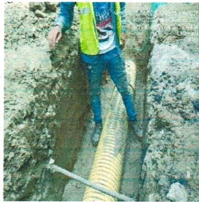
instalacion tuberia de 51 y de 12" para alcantarillado- meseta dorada y carrera 8 entre 20 y
