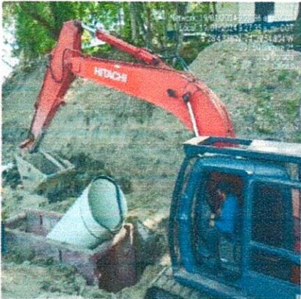
instalacion tuberia de 51 y de 12" para alcantarillado- meseta dorada y carrera 8 entre 20 y
