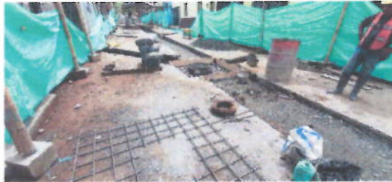
Imagen 15 Carrera 9 entre Calle 6 y 5 (24 Oct – 2019)
