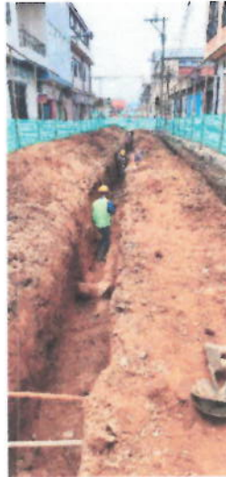
Imagen 27 Calle 13 entre Carrera 9 y Carrera 8 (10 oct – 2019)
