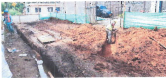
Imagen 25 Calle 13 entre Carrera 9 y Carrera 8 (22 oct – 2019)
