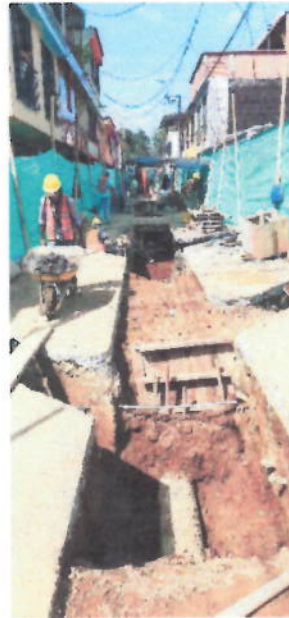
Imagen 8 Calle 4A entre carrera 8 y 9 (07 oct – 2019)
