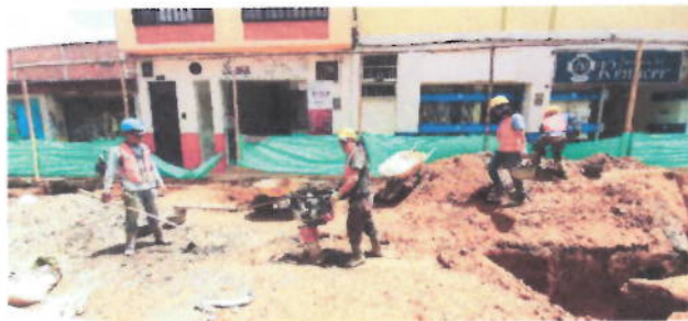
Imagen 29 Calle 13 entre Carrera 9 y Carrera 8 (22 oct – 2019)
