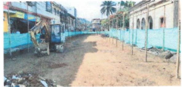
Imagen 32 Calle 13 entre Carrera 8 y Carrera 7 (17 oct – 2019)
