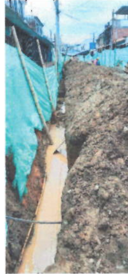
Imagen 2 Calle 4A entre carrera 8 y 9 (17 Oct – 2019)
