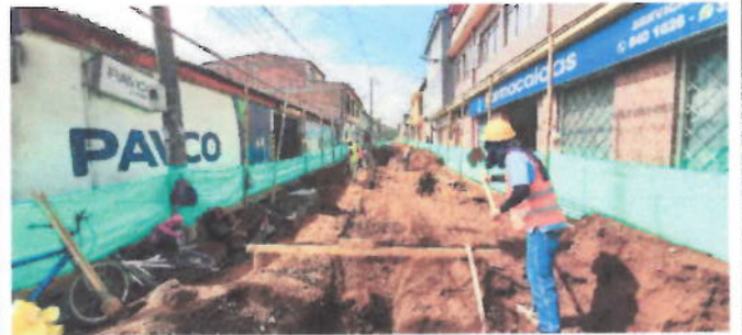
Imagen 28 Calle 13 entre Carrera 9 y Carrera 8 (17 oct – 2019)
