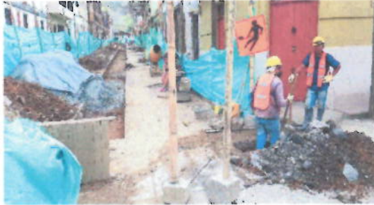
Imagen 13 Carrera 9 entre Calle 6 y 5 (10 Oct – 2019)
