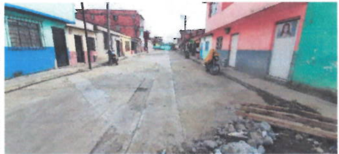
Imagen 12 Calle 5 entre carrera 6 y 5 (05 Nov – 2019)
