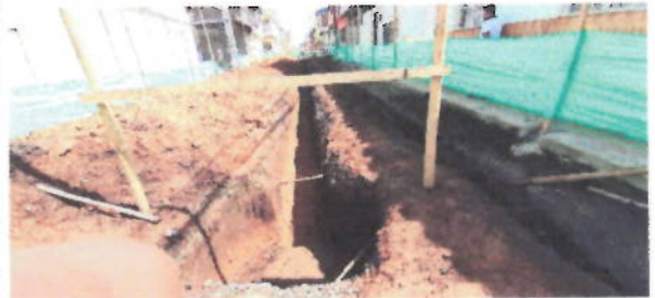
Imagen 24 Calle 13 entre Carrera 9 y Carrera 8 (10 oct – 2019)
