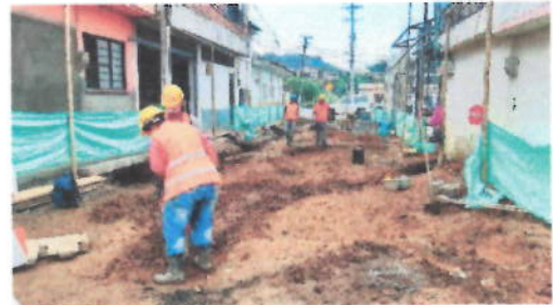
Imagen 26 Calle 13 entre Carrera 9 y Carrera 8 (30 Oct – 2019)
