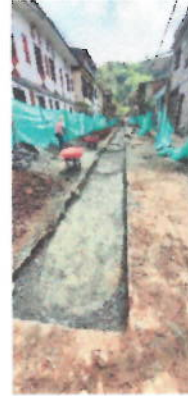
Imagen 14 Carrera 9 entre Calle 6 y 5 (17 Oct – 2019)
