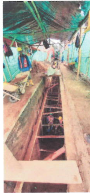
Imagen 6 Calle 3B entre carreras 8 y 7 (17 Oct – 2019)
