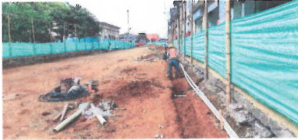
Imagen 31 Calle 13 entre Carrera 8 y Carrera 7 (10 oct – 2019)
