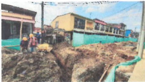
Imagen 3 Calle 4A entre carrera 8 y 9 (30 oct – 2019)
