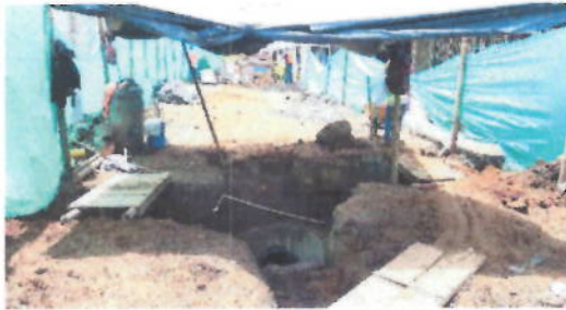
Imagen 1 Calle 4A entre carrera 8 y 9 (10 Oct – 2019)
