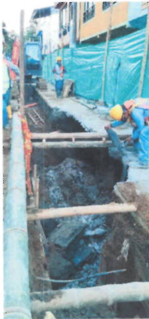
Imagen 7 Calle 4A entre carrera 8 y 9 (22 Oct – 2019)
