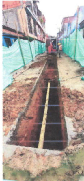
Imagen 6 Calle 3B entre carreras 8 y 7 (21 sept - 2019)
