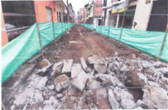
Imagen 17 Carrera 9 entre calle 7 y calle 8 (23 sept – 2019)
