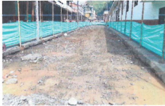
Imagen 21 Carrera 6 entre calle 8 y calle 9 (26 sept - 2019)
