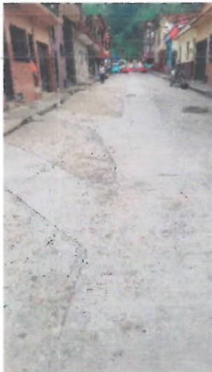
Imagen 7 Carrera 9 entre Calle 6 y 5 (14 Dic – 2019)
