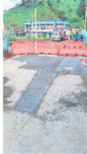
Imagen 6 Carrera 9 entre Calle 6 y 5 (13 Dic – 2019)
