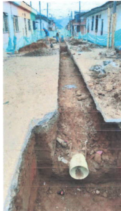
Imagen 20 Calle entre carreras 7y 6 (17 Dic – 2019)
