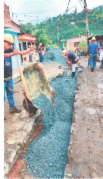
Imagen 10 Barrio el Túnel (12 Nov – 2019)
