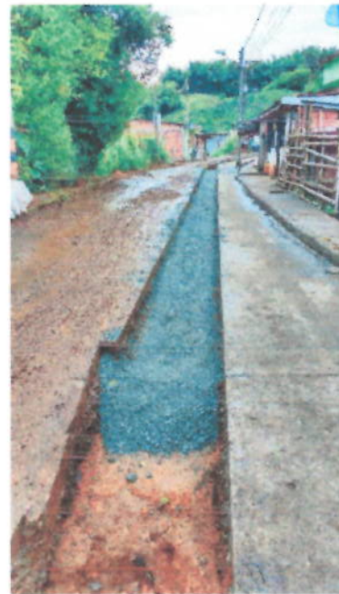
Imagen 12 Barrio el Túnel (14 Dic – 2019)
