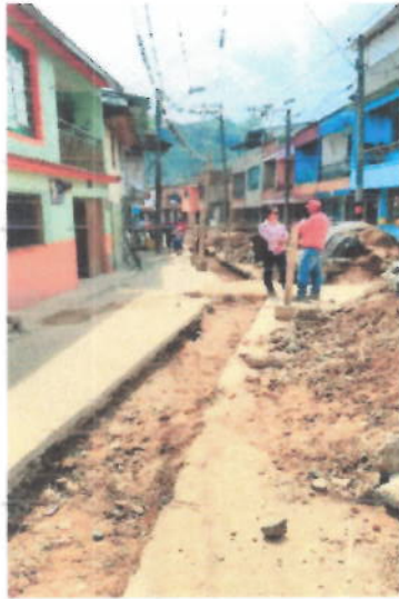
Imagen 9 Barrio el Túnel (10 Dic – 2019)
