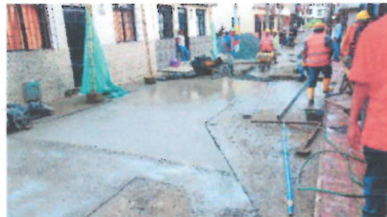
Imagen 4 Calle 3B entre carrera 8 y 7 (17 Dic – 2019)
