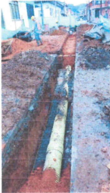
Imagen 17 Calle entre carreras 7y 6 (12 Dic – 2019)
