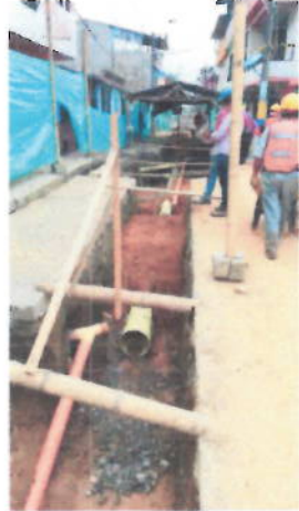
Imagen 1 Calle 3B entre carrera 8 y 7 (10 Dic – 2019)
