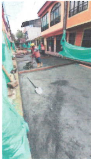
Imagen 3 Calle 3B entre carrera 8 y 7 (13 Dic – 2019)
