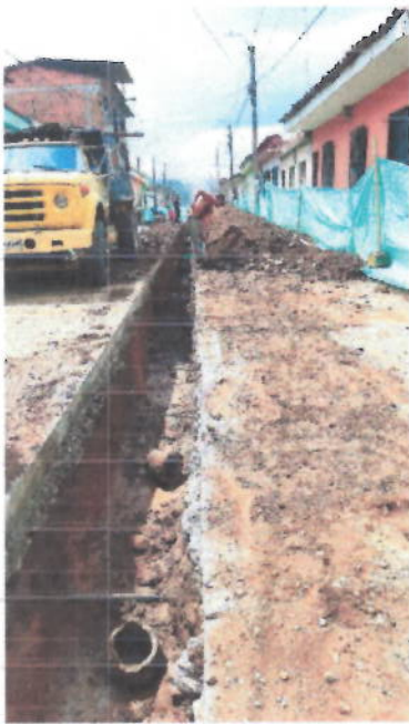
Imagen 19 Calle entre carreras 7y 6 (13 Dic – 2019)
