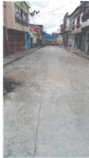
Imagen 8 Carrera 9 entre Calle 6 y 5 (14 Dic – 2019)
