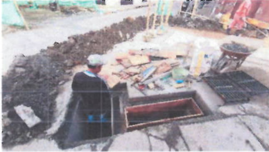
Imagen 5 Carrera 9 entre Calle 6 y 5 (13 Dic – 2019)
