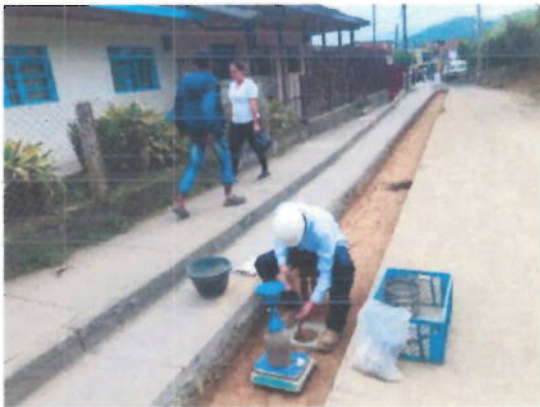
Imagen 11 Barrio el Túnel (12 Dic – 2019)
