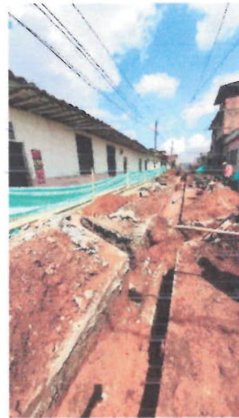
Imagen 18 Calle entre carreras 7y 6 (13 Dic – 2019)
