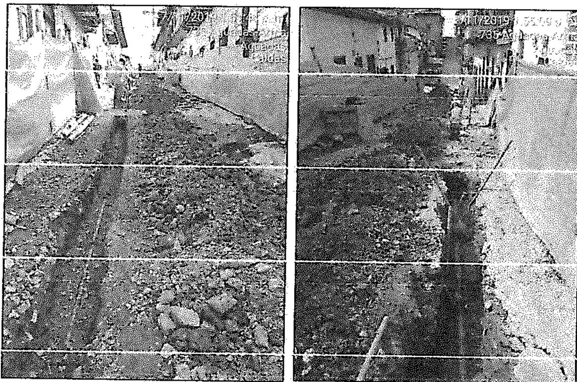
(excavaciones para instalación de tubería PVC de 2")
