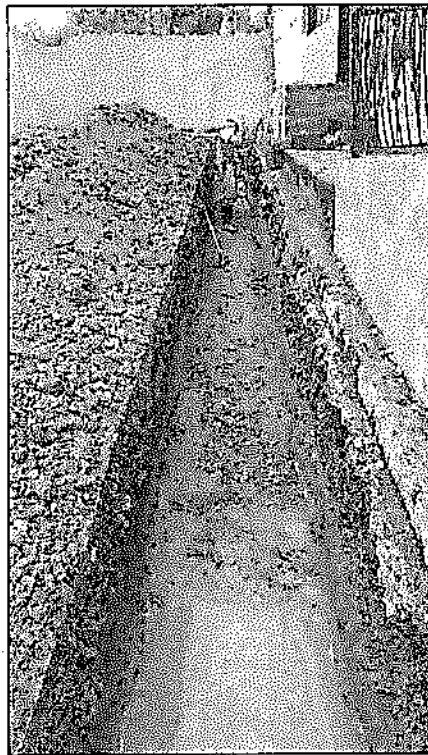
(excavación en material común)
