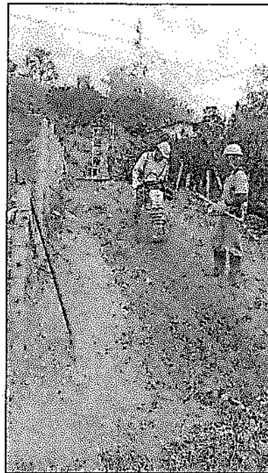
(instalación tubería, entibado y compactación con canguro mecánico)
