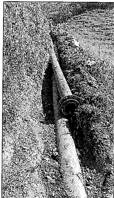
(inicio de recubrimiento y punto de empalme inferior)
