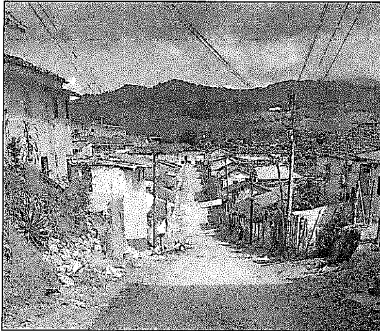
(inicio de cerramiento con postes de guadua)
