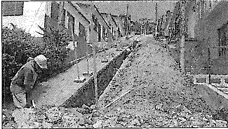
(excavaciones en material común)
