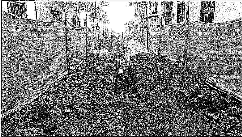
(inicio de excavaciones en material común)
