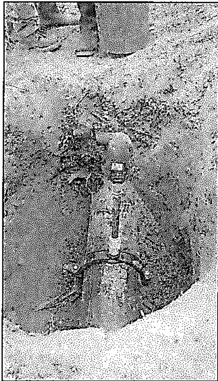
(instalación de ventosa)
