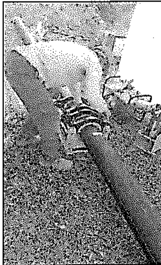
(termofusión de la tubería)
