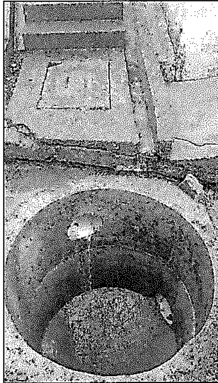
(empalme de caja de inspección a cámara)
