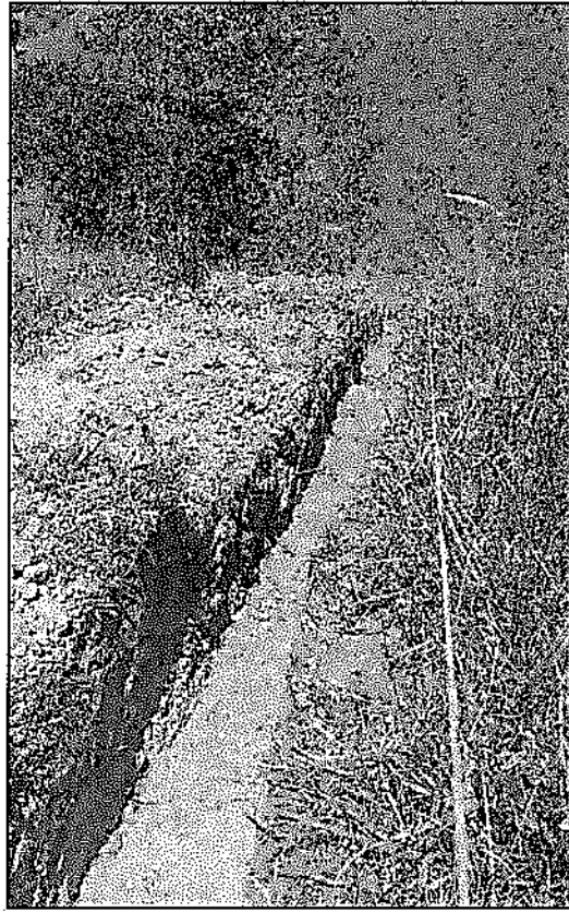
(excavación de zanja)
