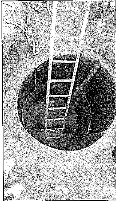
(cámaras de 120 cm de diámetro y refuerzo para losas sobre las cámaras)
