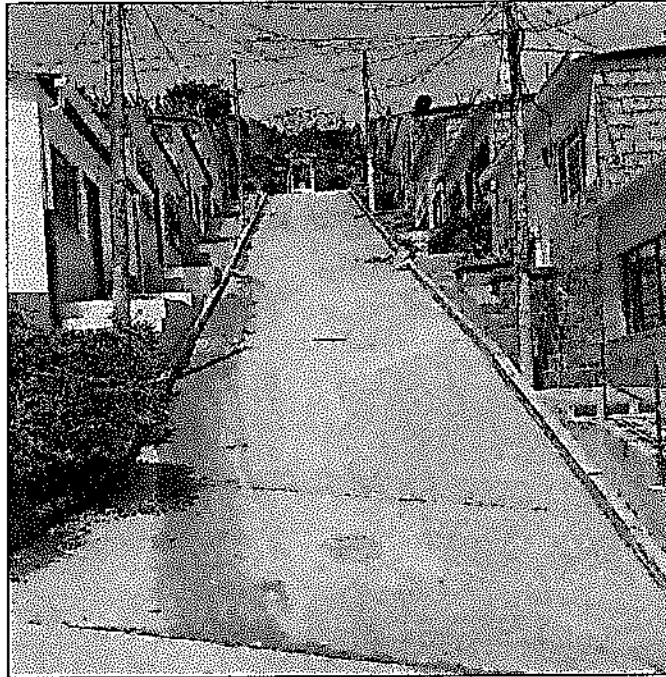
(vaciado de concreto y limpieza del sector)
