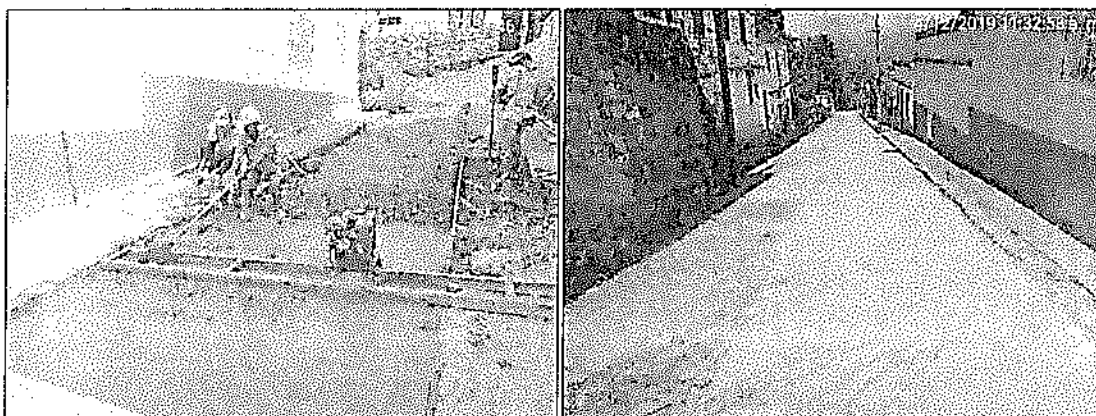
(pavimentación y estado final de la obra)
