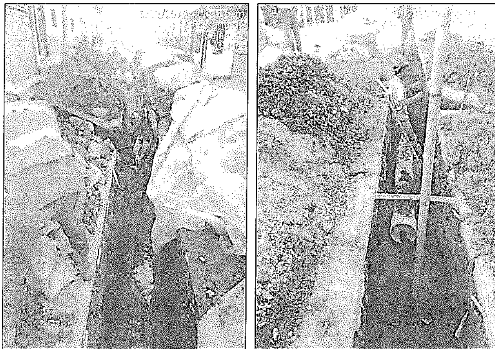
(demoliciones con martillo mecánico e instalación de tuberías)
