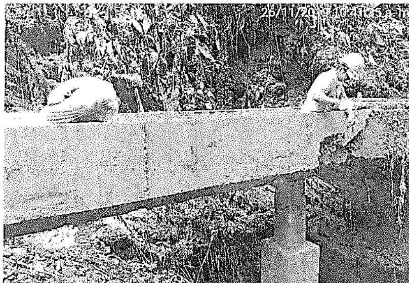
(reparaciones en canal de conducción)
