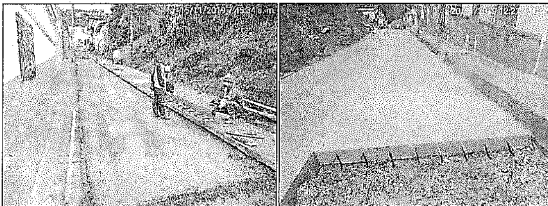
(pavimentación con concreto rígido de 18 cm de espesor)
