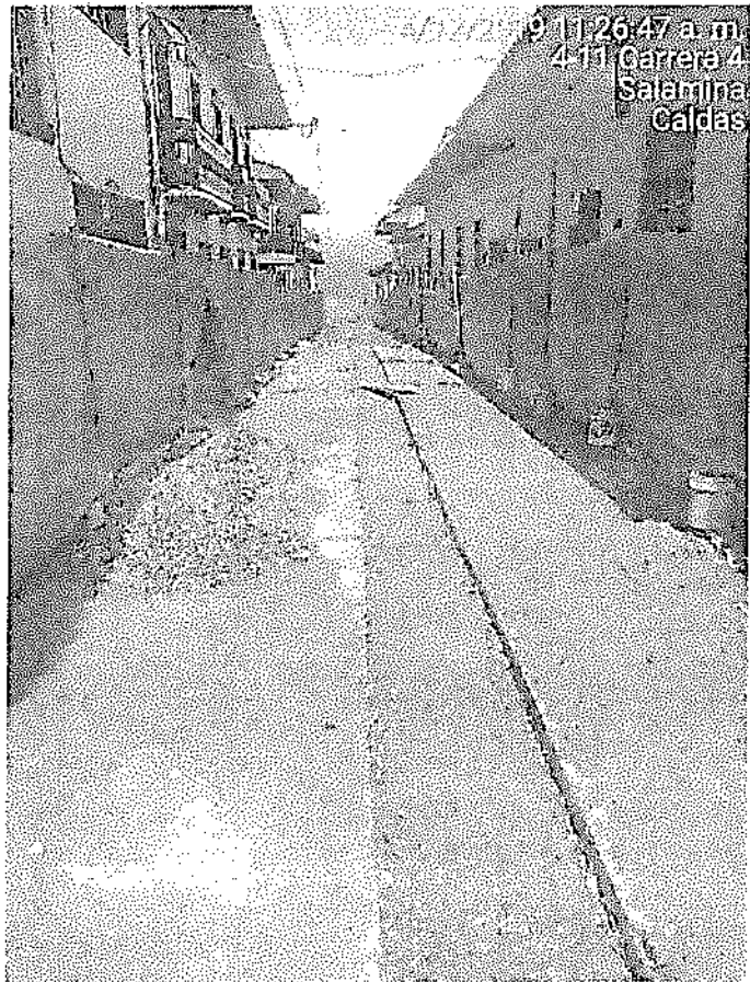
(estado actual del tramo)
