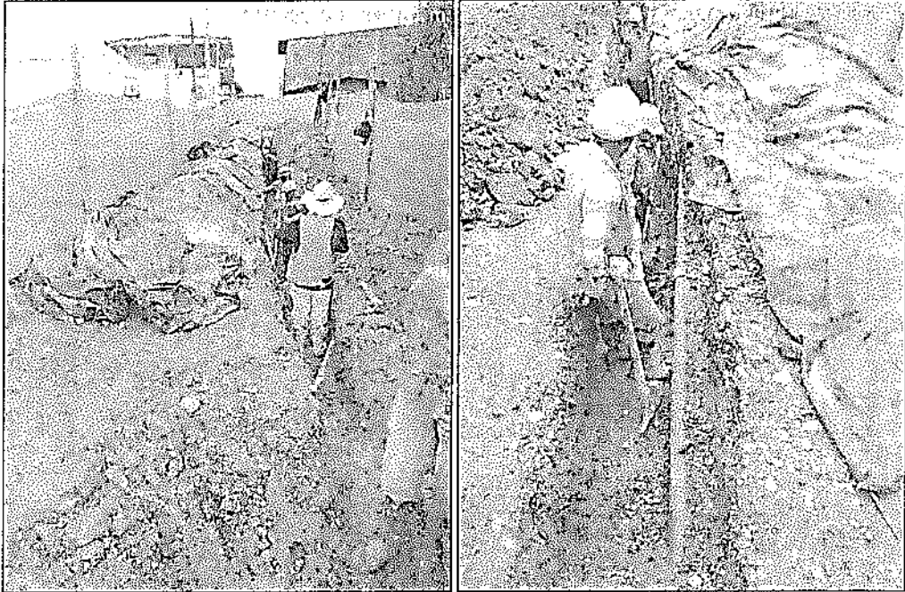
(excavaciones para instalación de tuberías)
