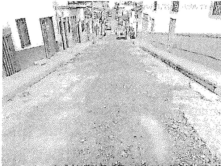
(estado actual de la obra)
