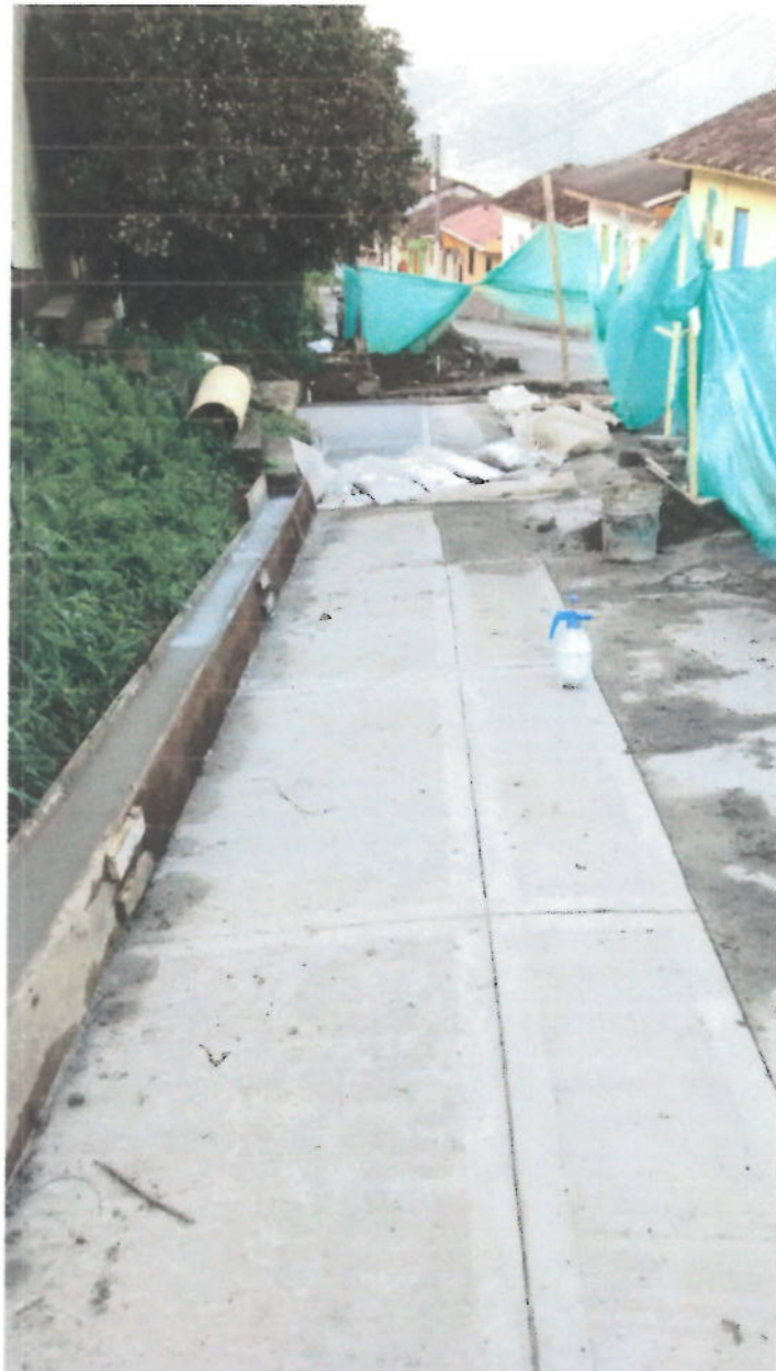
Reposición de alcantarillado Carrera 8 con calle 15 (La cuchilla)
