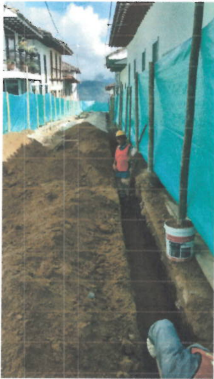
Reposición de acueducto y alcantarillado Carrera 7 con calles 3 y 4 (Parque)
