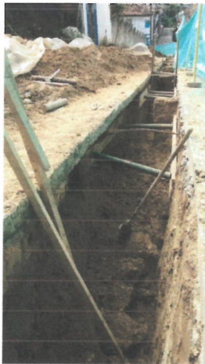
Reposicion de Alcantarillado Carrera 5 entre calles 6 y 7 (Palenque)
