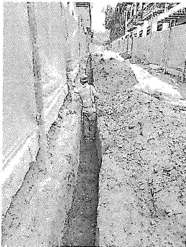
(instalación de tubería pvc de 3")
