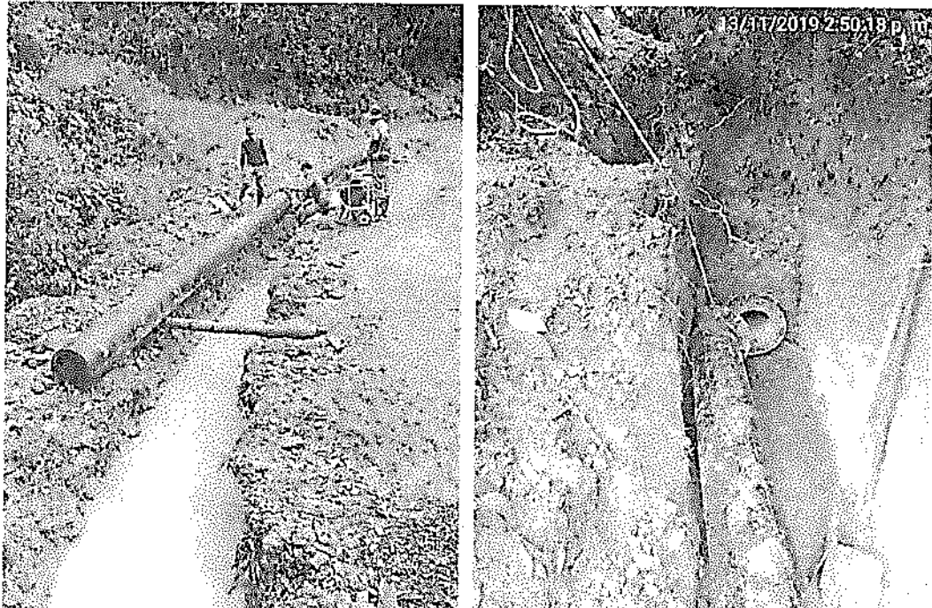
(reposición tubería – sector Boquerón)
