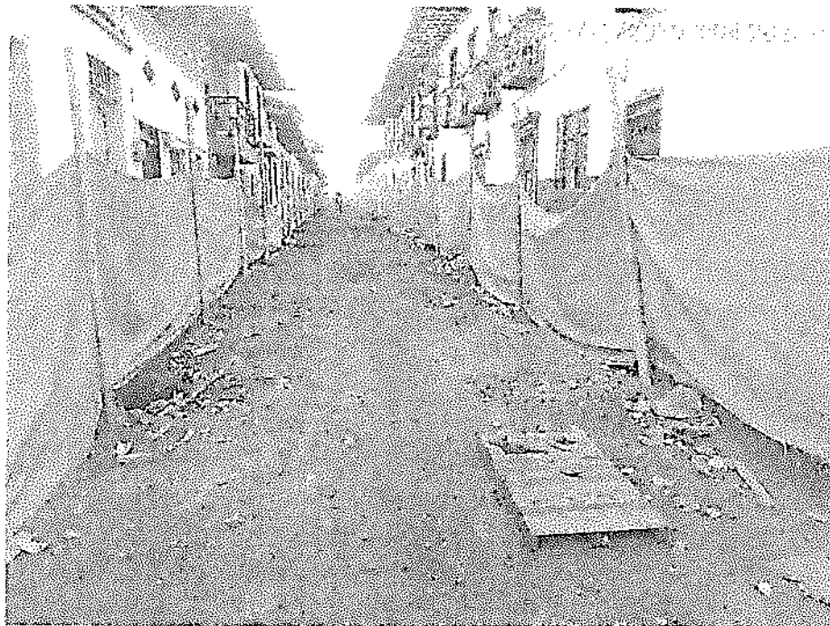
(estado actual de la obra)
