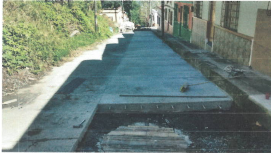
Reposición red de acueducto y alcantarillado Carrera 6ª con calles 1 y 2 (Fundadores)
