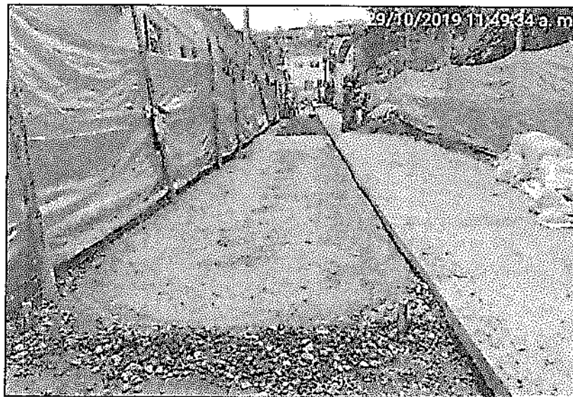
(nivelación y compactación de sub-base para pavimento)
