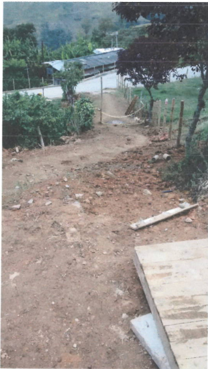
Reposición de Alcantarillado vía al Matadero
