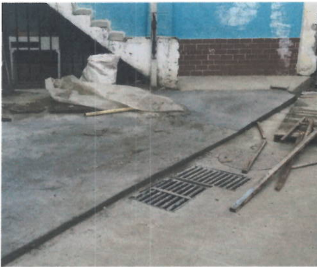
CONSTRUCCION DE SUMIDERO
