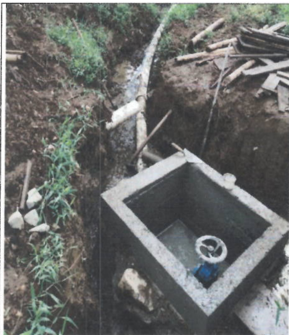
Caja válvula de lavado
