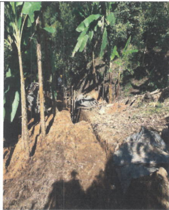
Excavación para instalación tubería
