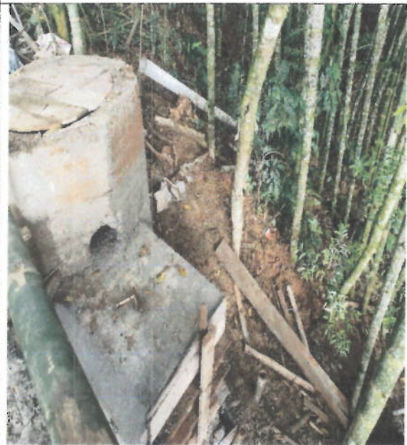
Cámara de caída y base caisson para viaducto
