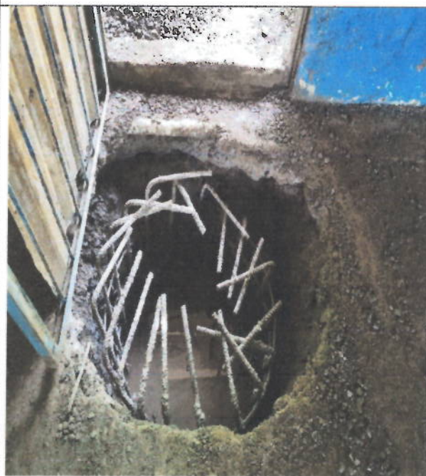
Caisson y construcción pedestal
