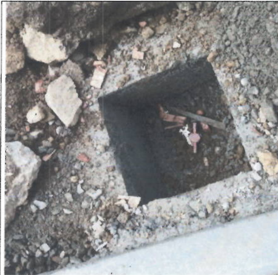
Caja para válvula de control
