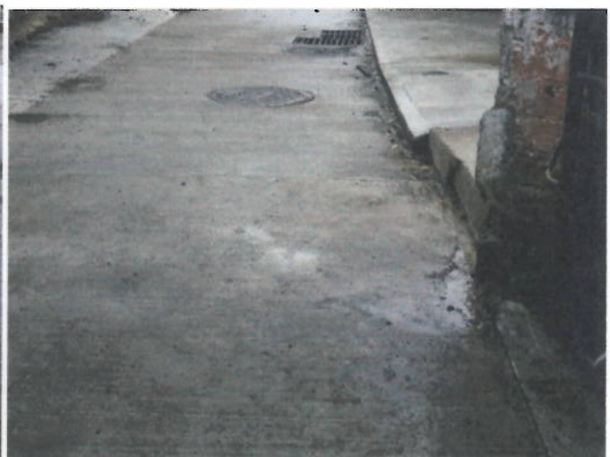
CONSTRUCCION DE SENDERO VEHICULAR Y ANDENES
