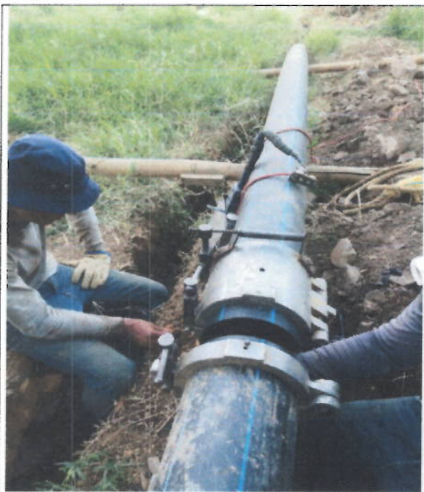
Termofusión tubería PN 8"
