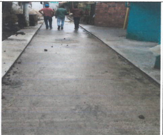
Obra terminada (sendero vehicular y peatonal)
