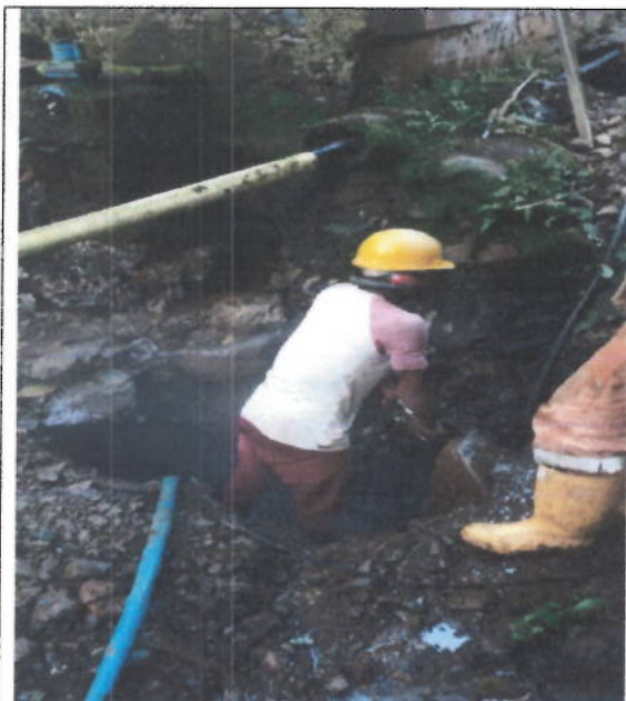
Excavación caissons
