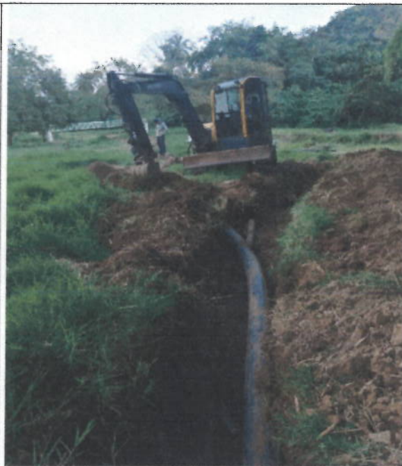
Excavación para instalación tubería PN 8"
