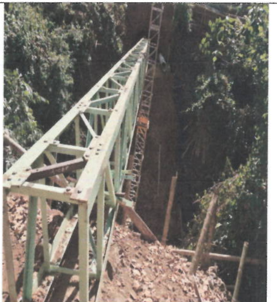
Instalación viaducto metálico
