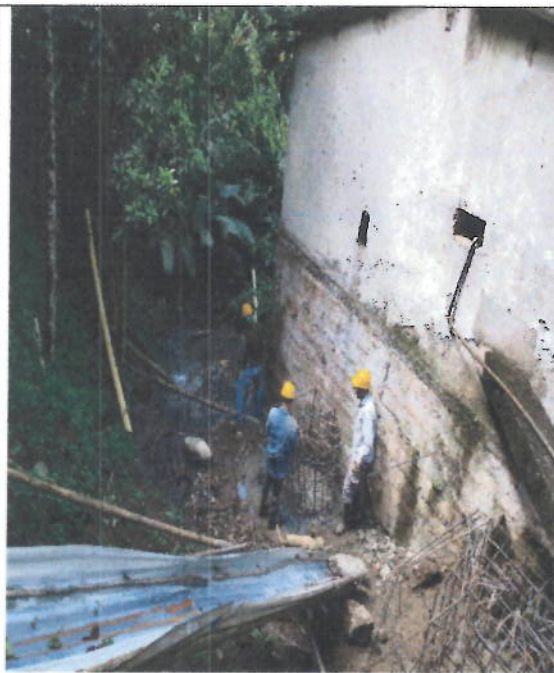
Armado acero de refuerzo pedestales
