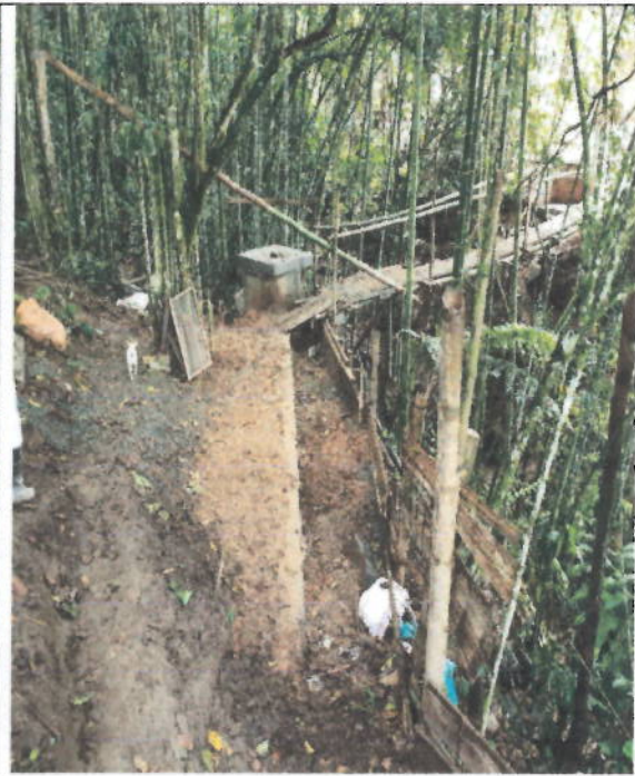
Construcción viga para recubrimiento tubería
