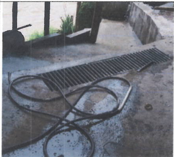
Construcción sumidero transversal
