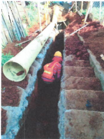
Imagen 11 Calle 26 entre carrera 3e y carrera 4e (08-nov-2019)
