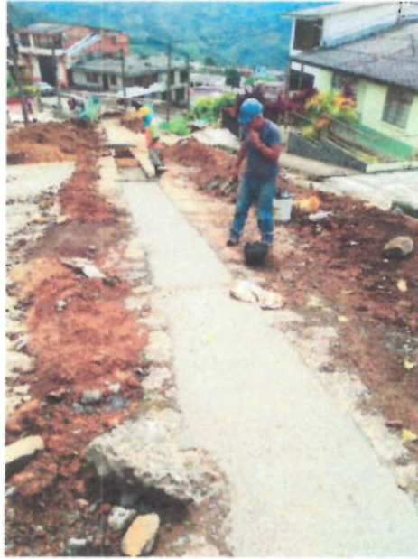
Imagen 13 Calle 24 entre carreras 3 y 4 (29 oct – 2019)
