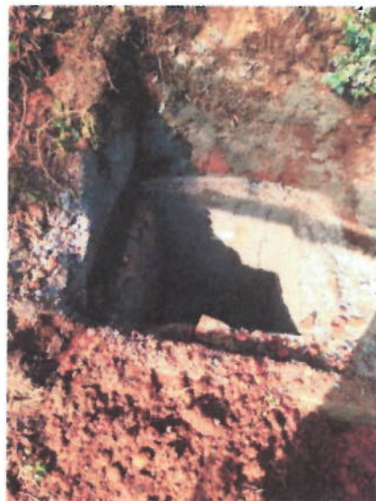
Imagen 12 Calle 26 entre carrera 3e y carrera 4e (08 nov - 2019)
