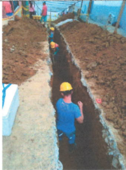
Imagen 7 Calle 11 entre carrera 2 y 3 (17 dic – 2019)
