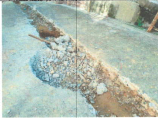
Imagen 4 Calle 11 entre carrera 2 y 3 (9 dic- 2019)
