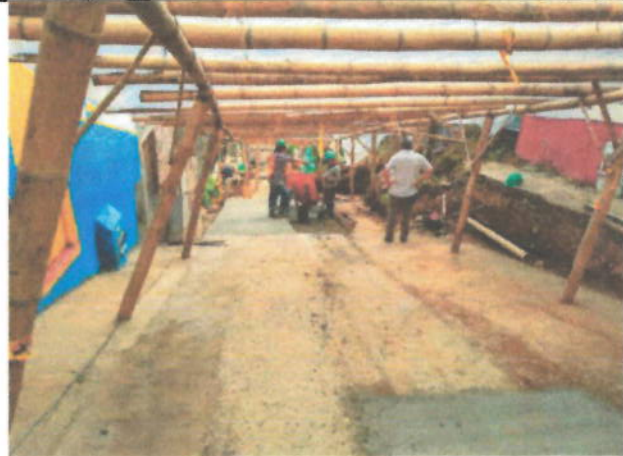
Imagen 2 Calle 3 entre carrera 2 y 3 (11 dic - 2019)
