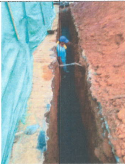
Imagen 6 Calle 11 entre carrera 2 y 3 (13 dic – 2019)
