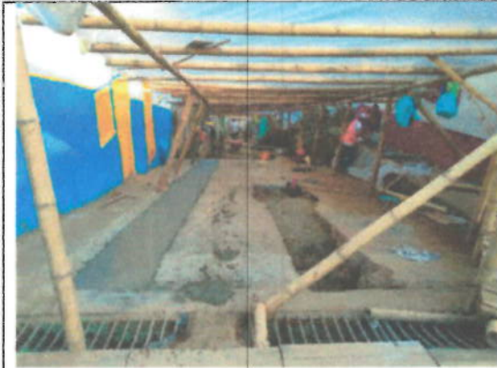
Imagen 1 Calle 3 entre carrera 2 y 3 (9 dic-2019)
