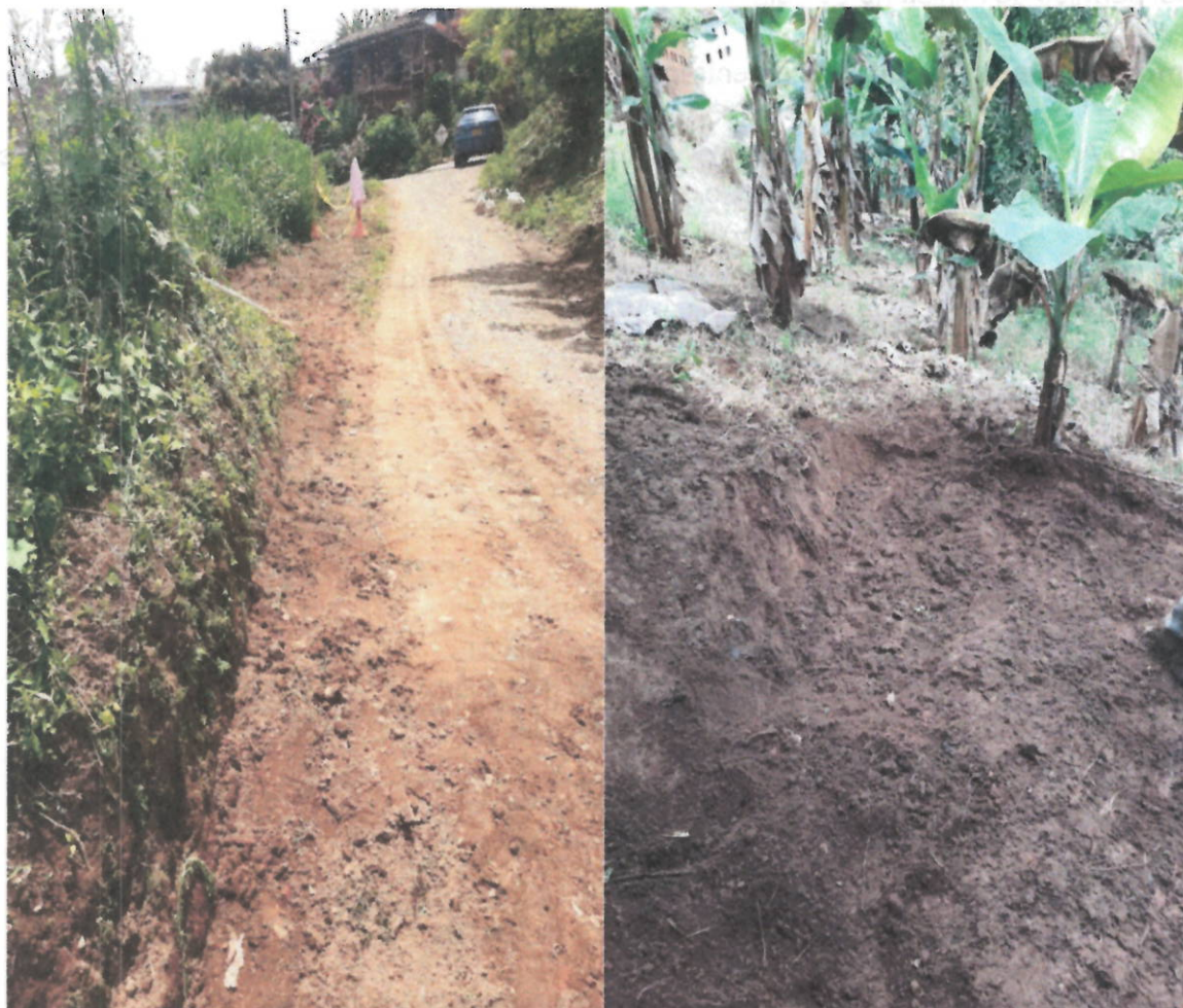
Terminado Sobre vía veredal
