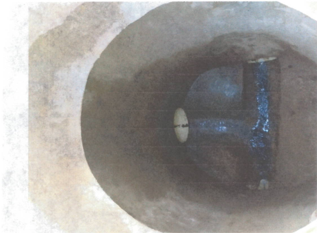
Empalme a cámara existente y cañuela
