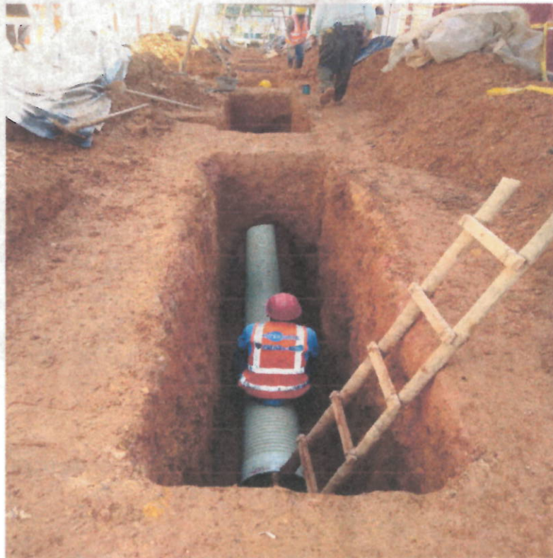
Instalación tubería red principal 14' novafort
