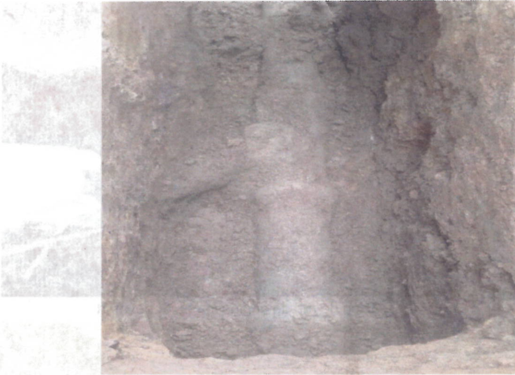
Tubería existente encontrada, demolida y evacuada 10' concreto
