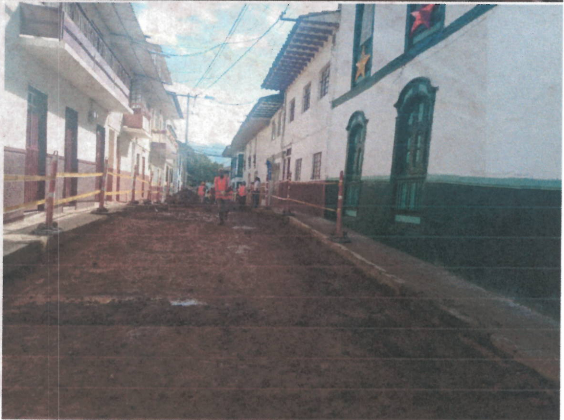
Retiro y evacuación de escombros producto de la demolición
