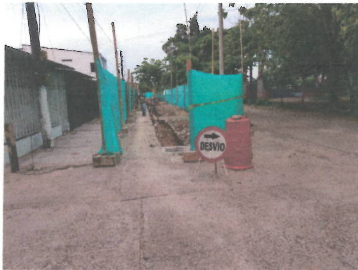
Fotografía No.1 Cerramiento en yute verde con parales en guadua cada dos metros, además de las señales verticales que informan a la comunidad vecina acerca de las obras.
