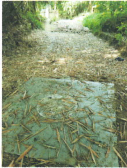
Fotografía 6: Vivero Bucamba, finca el playón, instalación de alcantarillado
