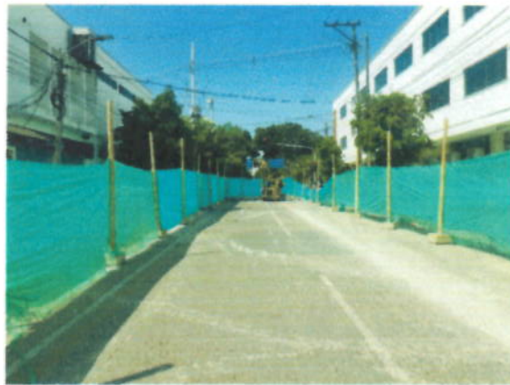
Fotografía 4: Carrera 2 entre calles 12 y 13, reposición de alcantarillado
