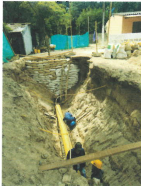
Fotografía 5: Sector clínica Armony, reposición de alcantarillado
