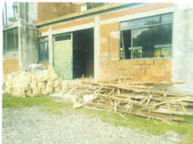
Fotografía 1: Desmonte de cielo raso en la planta el llano
