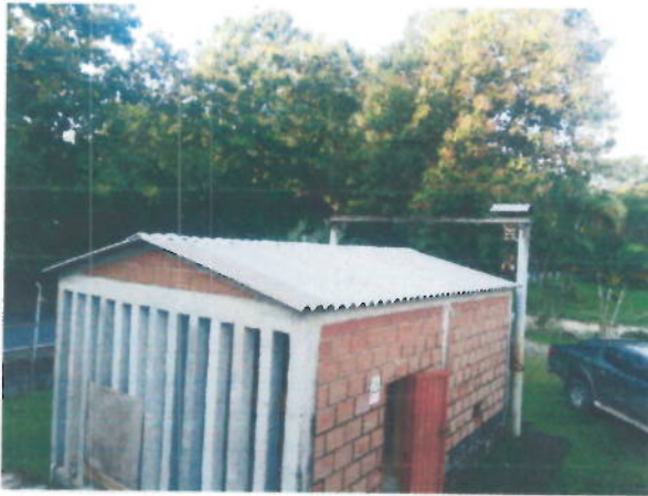
Instalación de cubierta
