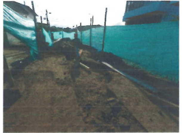
Instalación de tubería principal y domiciliaria
