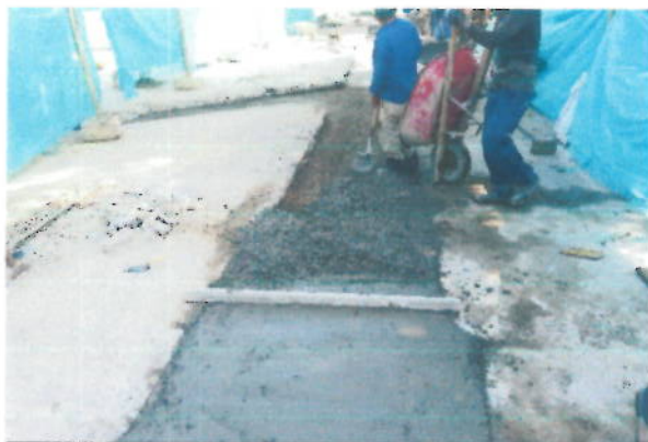
Vaciado de pavimento rígido
