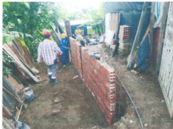
Reposición de muro
