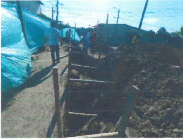
Instalación de entibado
