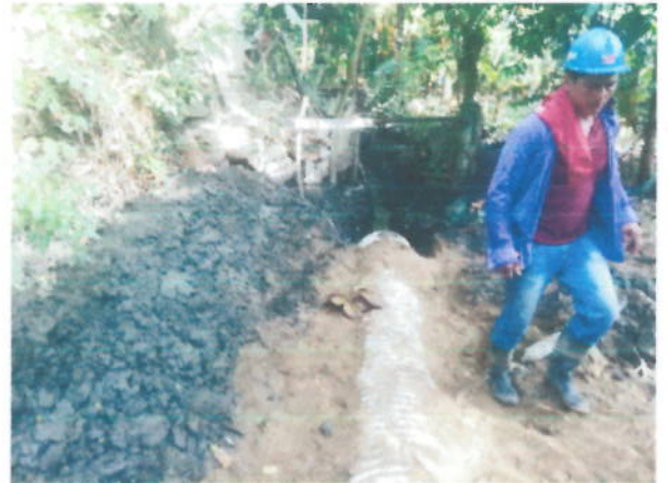
Instalación de tubería de 24"
