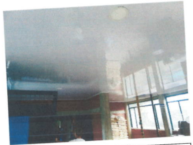
Instalación de cielo raso
