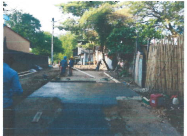
Instalación de losas de concreto
