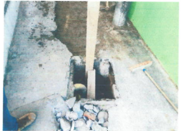
Demolición de concreto existente, identificación de domiciliarias
