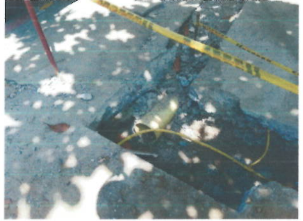
Excavación para sumidero
