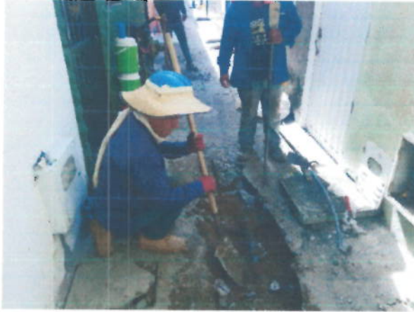
Demolición de concreto existente, identificación de domiciliarias
