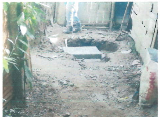
Instalación de cajas
