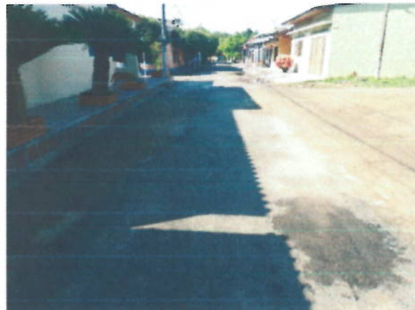
Instalación de mezcla asfáltica.
