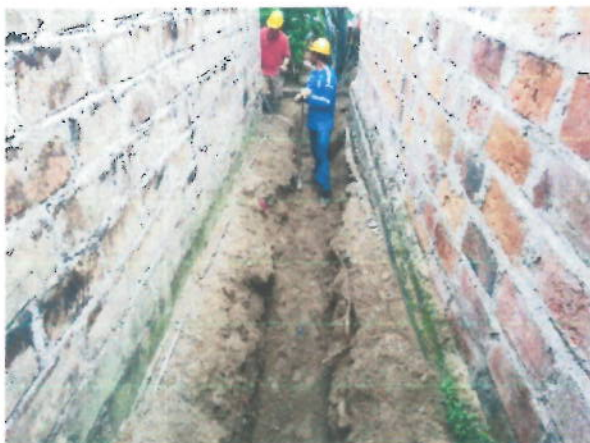
Excavación y demolición
