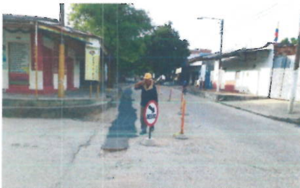
Fundición de franjas en pavimento rígido
