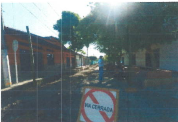
Inicio de demoliciones
