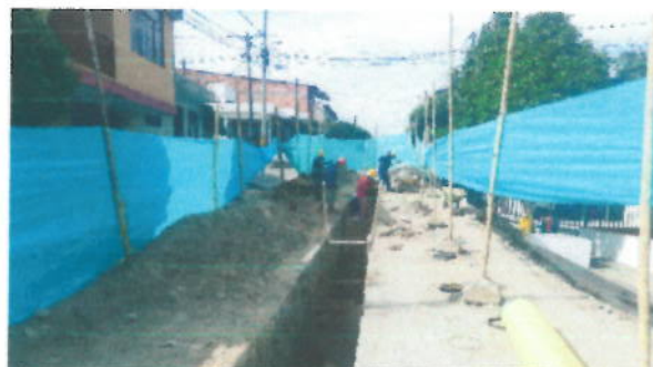
Instalación de tubería de 14"
