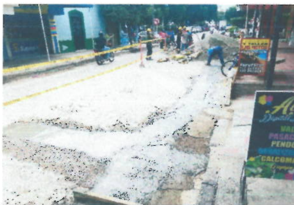
Fundición de franjas en pavimento rígido
