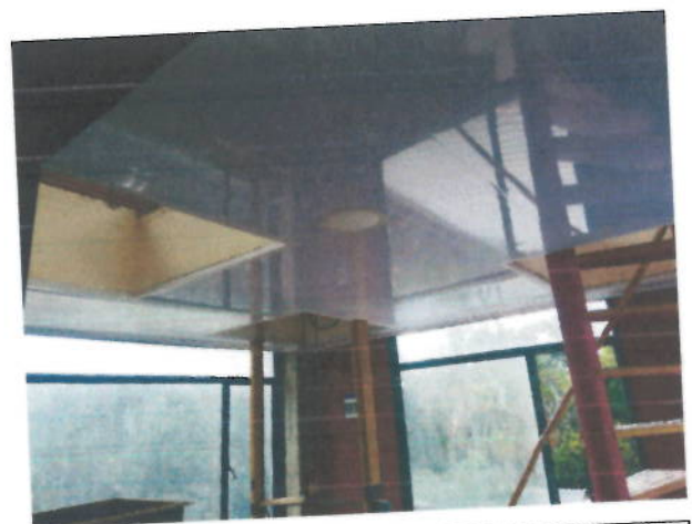
Instalación de cielo raso
