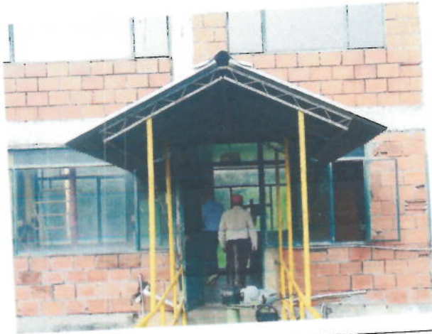
Instalación de cubierta
