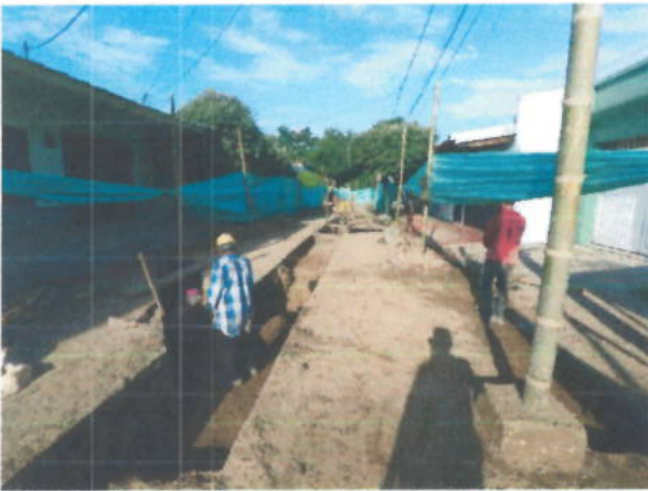
Compactación de material de lleno
