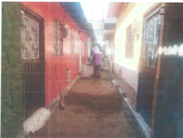
Instalación de afirmado
