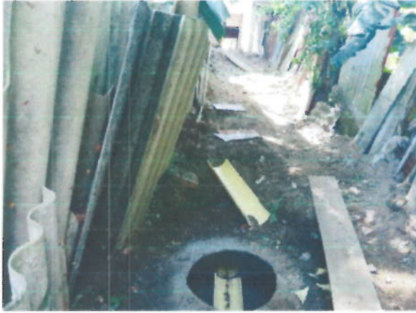
Instalación de cañuelas cámaras trazado imbornal
