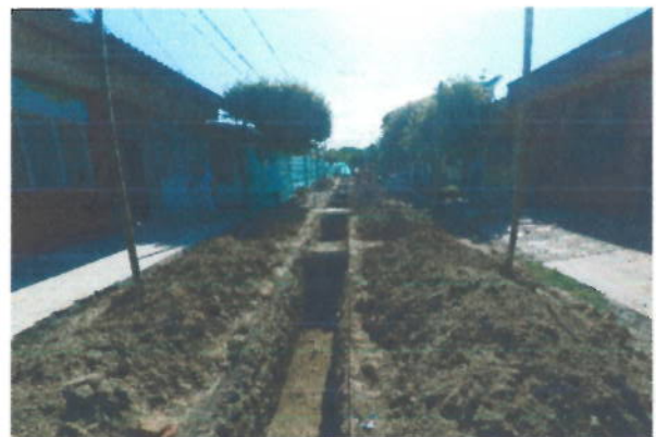
Excavaciones tubería principal
