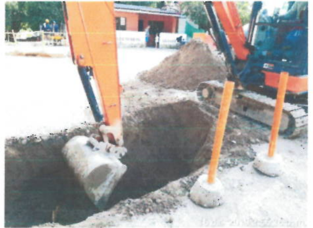
Excavaciones para instalación de tubería
