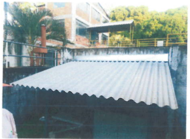
Instalación de cubierta
