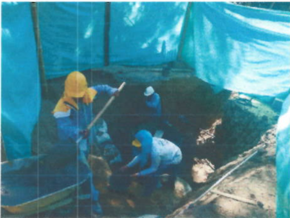
Construcción de cámara
