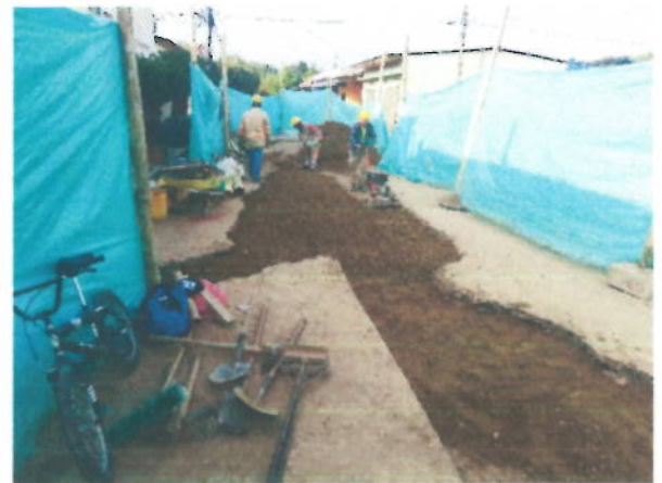
Instalación de sub-base
