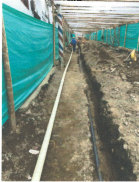
EXCAVACIÓN PARA INSTALACIÓN TUBERIA DE ACUEDUCTO
