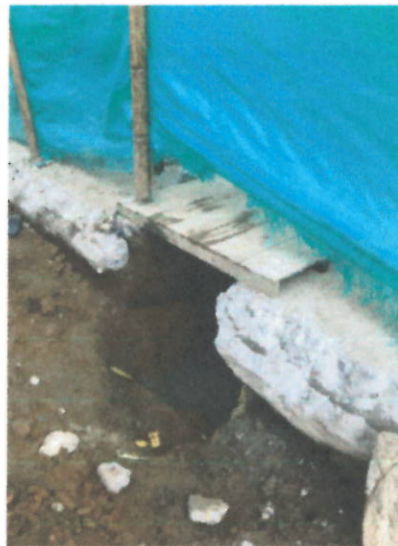
DEMOLICIÓN DE CAJAS EXISTENTES
