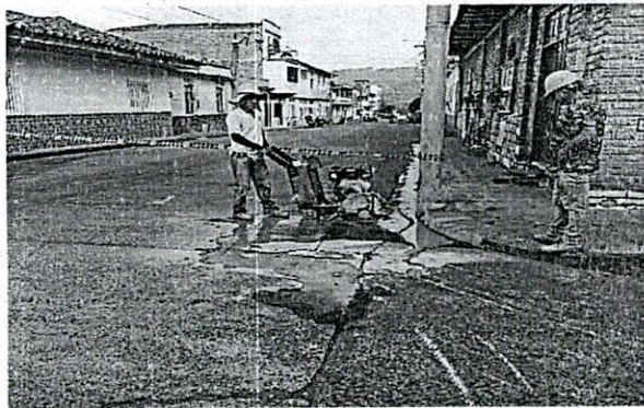
Foto 4: Corte y demolición
