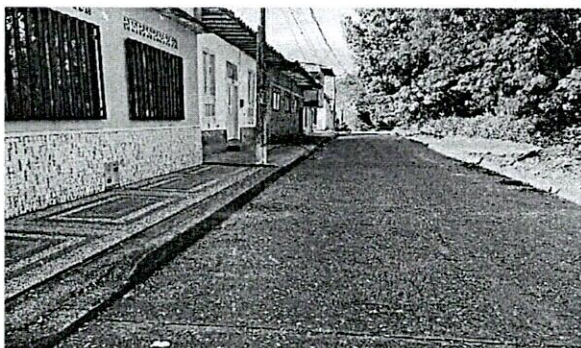
Foto 1: Inicio de las obras
