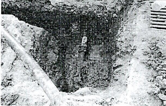
Foto 8: Union de reparacion
