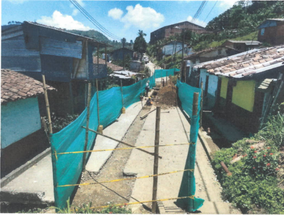
Cerramiento - instalación de señalización - inicio de excavaciones
