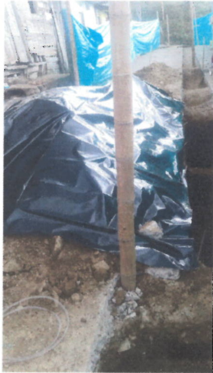
Protección de la tierra de excavación con plástico
