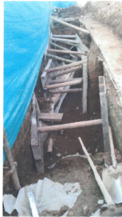
Entibado de tramo excavado
