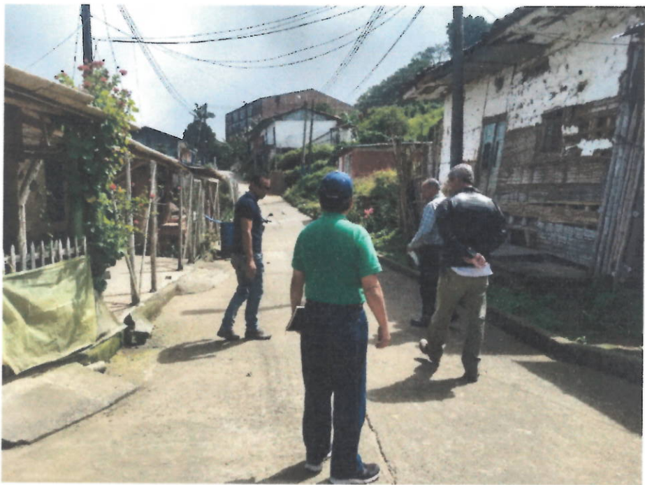
Localización y Replanteo
