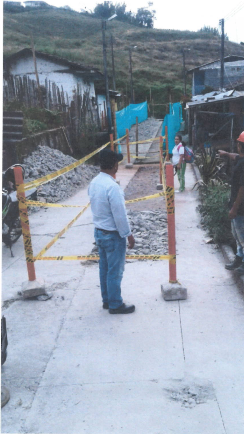
Demolición de pavimento
