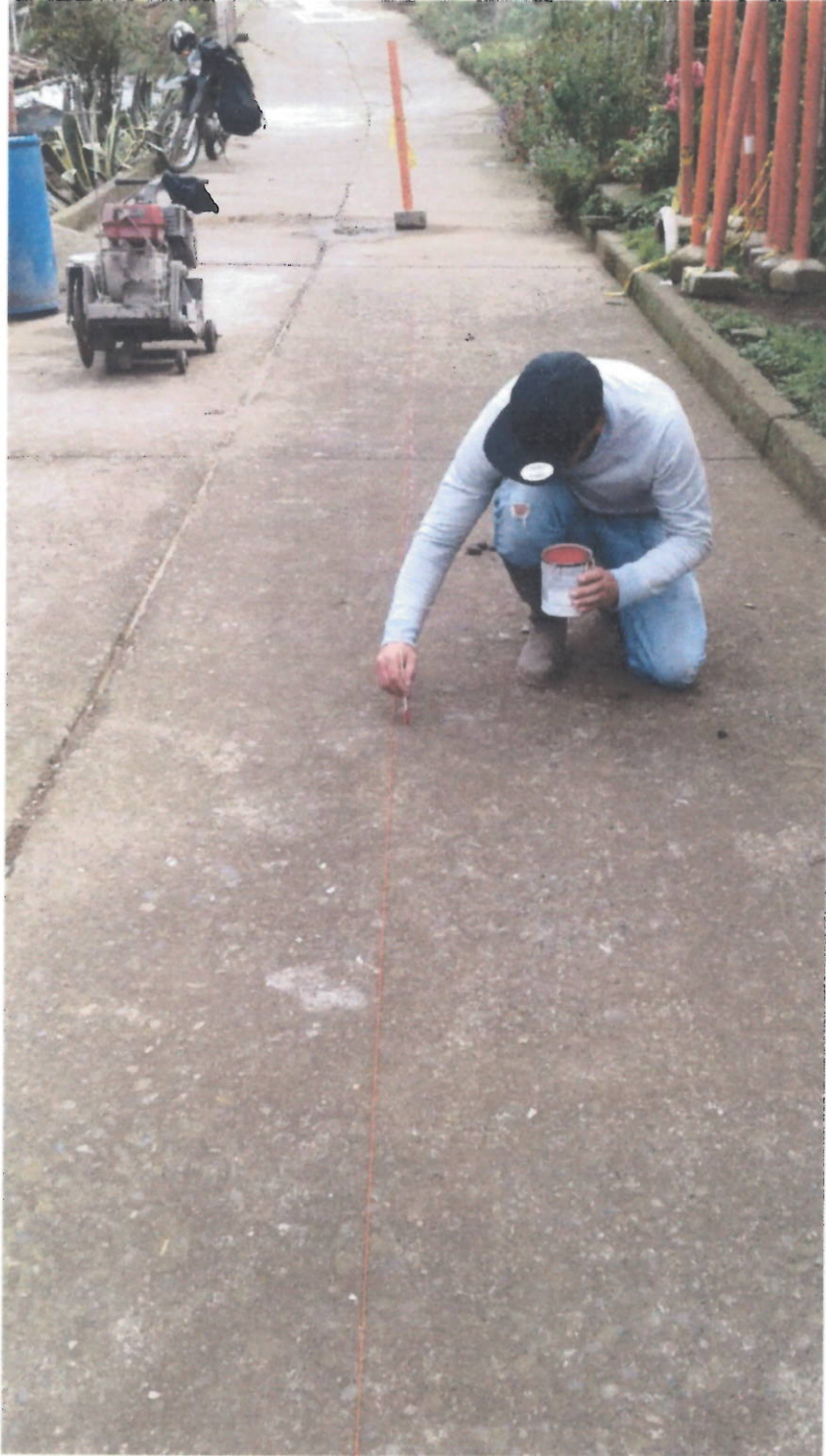
Actividades de corte del pavimento con máquina
