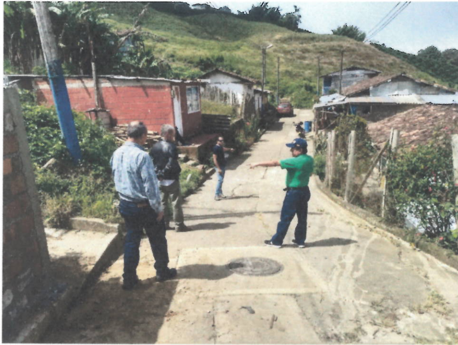
Localización y Replanteo
