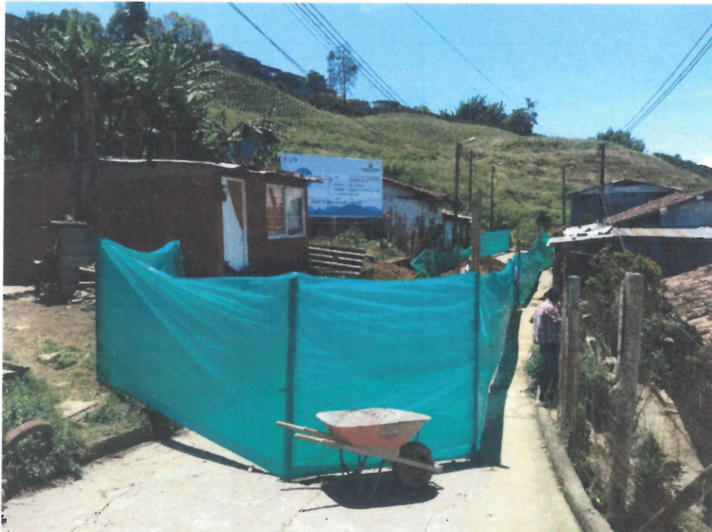
Cerramiento - instalación de señalización - inicio de excavaciones
