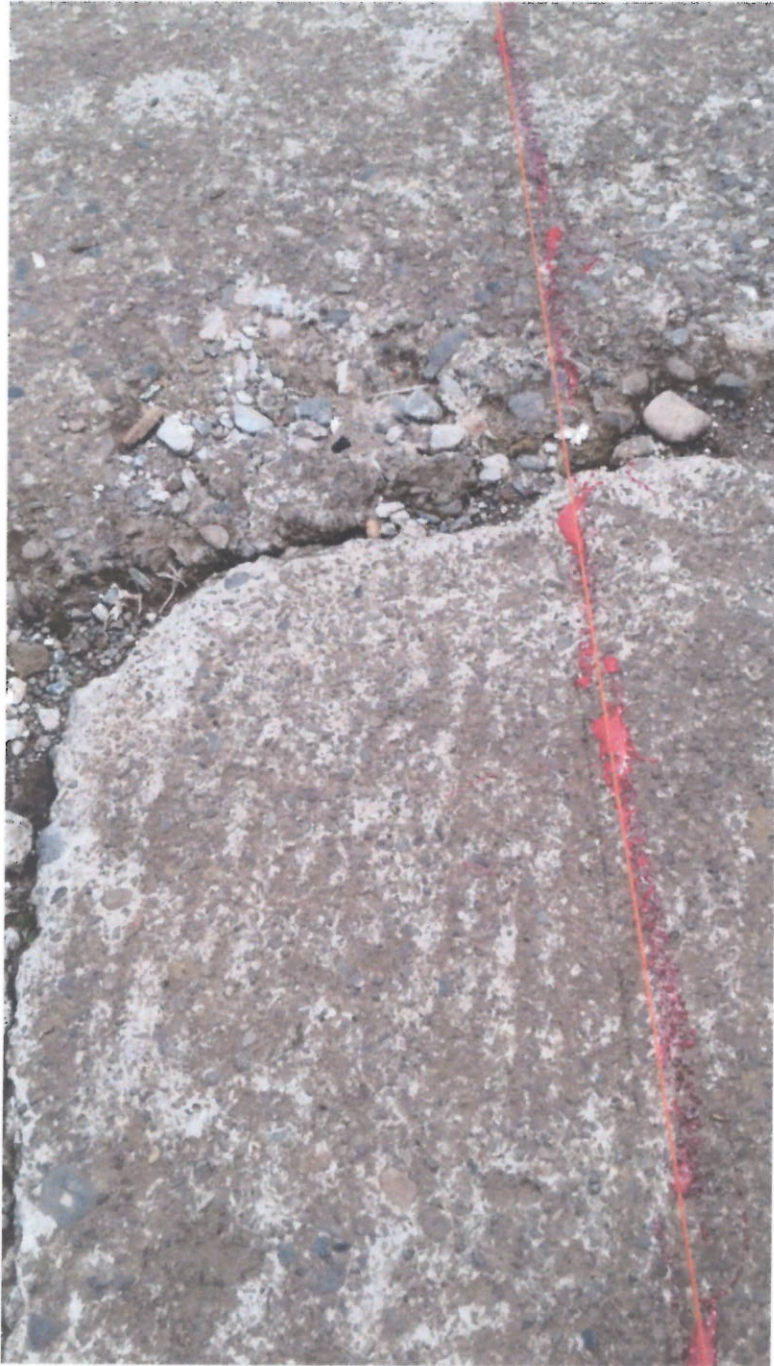
Trazado para corte sobre el pavimento.
