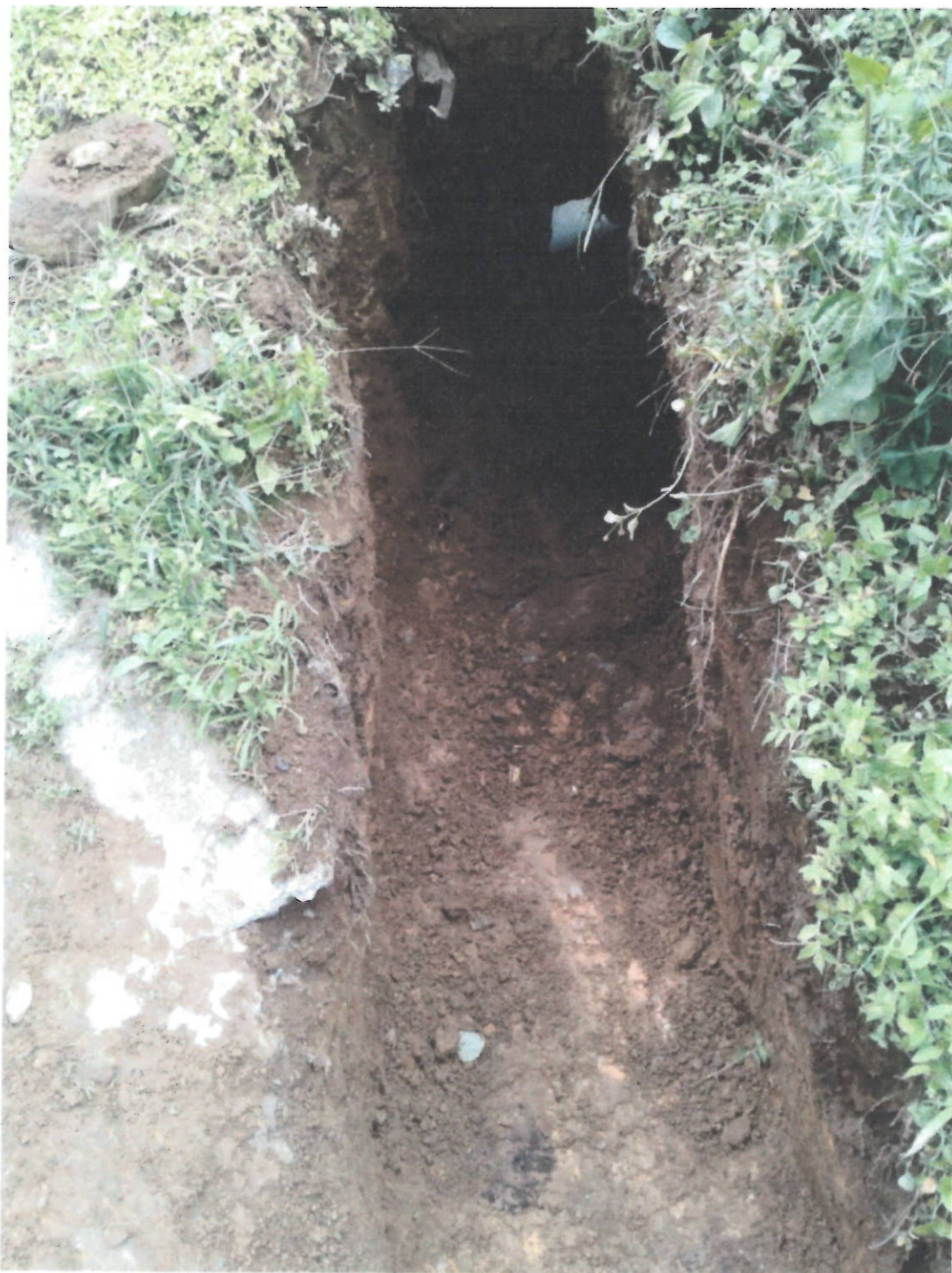
Túnel de alivio realizado por personal del contratista.
