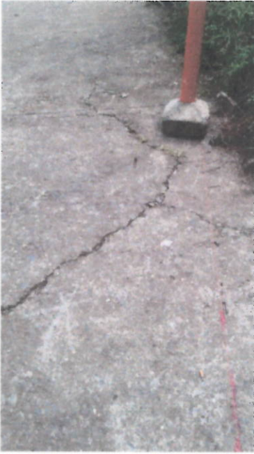
Pavimento que muestra fracturas, este seguramente deberá ser demolido para vaciarlo nuevo
