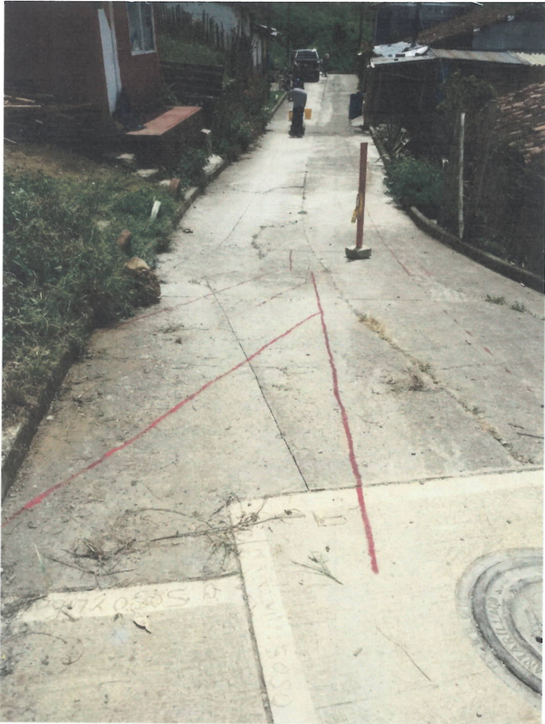
Actividades de corte del pavimento con máquina
