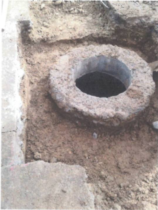
Cuello de cámara de inspección No. 3
