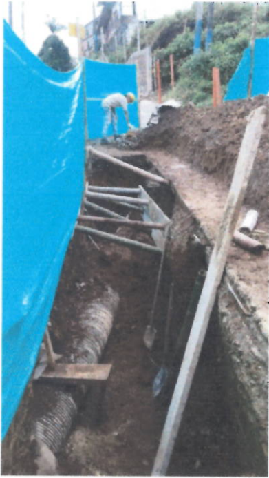
Entibado de tramo excavado
