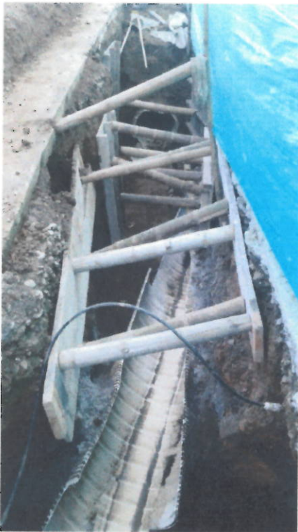
Entibado de tramo excavado
