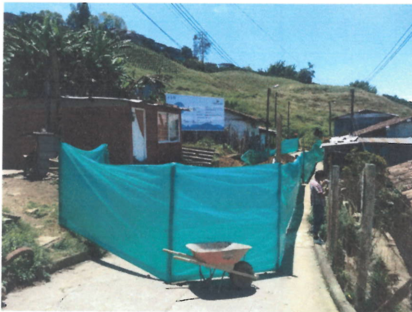
Cerramiento con tela verde con soportes en guadua
