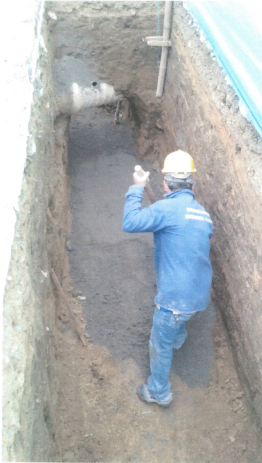
Excavaciones y sustitución en arena limpia para tuberías
