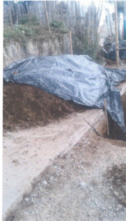
Protección de la tierra de excavación con plástico
