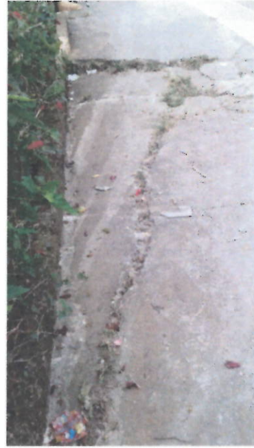
Pavimento que muestra fracturas, este seguramente deberá ser demolido para vaciarlo nuevo
