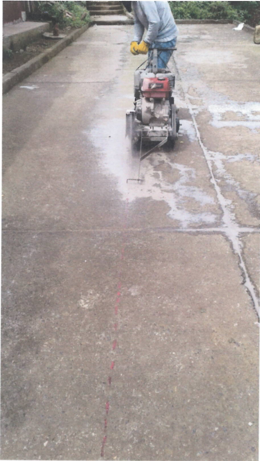
Corte mecanizado de pavimento
