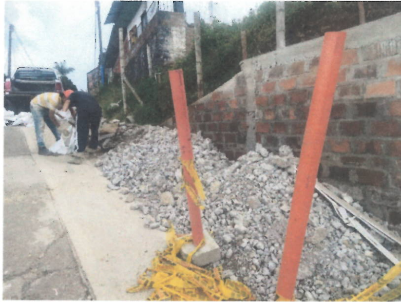
Evacuación de escombros y sobrantes en vehículo automotor
