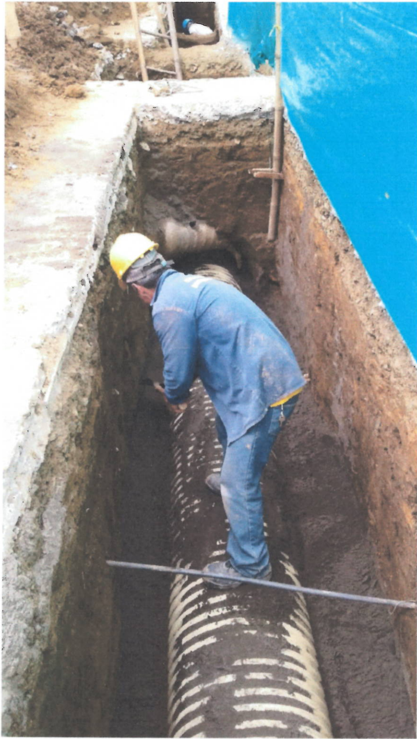
Instalación de tubería PVC corrugada para alcantarillado
