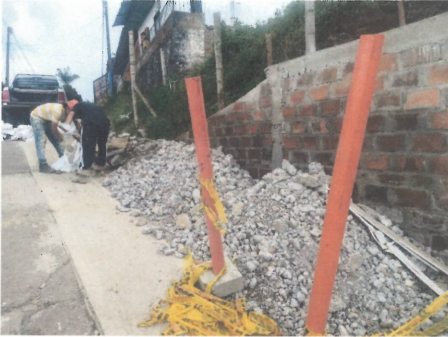
Retiro de escombros
