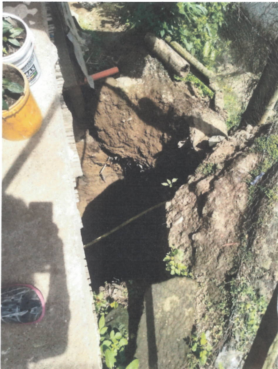
Inspección visual de puntos afectados y con posible riesgo
