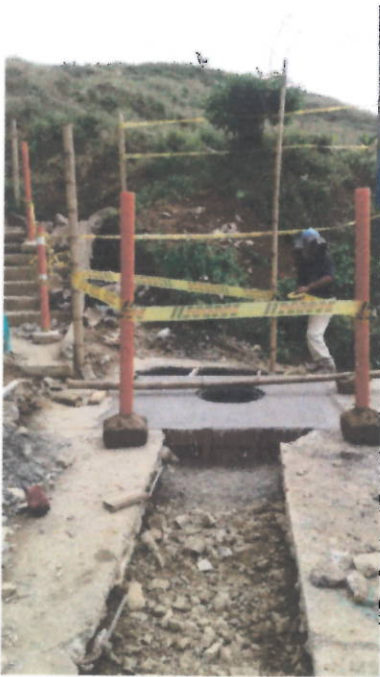
Vaciado de techo de cámara No. 3
