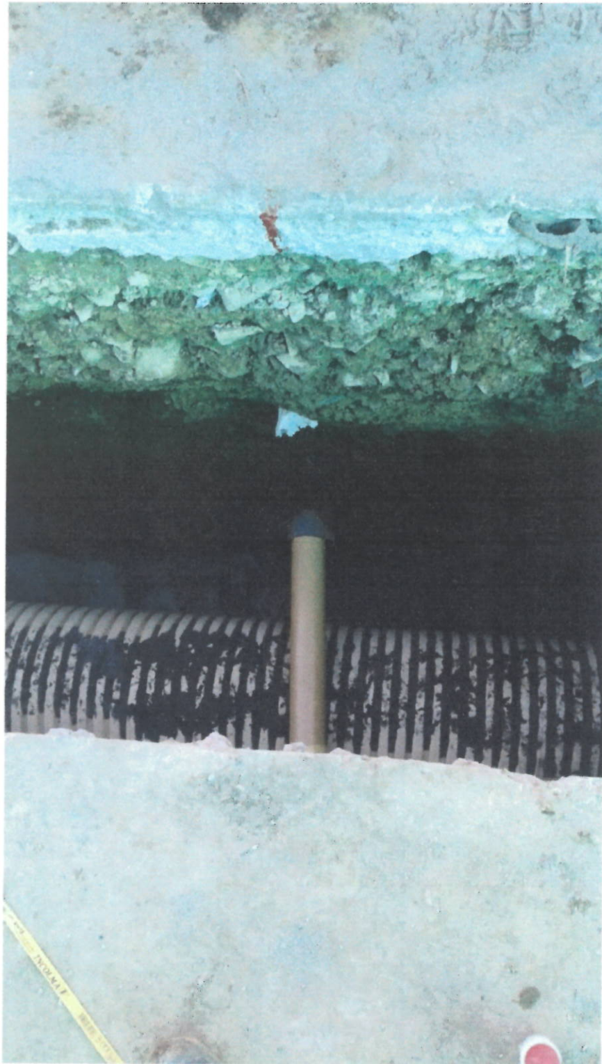
Manejo de aguas durante la instalación de tubería
