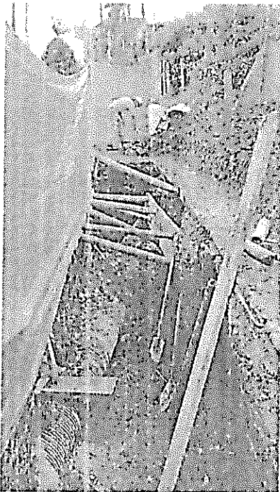
15. Entibado de tramo excavado
