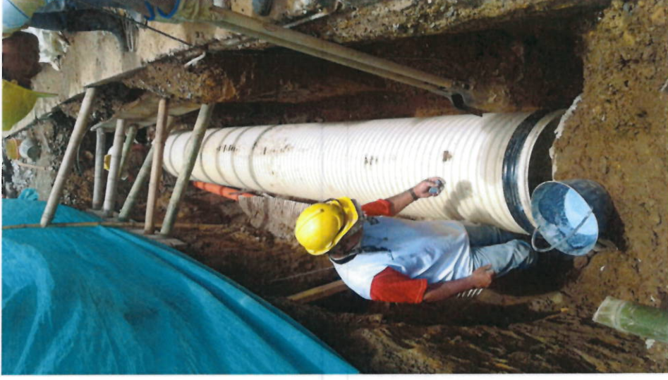
En las fotos arriba se observa el manejo de aguas y la instalación de tubería de 24" en el tramo entre las cámaras 4 y 5 - En la foto abajo izquierda se observa la colocación del refuerzo en el techo de la cámara y abajo derecha se ve la brecha lista para vaciar el pavimento.
