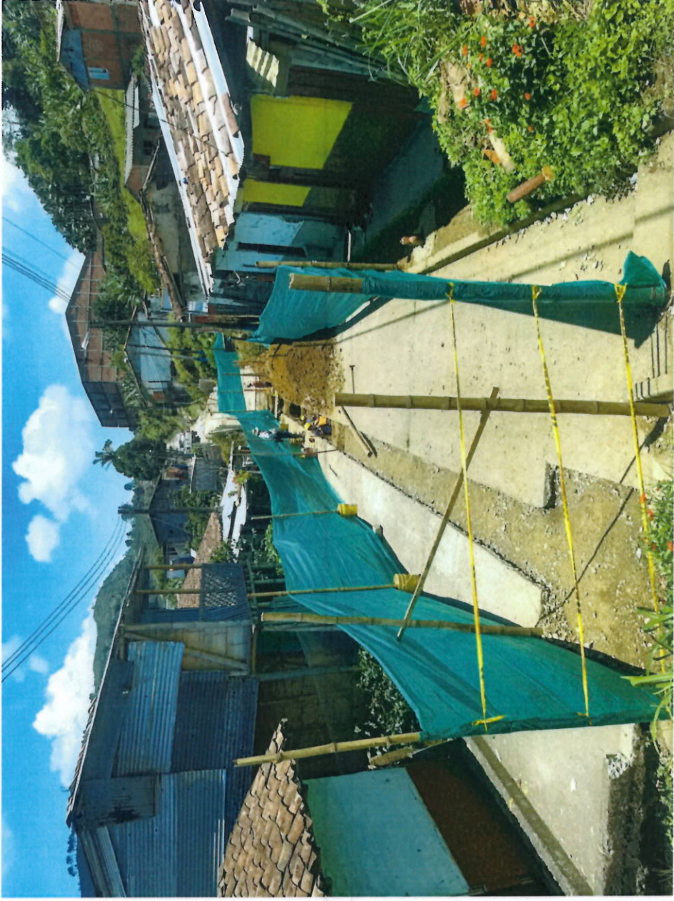
En la foto arriba se observa un adecuado cerramiento de la zona de la obra – En las dos fotos abajo se puede ver que se dejó corredor para la circulación de las personas y el movimiento de las motos.
