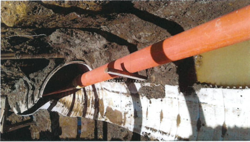
En las fotos arriba se observa el manejo de aguas y la instalación de tubería de 24" en el tramo entre las cámaras 4 y 5 - En la foto abajo izquierda se observa la colocación del refuerzo en el techo de la cámara y abajo derecha se ve la brecha lista para vaciar el pavimento.
