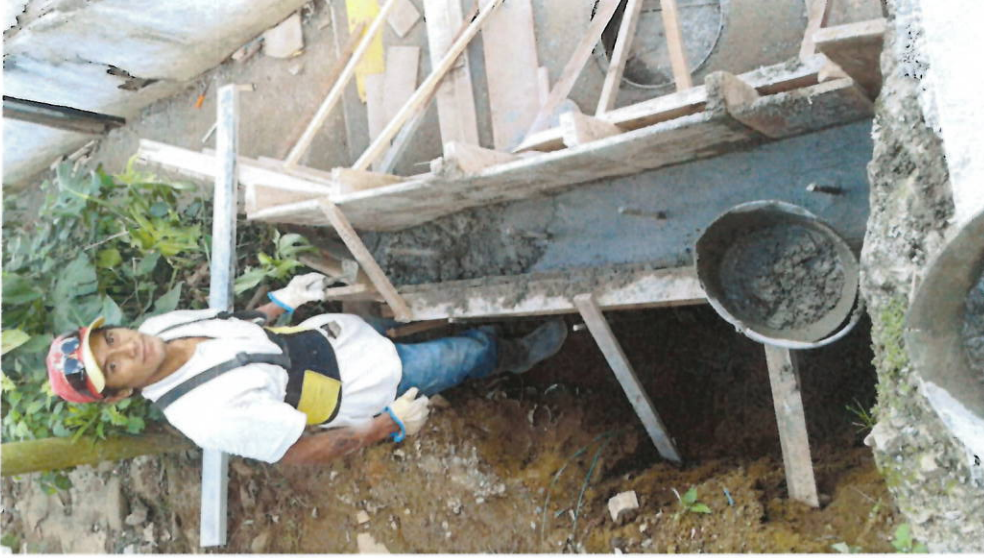
Izquierda Construcción de muro al lado de vivienda afectada por socavaciones - derecha techo de cámara B1
