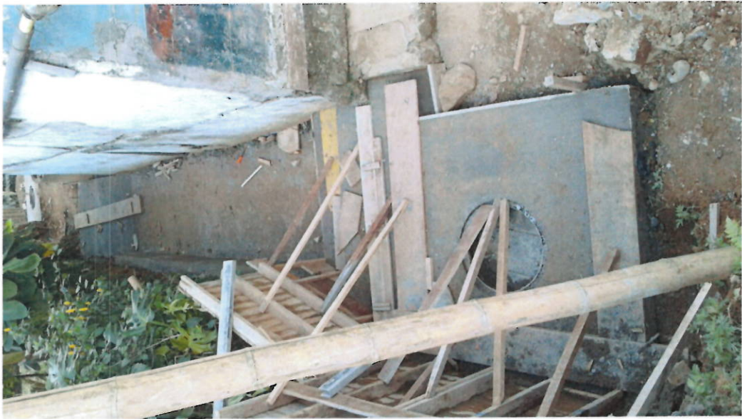
Izquierda Escalas agua abajo de la cámara B1 – Derecha callejón sobre la tubería de 24" cubierto en concreto para protección de la tubería
