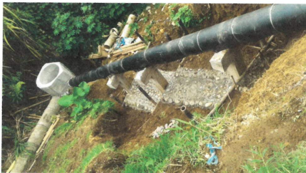
Recubrimiento de piedra pegada en concreto ciclópeo.
