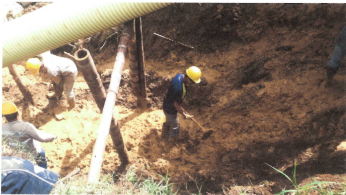
Excavación para zapatas
