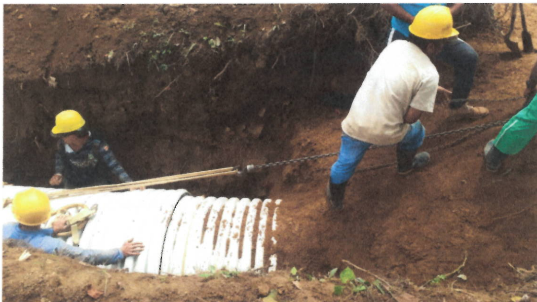
Instalación de tubería
