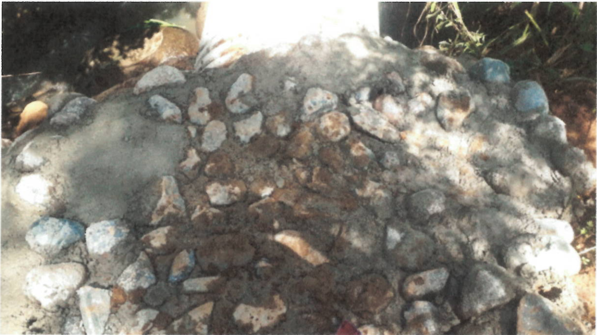
Acabado en concreto ciclópeo
