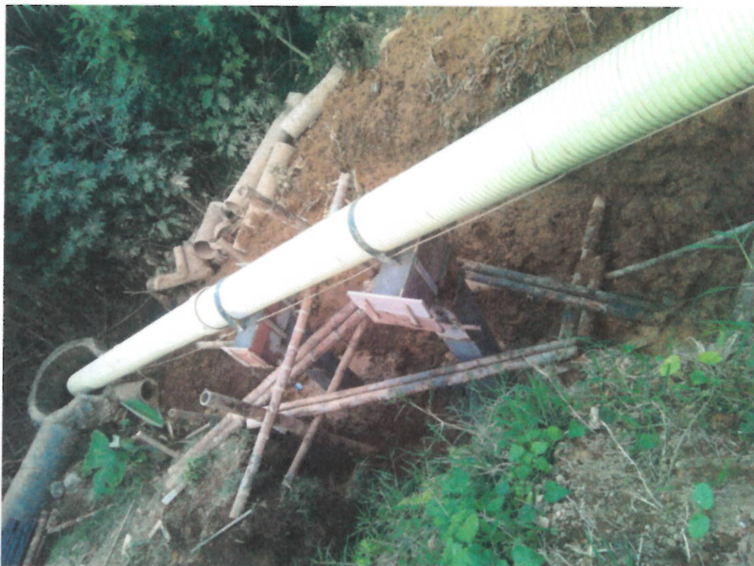
Vaciado de columnas y empotramiento de tubería.
