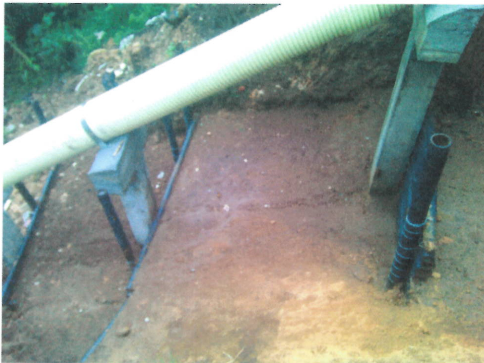
Trinchos en guadua y llenos en tierra.
