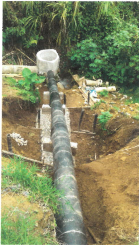
Recubrimiento de tubería en lámina galvanizada.
