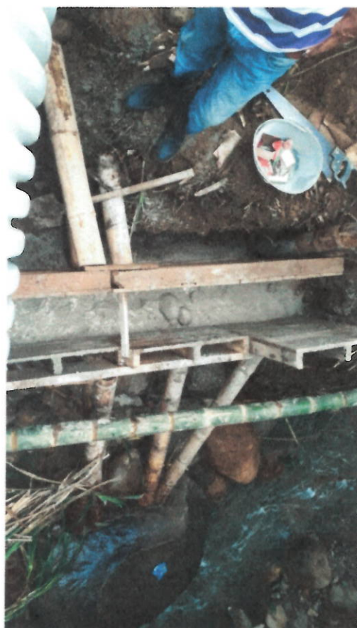
Muro en concreto
