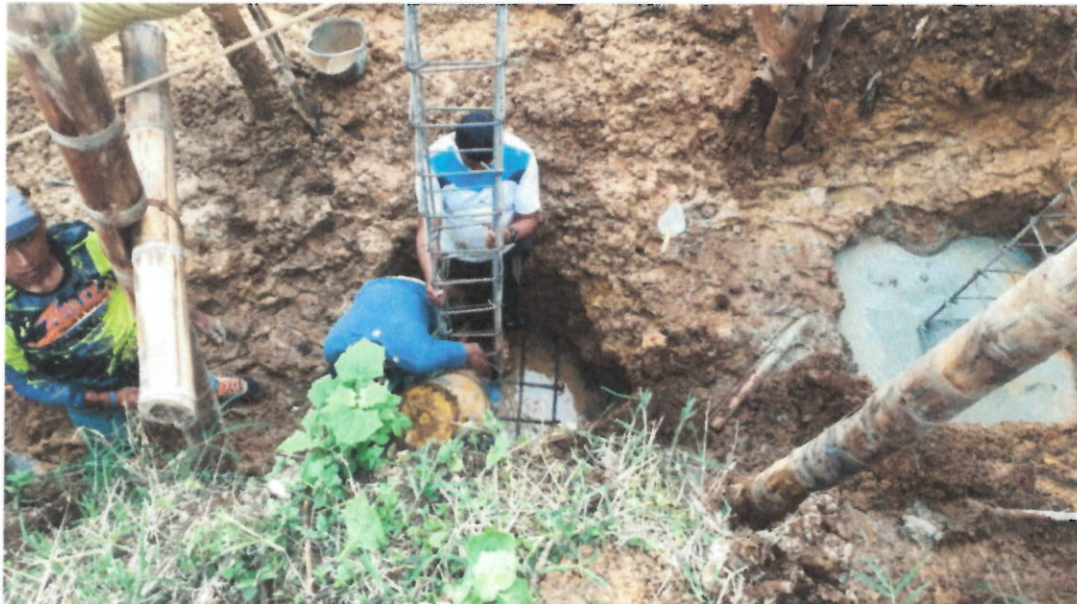
Instalación de acero de refuerzo zapatas y columnas
