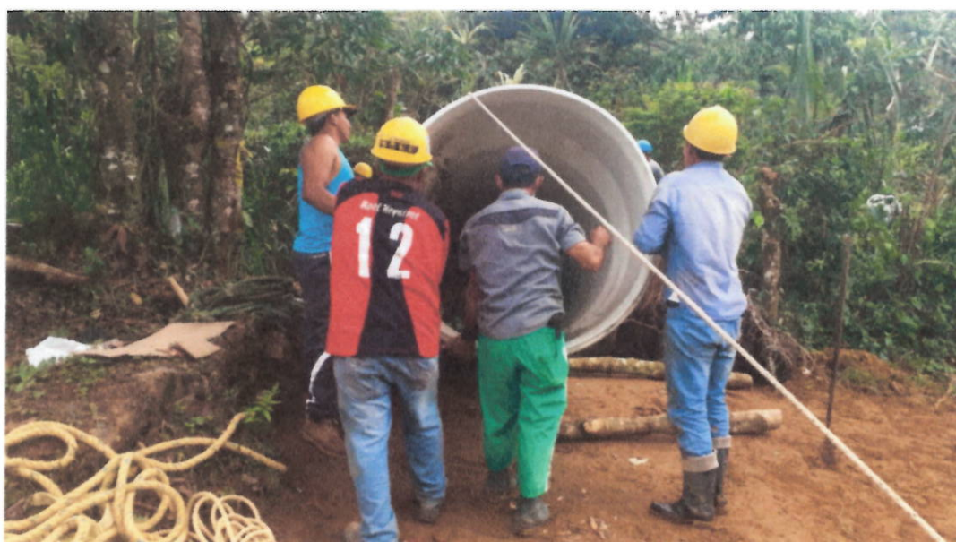
Transporte tubería en el sitio.
