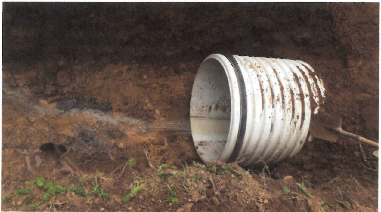
Instalación de tubería
