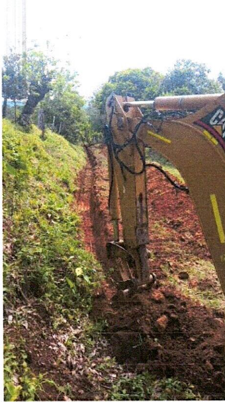
Fotografías No. 08, 09 y 10 Excavaciones para red de acueducto y acometidas domiciliarias
