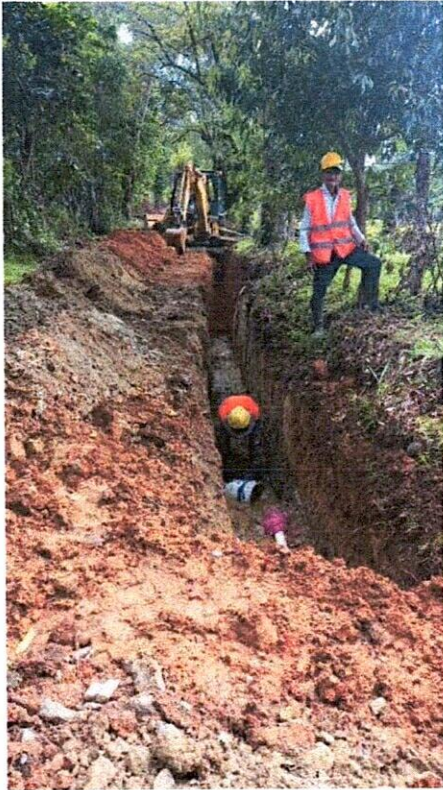
Fotografías No. 08, 09 y 10 Excavaciones para red de acueducto y acometidas domiciliarias
