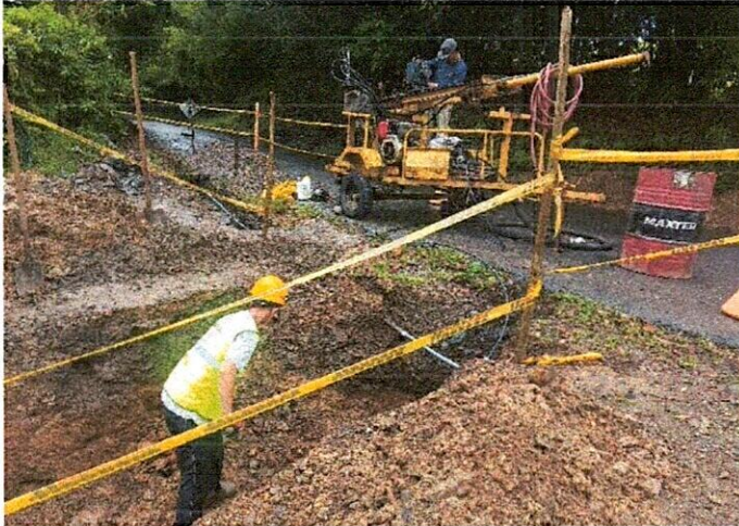
Perforación horizontal con equipo mecánico para pase de vía
