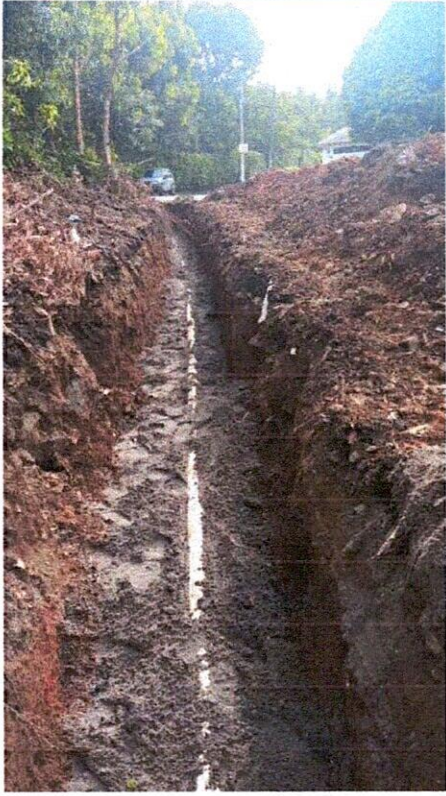
Fotografías No. 11, 12 y 13 Arena para base y atraque, instalación de tubería PVC presión de 3"
