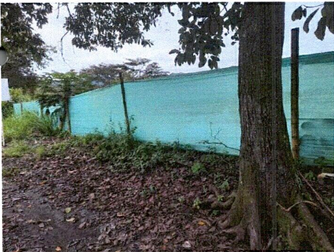
Fotografía No. 02 y No. 03 Cerramiento en tela verde y soportes de Guadua
