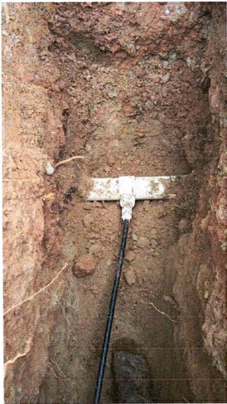
Fotografías No. 14, 15 y 16 Instalación de acometidas domiciliarias
