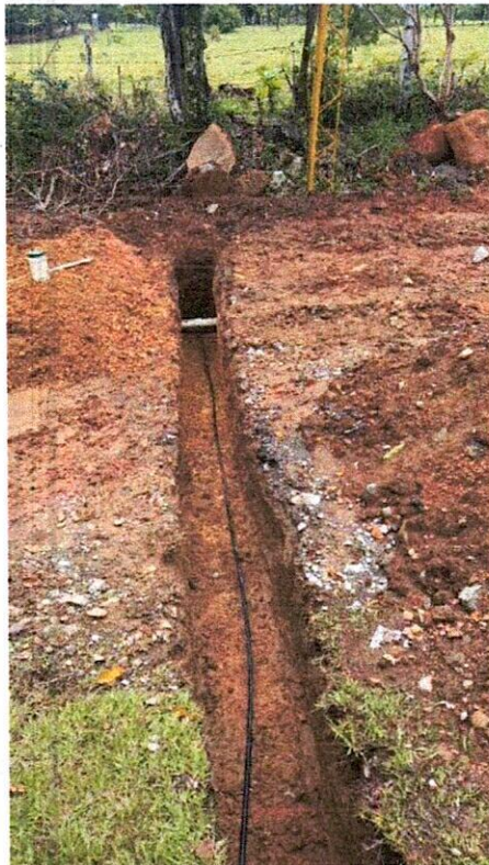
Fotografías No. 14, 15 y 16 Instalación de acometidas domiciliarias
