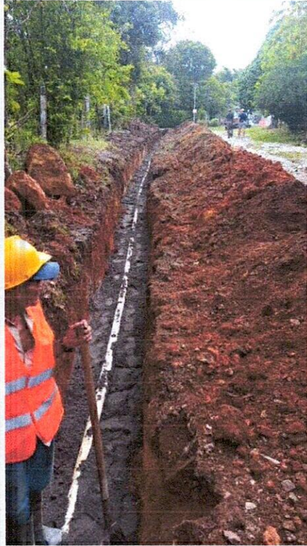
Fotografías No. 11, 12 y 13 Arena para base y atraque, instalación de tubería PVC presión de 3"
