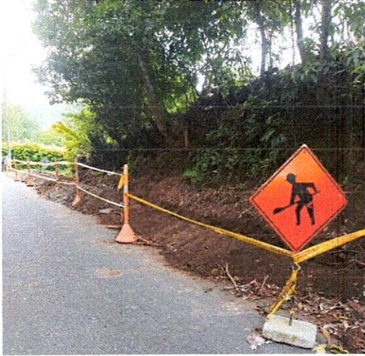
Señalización en obra
