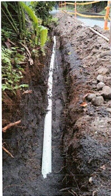
Cama de Arena e instalación de tubería
