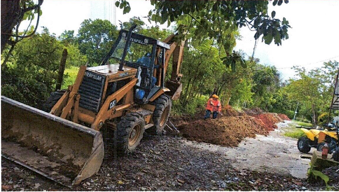
Fotografía No. 07 Excavaciones para red de acueducto
