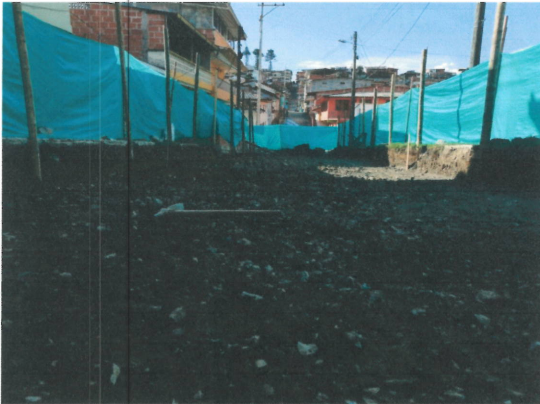
Foto 7 y 8. Demoliciones de pavimentos rígidos y andenes y sardineles y retiro de sobrantes
