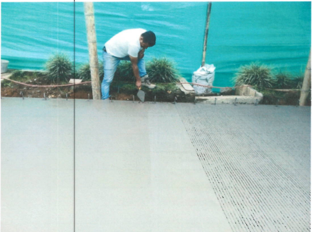
Foto 29 y 30. Acero para la conformación de Dovelas, Canastillas, Pavimento rígido de 4000 Psi y Acero de refuerzo para losas
