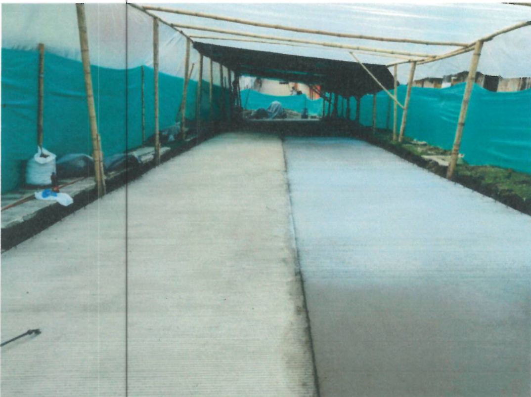
Foto 31 y 32. Obras complementarias a la reposición de redes de acueducto y optimización alcantarillado
