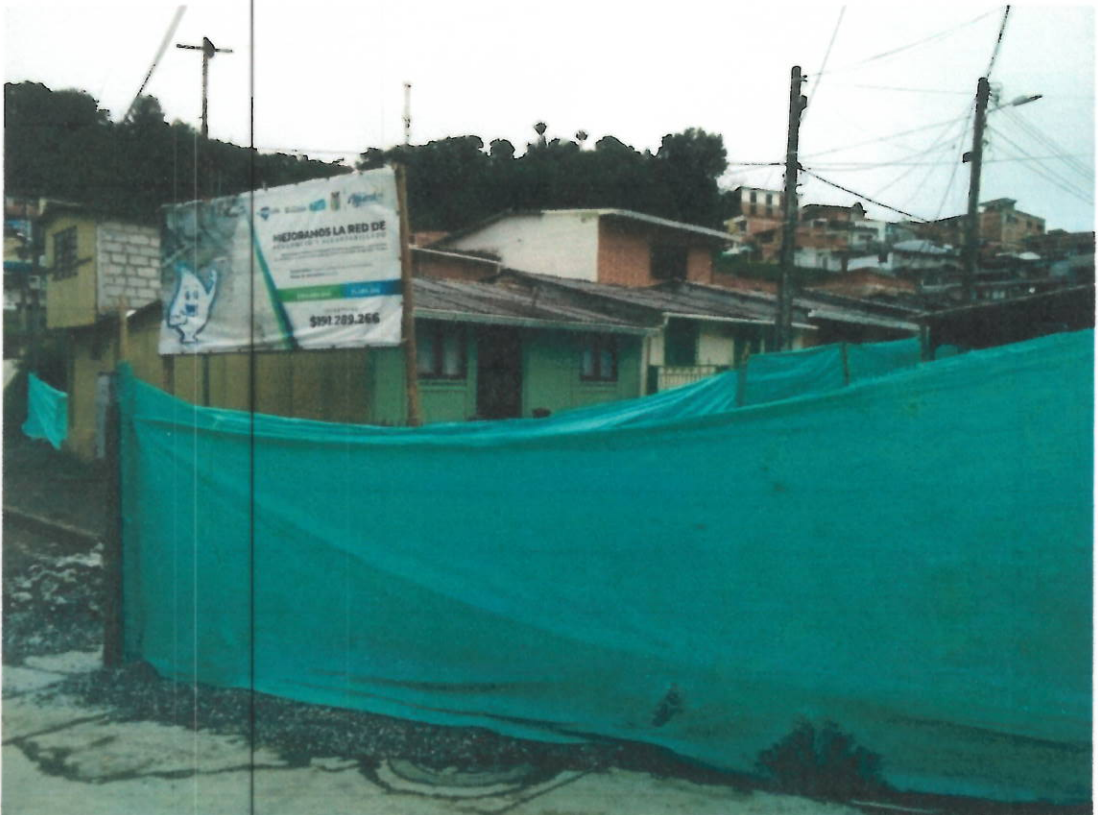
Foto 1 y 2. Valla alusiva a la Obra de 4 x 2m, Cerramiento en polisombra Yute verde de H=2m, paralelas en guadua y cinta plástica y Localización y replanteo de redes.
