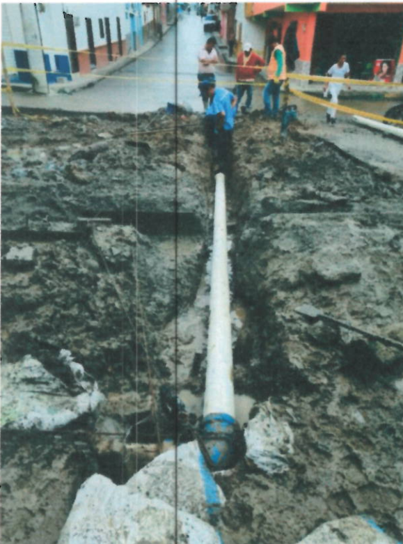
Foto 11, 12, 13 y 14. Excavaciones y suministro e instalación de tubería, Sumideros, Cajas de inspección y empalmes
