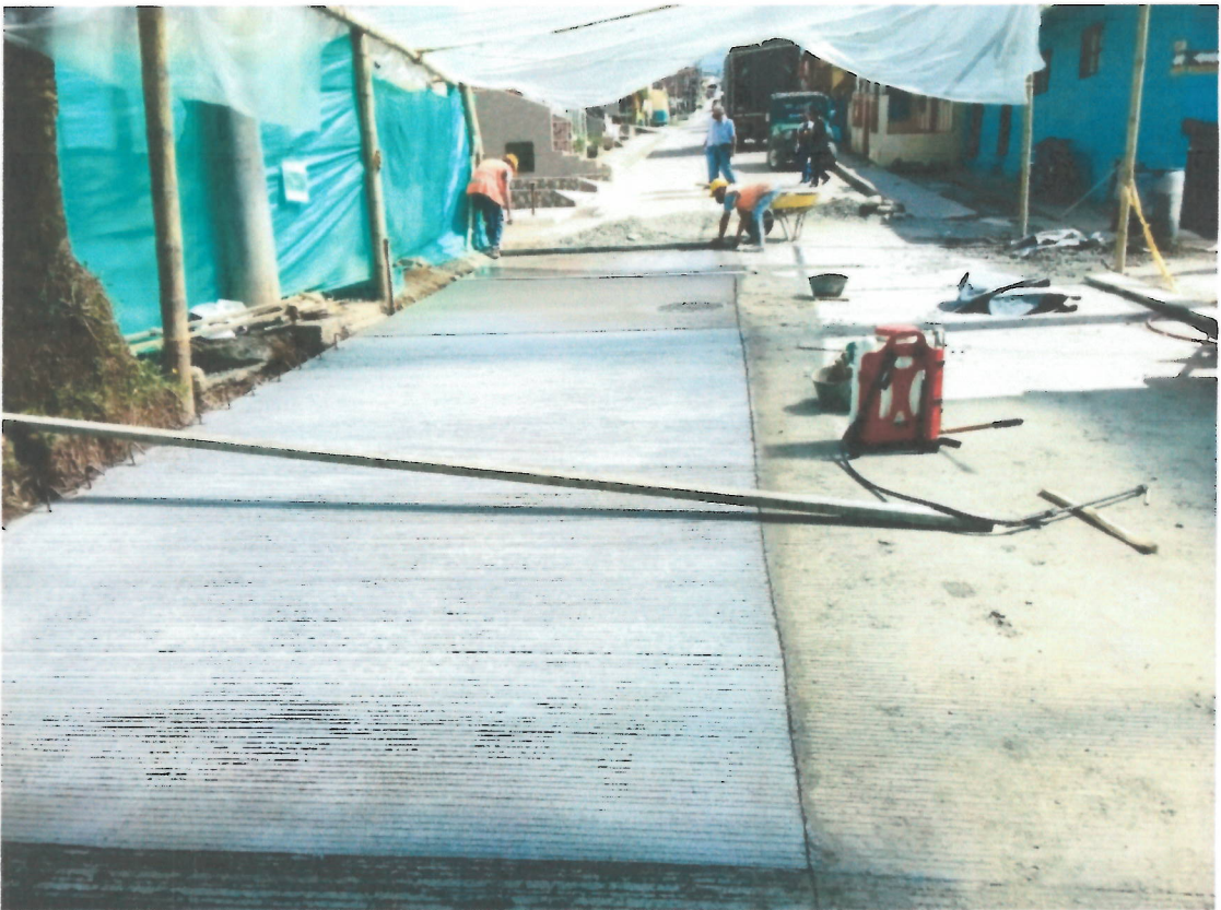
Foto 10, 11. Pavimento en rígido de 4000 Psi
