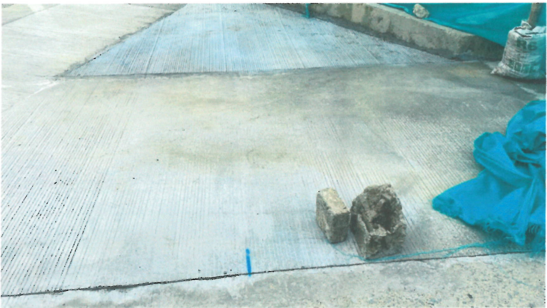
Foto 12, 13. Pavimento en rígido de 4000 Psi
