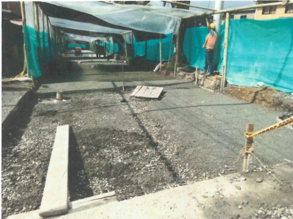
Foto 2. Localización y replanteo de redes, Cerramiento en polisombra en Yute verde de H=2m, parales en guadua y Cinta Plástica, Suministro, transporte e instalación de techo provisional en guadua y plástico, Señalización Vertical preventivas. Demoliciones. Suministro e instalación de afirmado y Sub-base tipo INVIAS.
