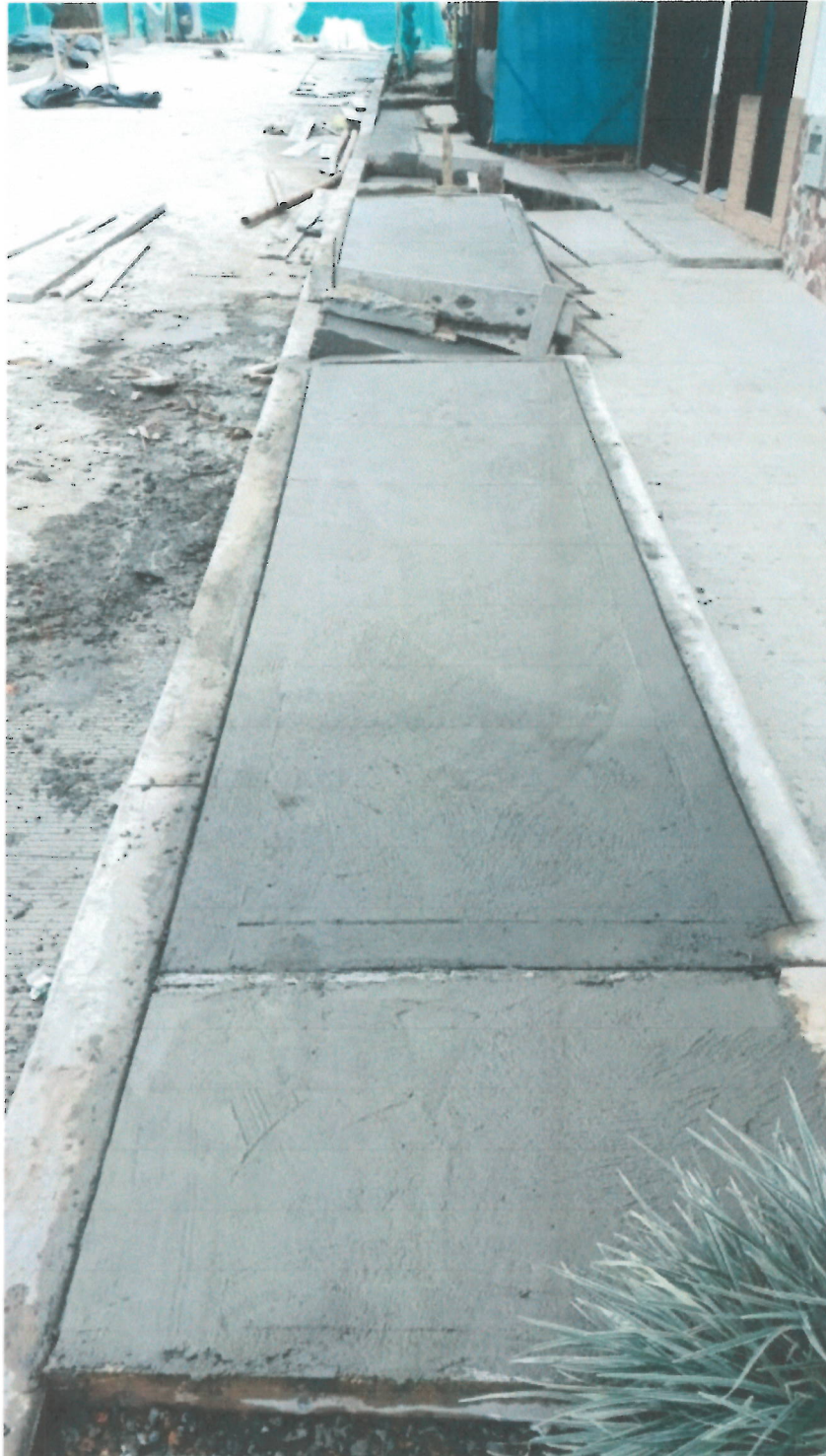
Foto 19. Adecuación de Andenes y Rampas, Bordillo sardinel en concreto
