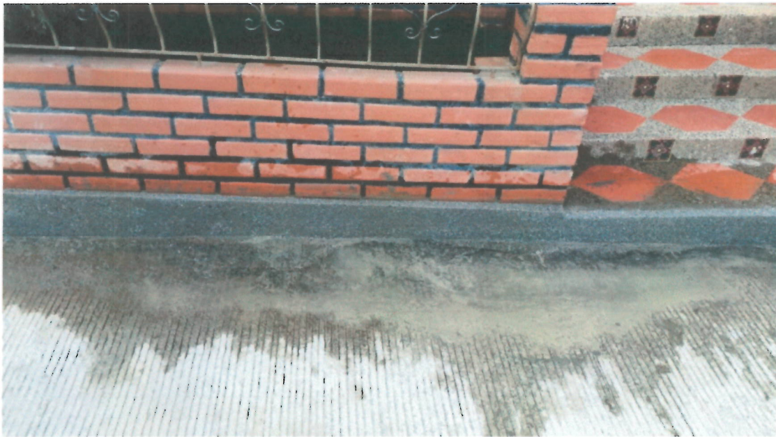
Foto 20 y 21. Obras complementarias a la reposición de redes de acueducto y optimización alcantarillado en la carrera 6 entre calles 12 y 13
