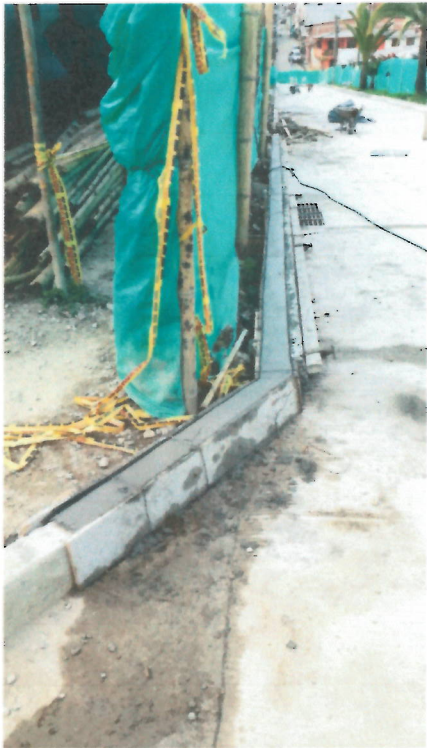
Foto 14, 15, 16 y 17. Bordillo sardinel en concreto
