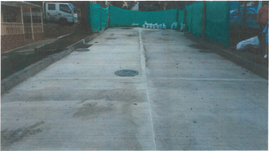
Foto 22 y 23. Obras complementarias a la reposición de redes de acueducto y optimización alcantarillado en la carrera 6 entre calles 12 y 13.
