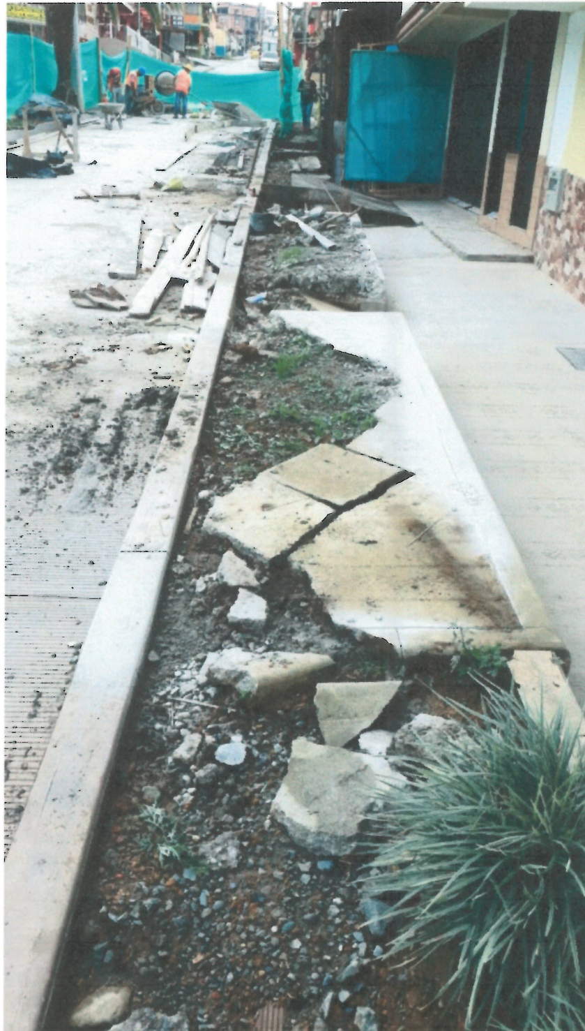
Foto 18. Adecuación de Andenes y Rampas, Bordillo sardinel en concreto
