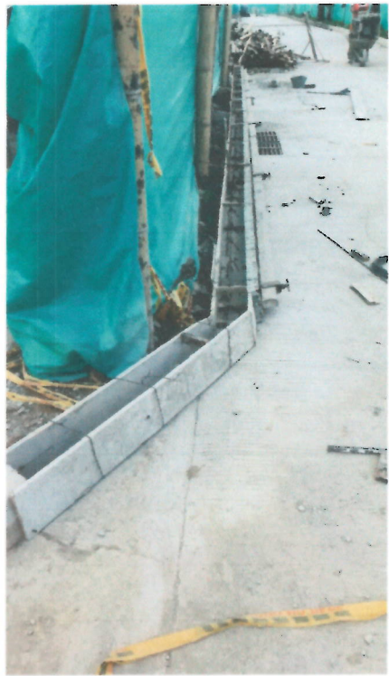
Foto 14, 15, 16 y 17. Bordillo sardinel en concreto
