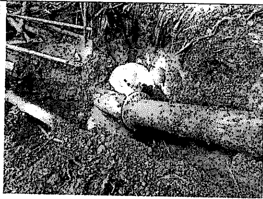
Reparación mediante la instalación de 12 metros de tubería de polietileno
