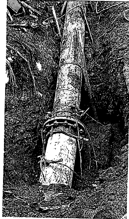
Reparación mediante la instalación de 12 metros de tubería de polietileno instalación de anclajes en concreto y tubería galvanizada
