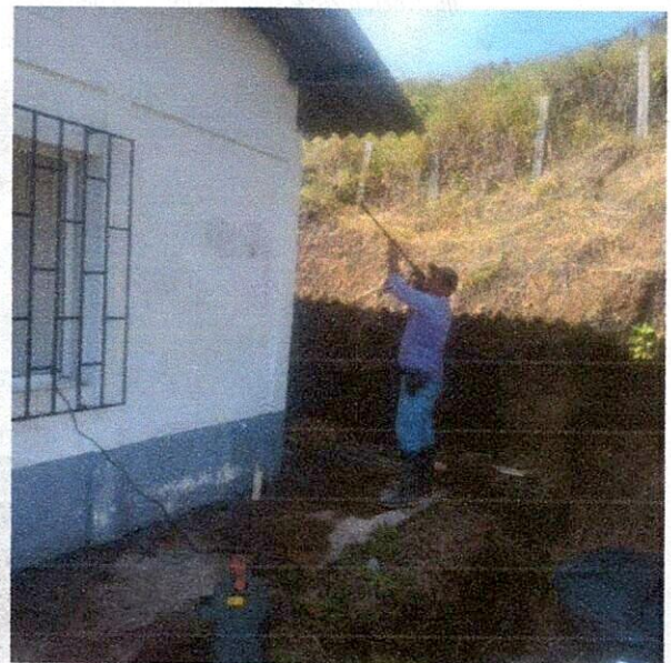
Ilustración 27: limpieza de la planta
