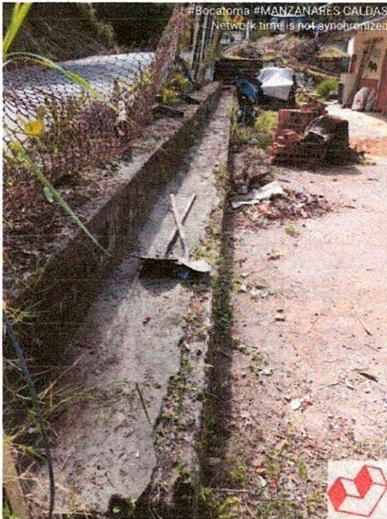
Ilustración 32: limpieza para demolición
