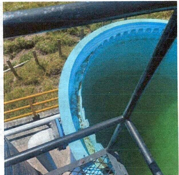
Ilustración 16: estado inicial de la planta
