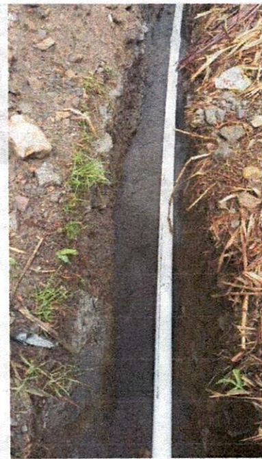
Ilustración 38: cama de arena para tubería
