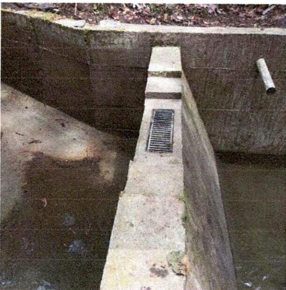
Ilustración 25: limpieza de la bocatoma
