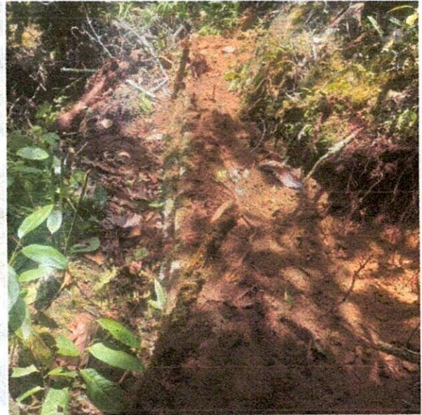
Ilustración 23: trinchos para llenos y protección de la tubería
