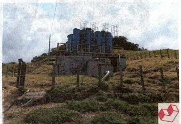
Ilustración 31: rociadora de la planta
