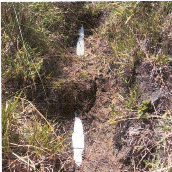
Ilustración 14: tubería expuesta
