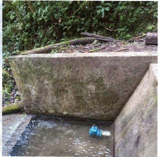
Ilustración 26: limpieza de la bocatoma
