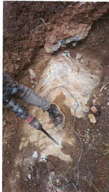
Ilustración 51: demolición de roca
