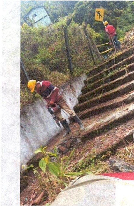
Ilustración 40: demolição de placa
