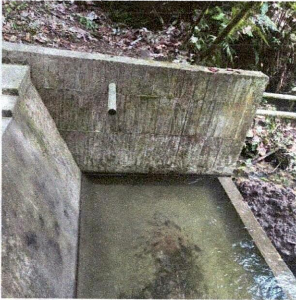
Ilustración 25: limpieza de la bocatoma
