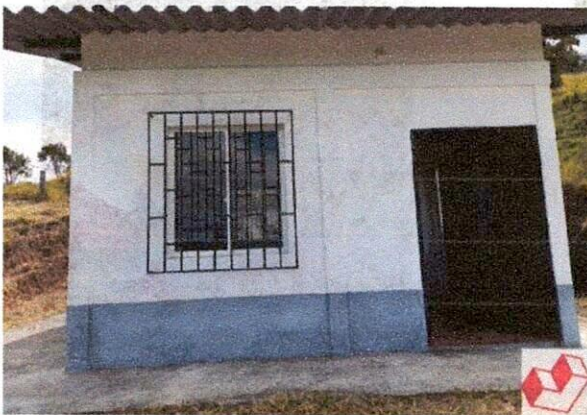
Ilustración 33: estado inicial de la planta
