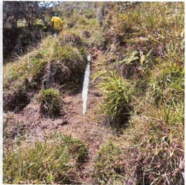
Ilustración 19: tubería expuesta
