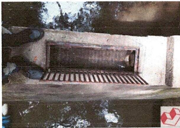
Ilustración 36: estado final de la bocatoma
