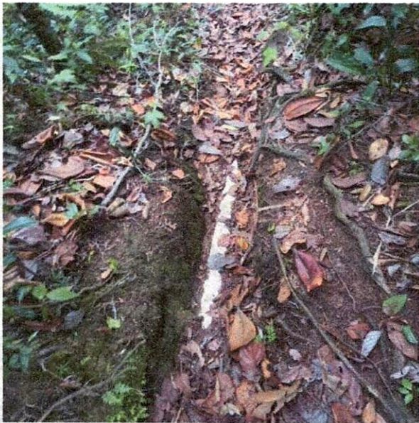
Ilustración 9: tubería expuesta
