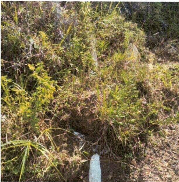
Ilustración 18: tubería expuesta
