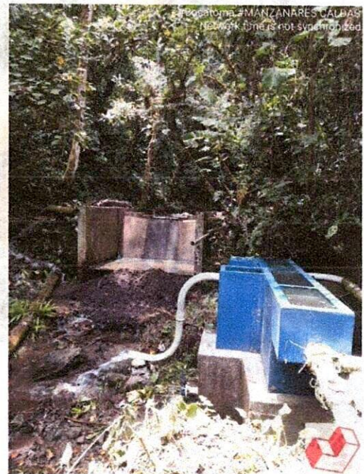
Ilustración 35: estado final de la bocanoma
