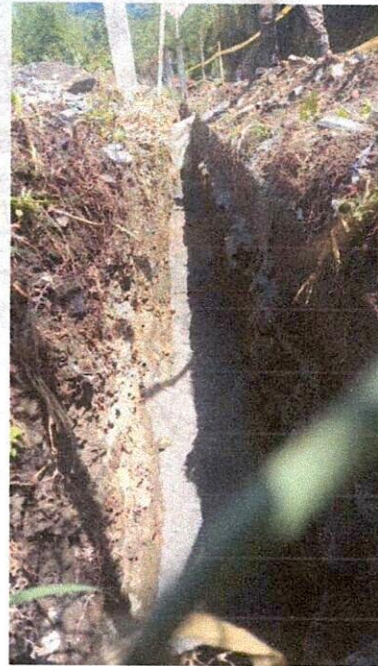
Ilustración 43: cama de arena para tubería
