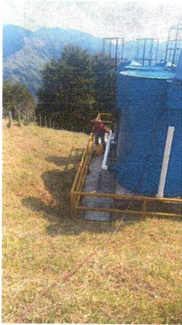
Ilustración 48: limpieza de la planta
