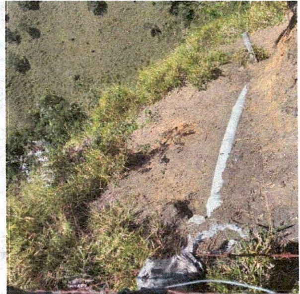
Ilustración 15: tubería expuesta
