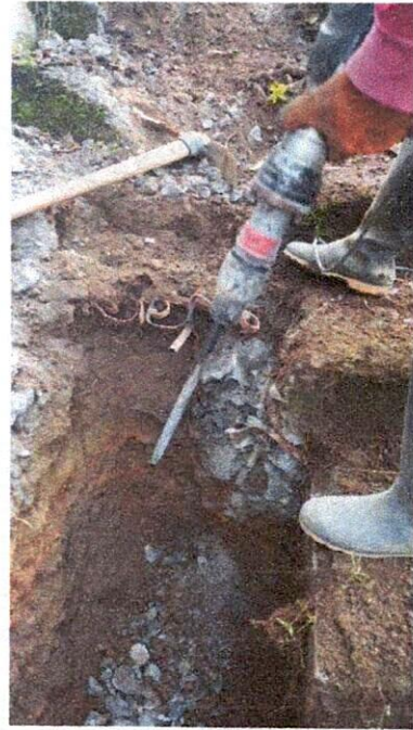
Ilustración 50: demolición de roca
