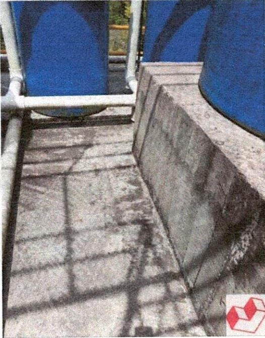
Ilustración 28: estado inicial de la planta
