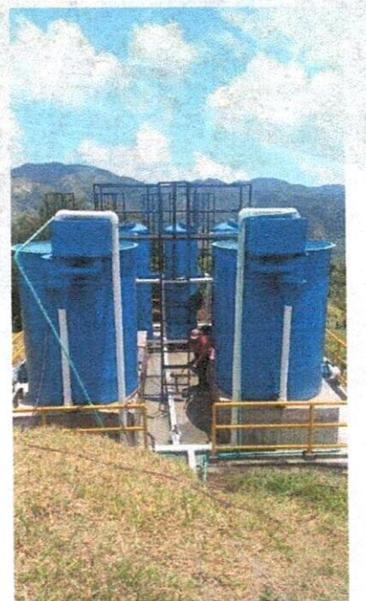
Ilustración 47: limpieza de la planta
