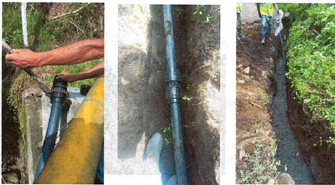
Fotografías No. 04,05 y 06 Uniones PEAD y Tubería PEAD sector Santo Domingo-cama de arena
