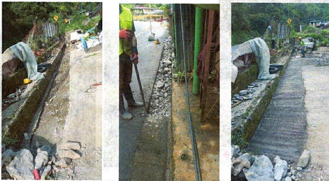
Fotografías No. 01,02 y 03 Demoliciones y reconstrucción de cuneta
