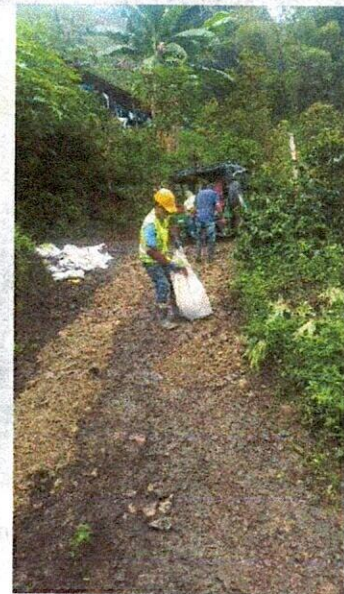
Fotografías No. 16,17 y 18 Suministro, transporte e instalación de afirmado para mantenimiento de Vía.
