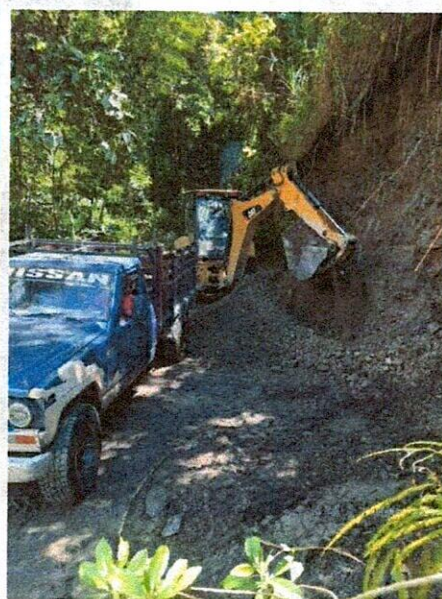
Fotografías No. 16,17 y 18 Suministro, transporte e instalación de afirmado para mantenimiento de Vía.
