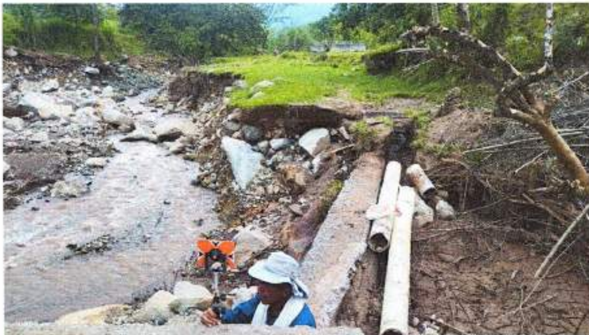
Figura 11. Fotografías del levantamiento Bocatoma Los Cano
