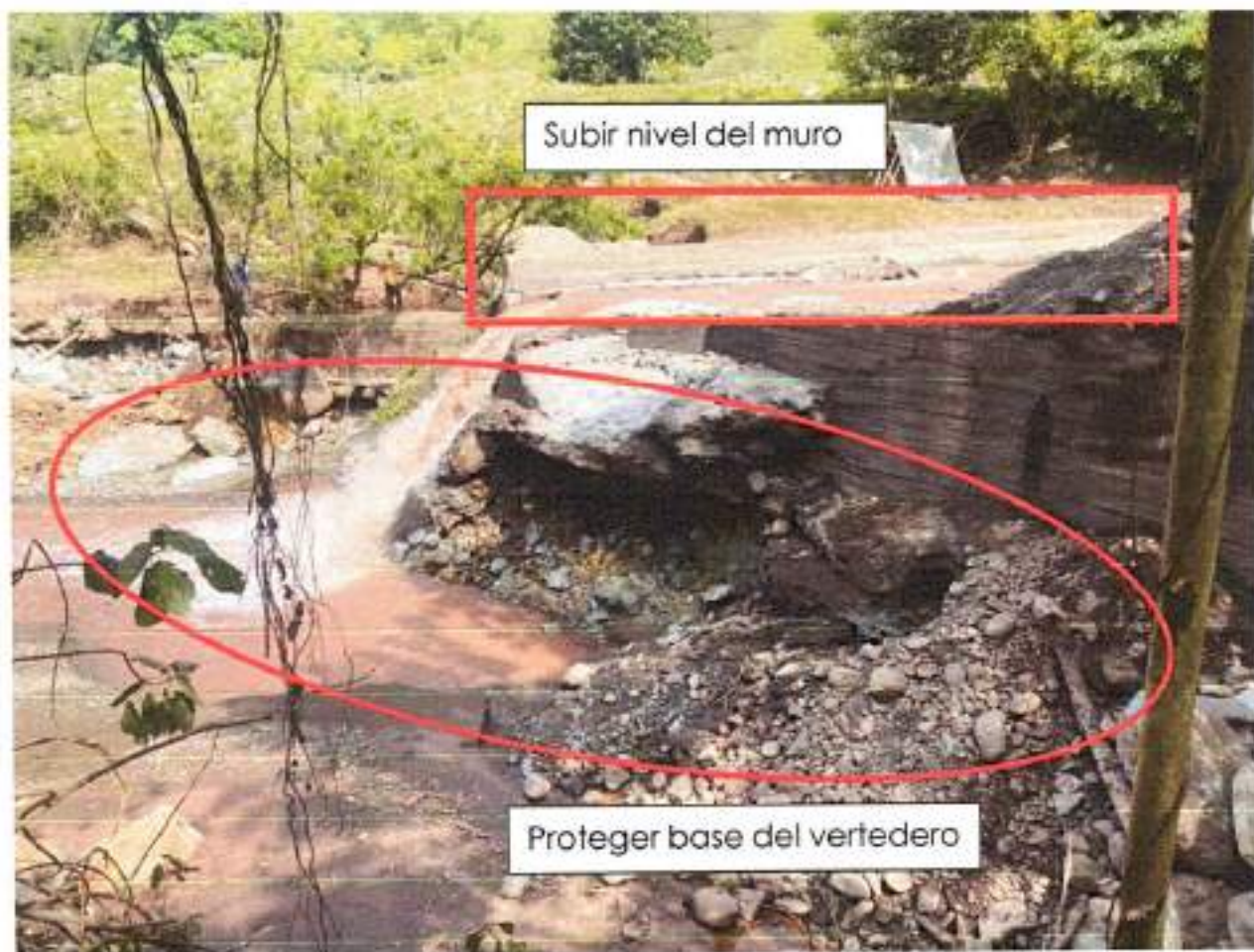
Figura 3. Recomendaciones Bocatoma Los Cano
