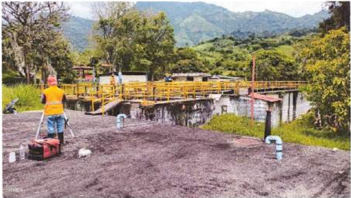
Figura 13. Fotografías del levantamiento Bocatoma Los Cano
