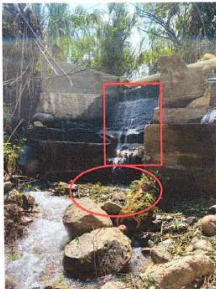
Figura 6. Zona para recalzar y rellenar
