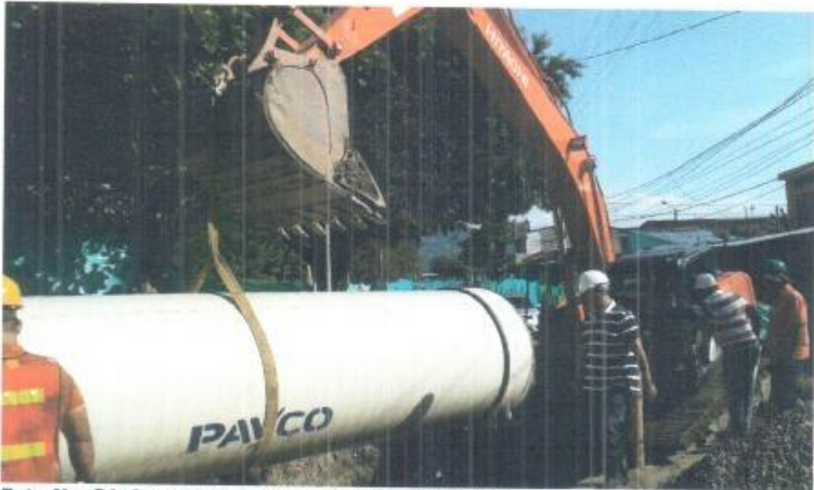
Foto No. 21: Ingreso primera tubería cerca de la cámara 11.
