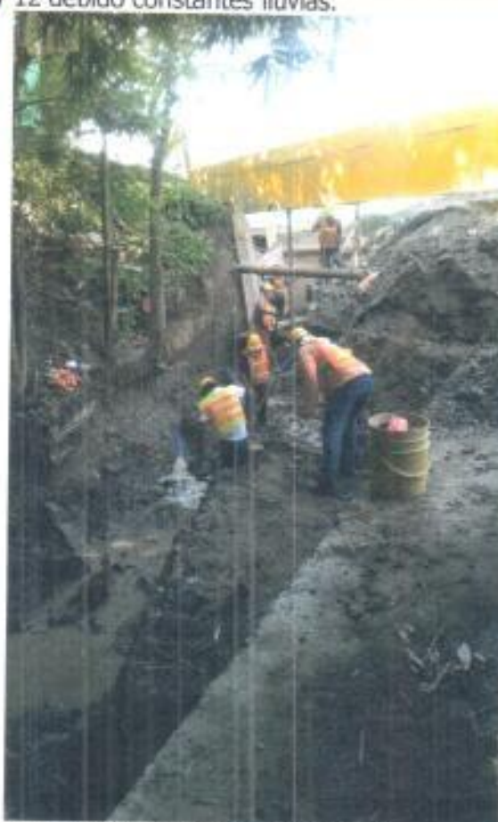
Fotos No. 13 y 14: Retiro de agua con motobombas entre las cámaras 11 y 12.
