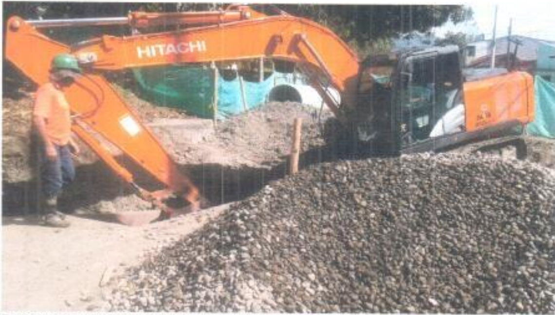
Foto No. 18: Ingreso material granular para soporte de tubería.
