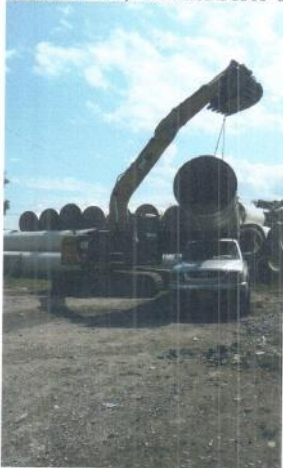
Fotos No. 6 y 7: Transporte de tubería de 51" desde el depósito.
