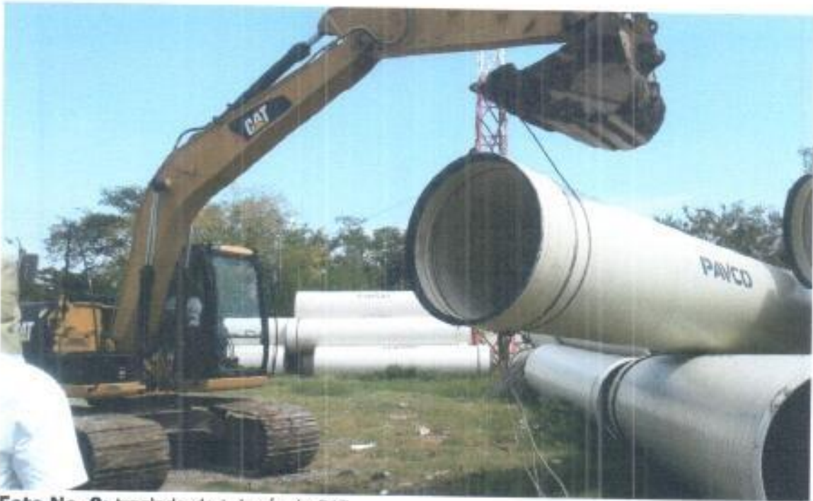
Foto No. 8: traslado de tubería de 51".
