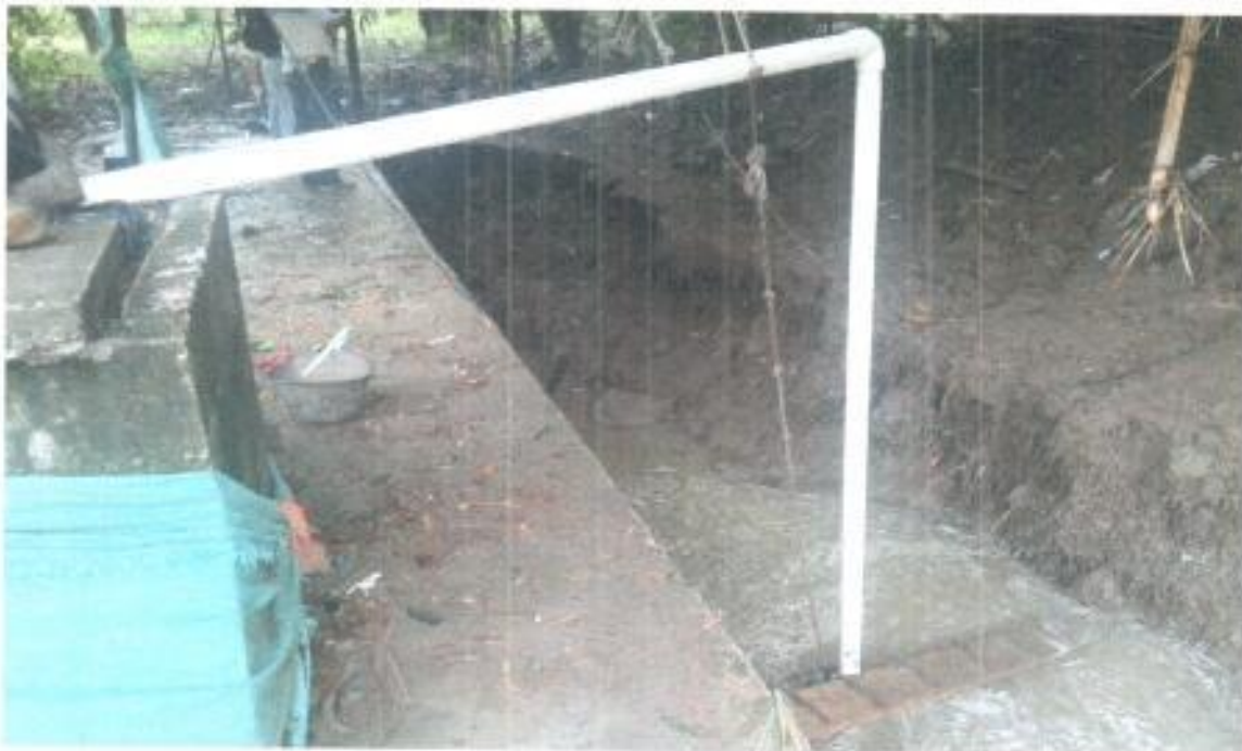
Foto No. 2: Motobomba de 3" trabajando al lado del box culvert.
