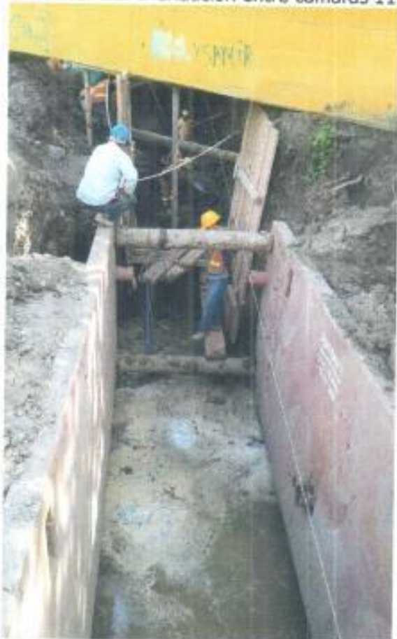
Fotos No. 13 y 14: Retiro de agua con motobombas entre las cámaras 11 y 12.
