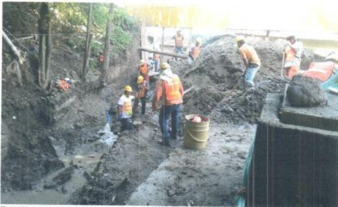
Foto No. 4: excavación cerca de cámara 12 y retiro de agua con motobombas.
