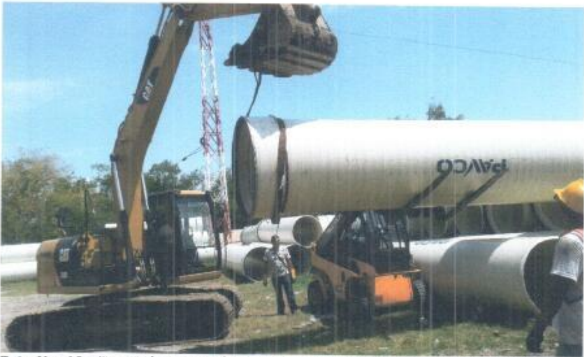
Foto No. 10: disposición de tubería en montacargas con ayuda de retroexcavadora.
