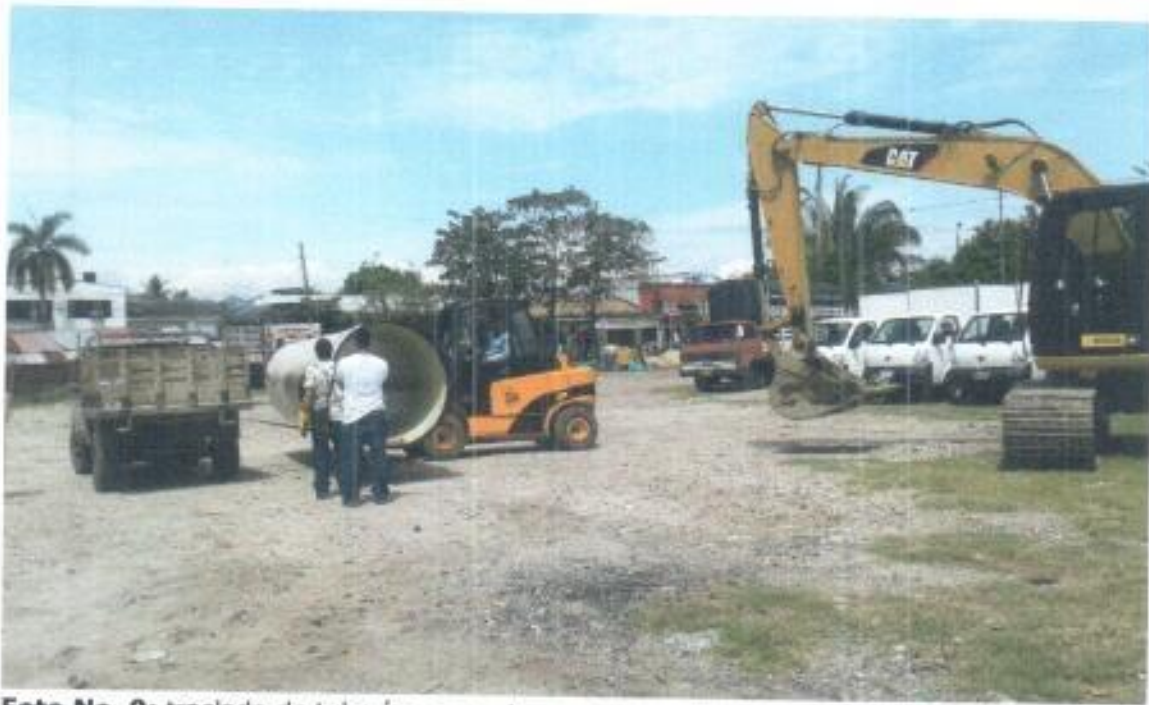
Foto No. 9: traslado de tubería en montacarga.
