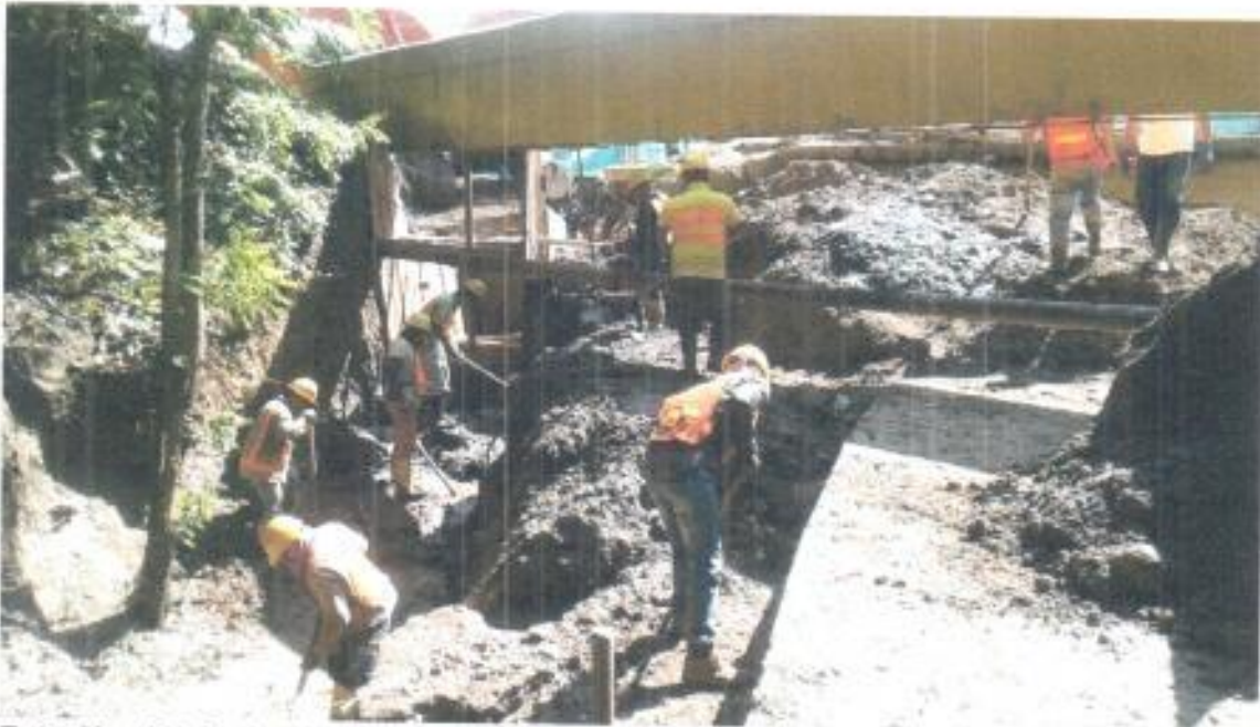
Foto No. 15: Retiro de material común entre cámaras 11 y 12.
