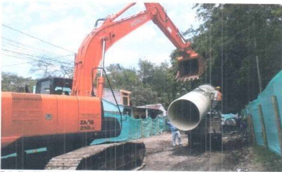
Foto No. 11: descargue de tubería de 51" en la obra.
