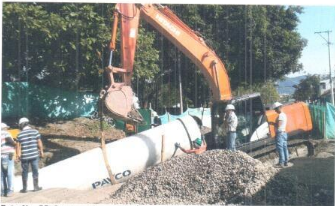
Foto No. 22: Ingreso primera tubería cerca de la cámara 11.
