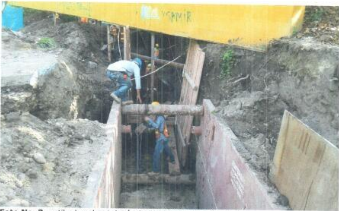
Foto No. 3: entibado sobre tubería de 51" cerca de la cámara 11.
