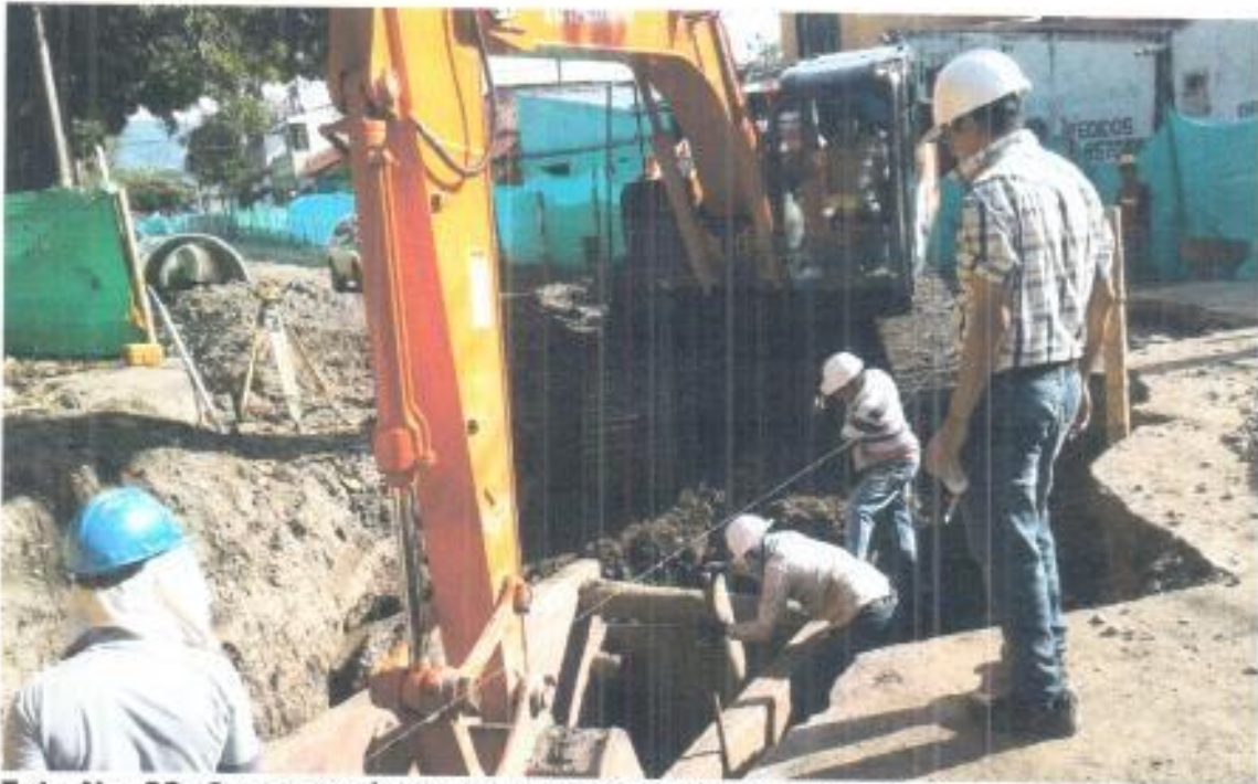
Foto No. 23: Compactación material sobre primer tubo cerca de cámara 11.
