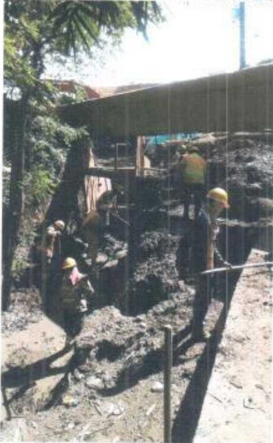
Foto No. 16 y 17: Excavación manual cerca de cámara 12 Ingreso material granular para soporte de tubería.
