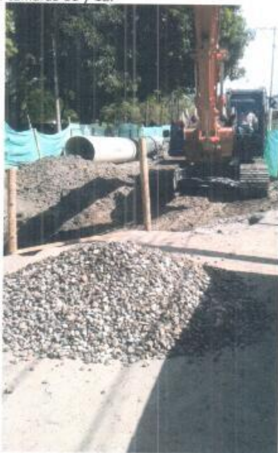
Foto No. 16 y 17: Excavación manual cerca de cámara 12 Ingreso material granular para soporte de tubería.
