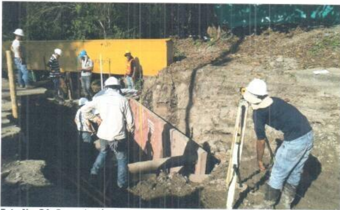
Foto No. 24: Comprobación de pendientes con topografía.
