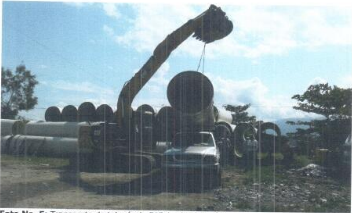
Foto No. 5: Transporte de tubería de 51" desde el depósito.
