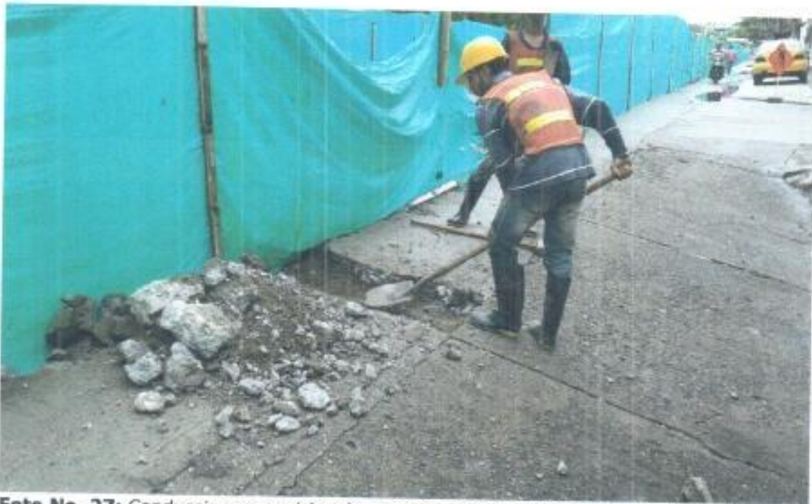
Foto No. 27: Conducciones provisionales para desviar las aguas producto de lluvias.
