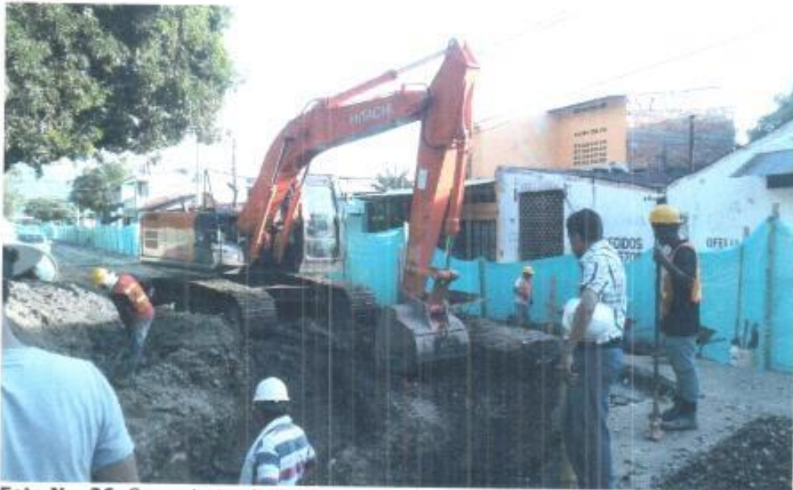
Foto No. 26: Cerramiento alrededor de la obra.
