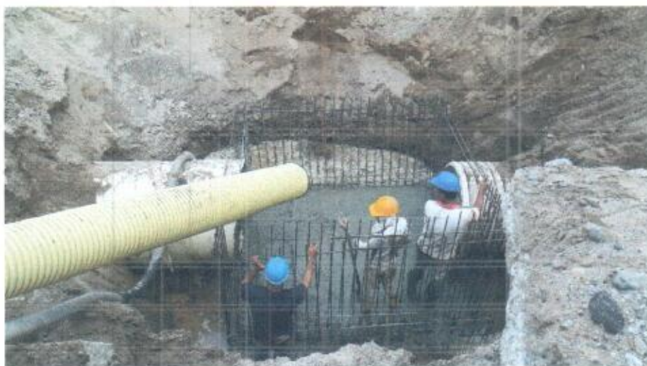
Foto 21, 22 y 23. Construcción de Cámara 5 y 4A
