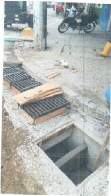
Foto 8 y 9. Armado de Formaletas y construcción de sumideros.
