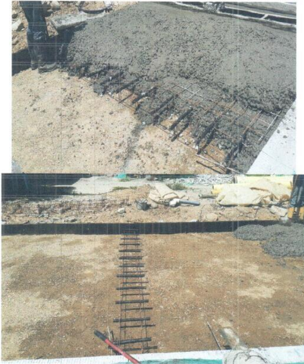
Foto 16 y 17. Instalación de dovela para pavimento
