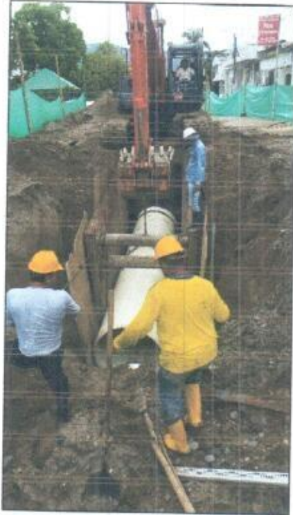
Fotos 4 y 5. Instalación de tuberías de 48" Pulgadas
