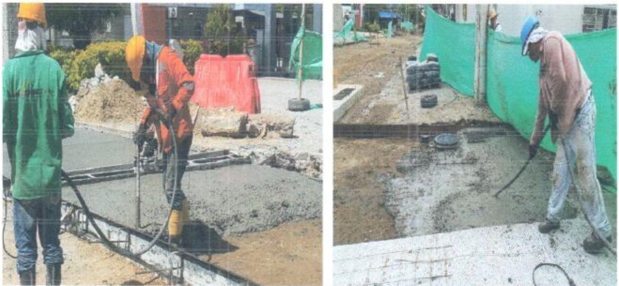
Foto 17 Y 18. Vibrado de la mezcla del pavimento de concreto
