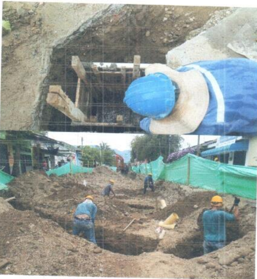
Foto 8 y 9. Armado de Formaletas y construcción de sumideros.
