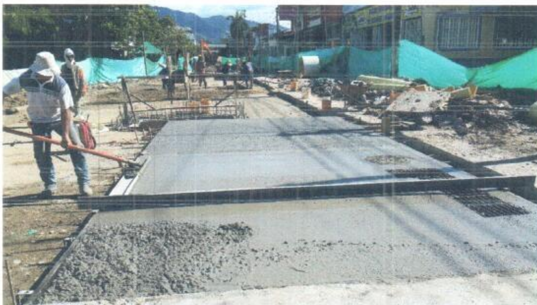
Foto 17 Y 18. Vaciado de losas de pavimento.
