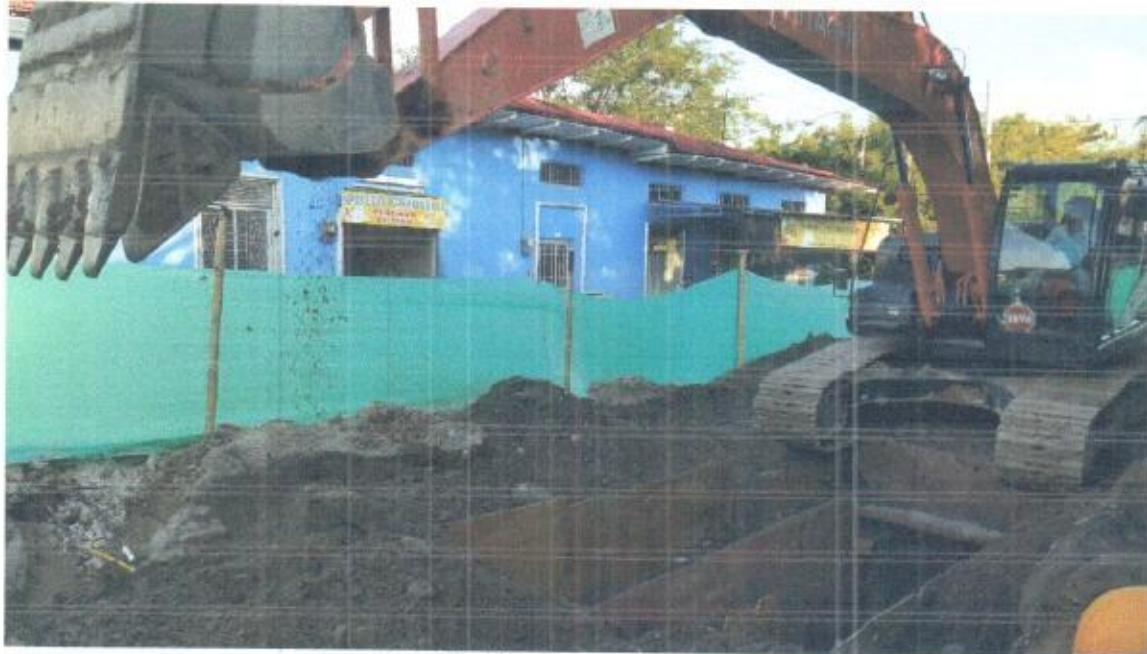
Foto 1. Instalación de Entibado para la tubería
