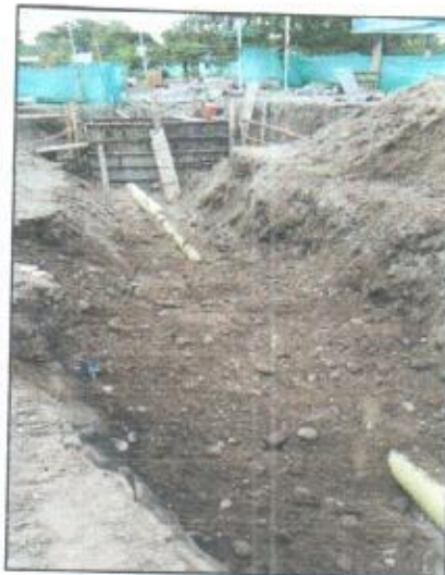
Foto 12 y 13. Instalación de tubería de 12"
