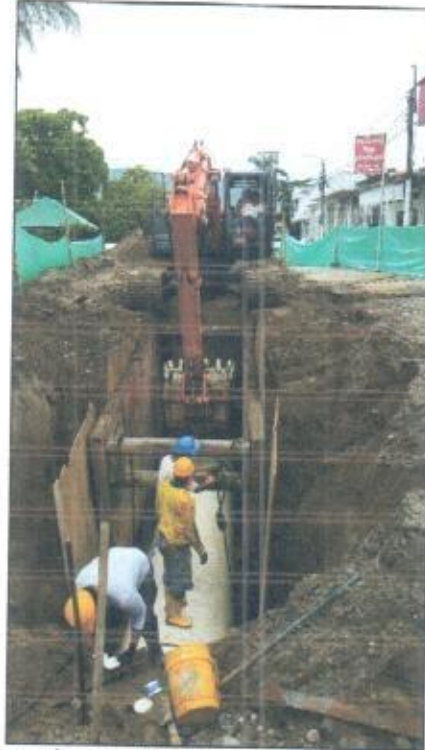
Fotos 4 y 5. Instalación de tuberías de 48" Pulgadas
