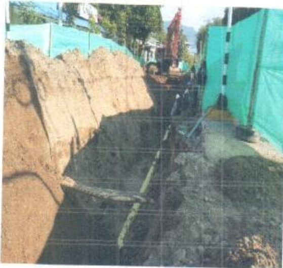
Foto 12 y 13. Instalación de tubería de 12"
