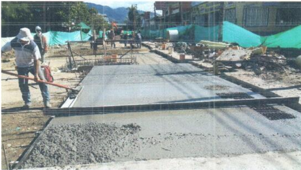
Foto 17 Y 18. Vaciado de losas de pavimento.
