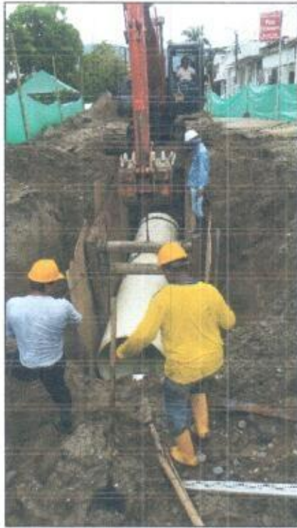
Fotos 4 y 5. Instalación de tuberías de 48" Pulgadas
