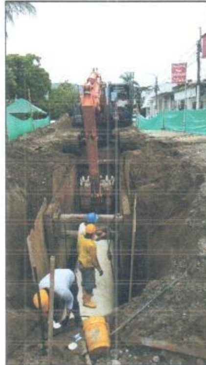
Fotos 4 y 5. Instalación de tuberías de 48" Pulgadas
