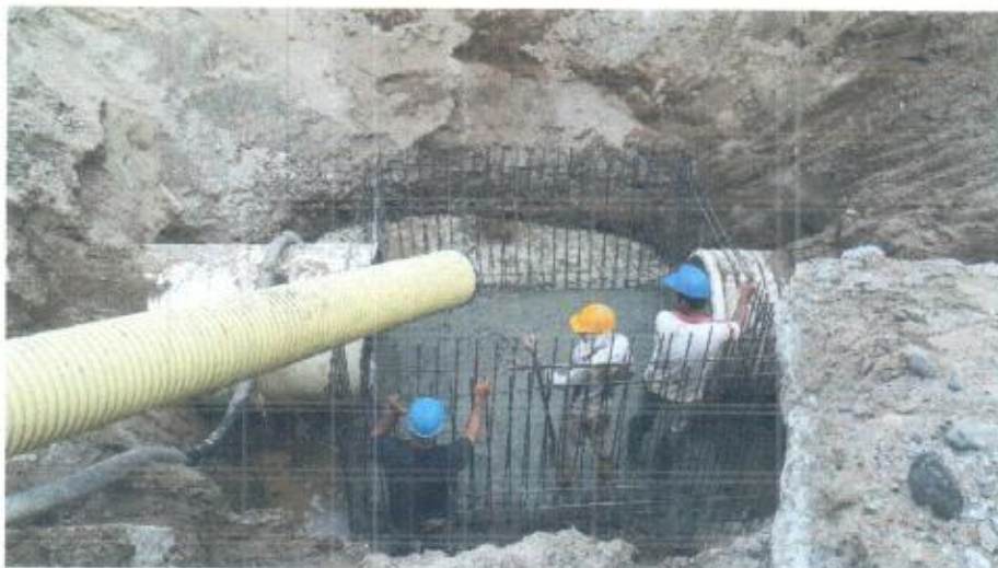
Foto 21, 22 y 23. Construcción de Cámara 5 y 4A
