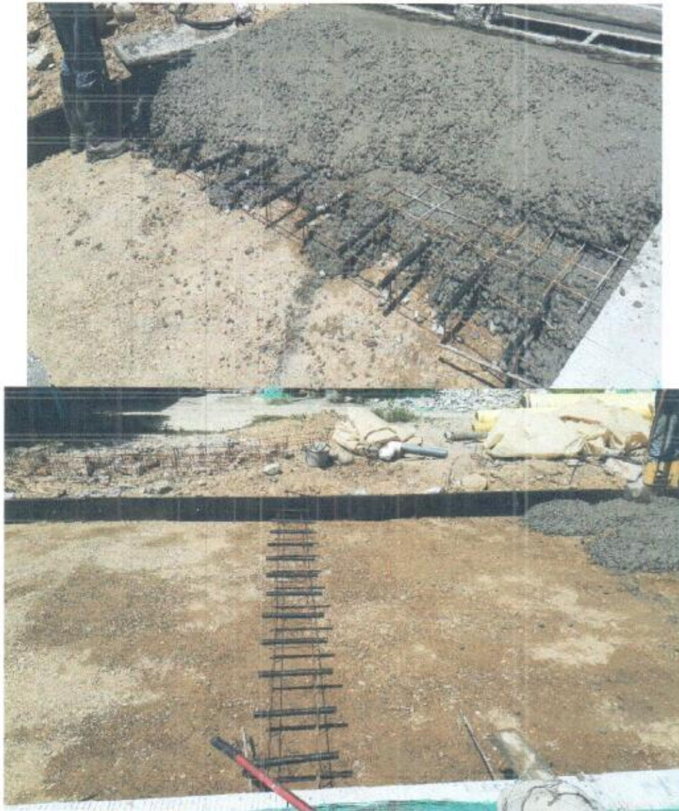
Foto 16 y 17. Instalación de dovela para pavimento
