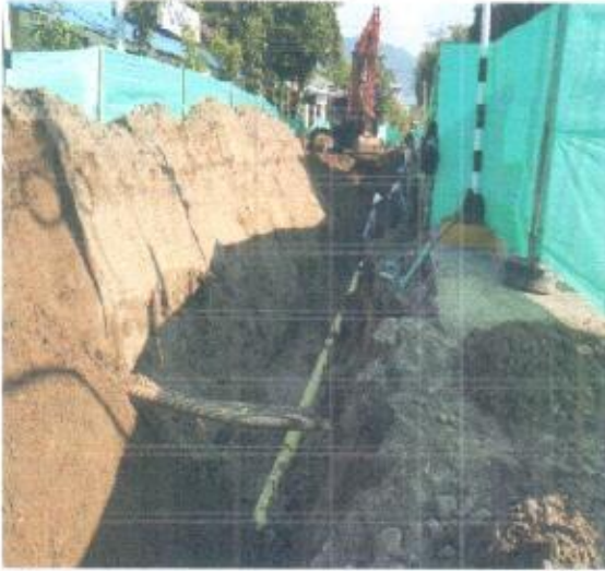
Foto 12 y 13. Instalación de tubería de 12"
