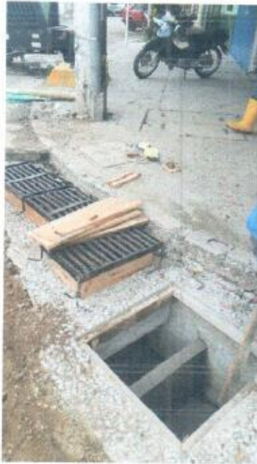
Foto 8 y 9. Armado de Formaletas y construcción de sumideros.
