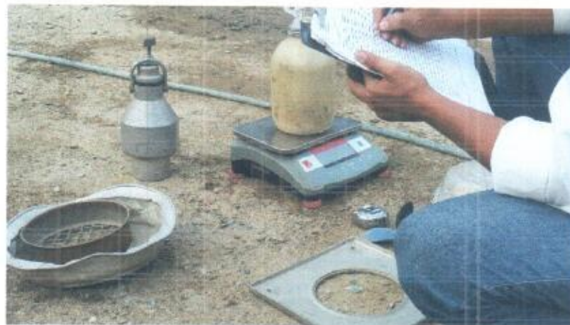
Foto 19 y 20. Toma de densidades a la sub-base y afirmado
