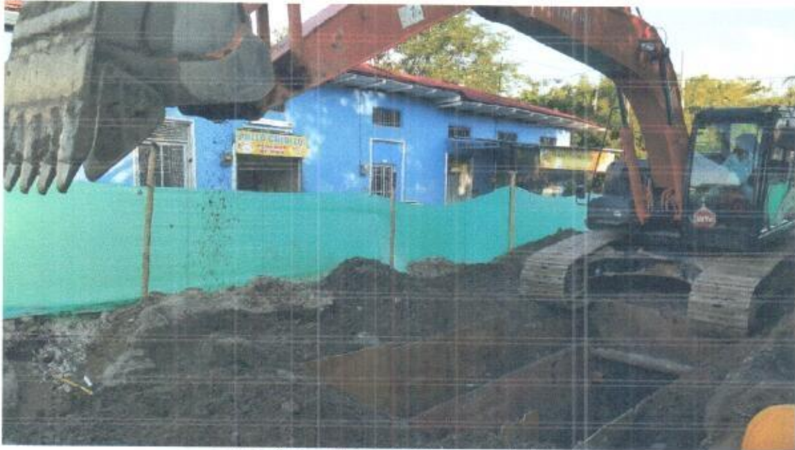
Foto 1. Instalación de Entibado para la tubería
