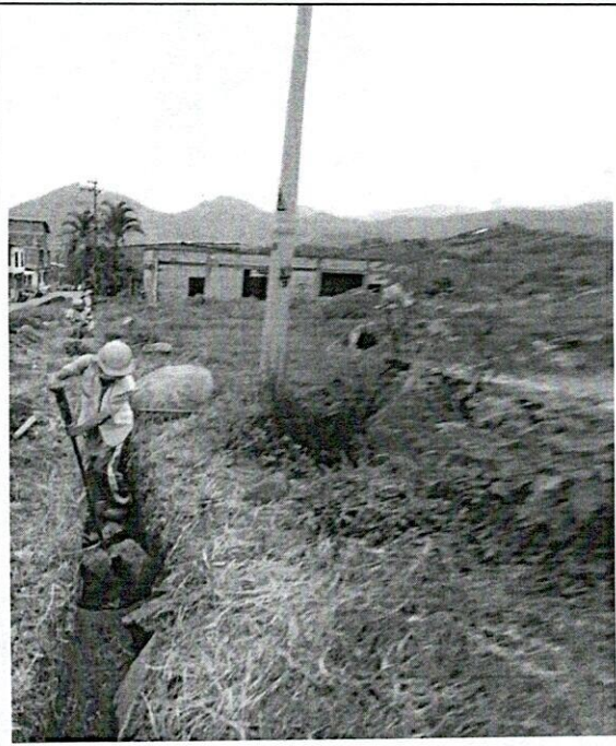
EXCAVACIÓN MANUAL EN ZANJA CON PRESENCIA DE ROCA
