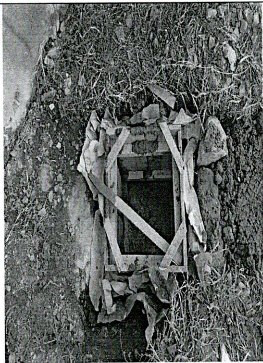
CAJA DOMICIALIARIA Y PROTECCIÓN DE EXCAVACIÓN
