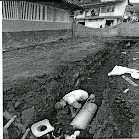
INSTALACIÓN DE RED DE ALCANTARILLADO
