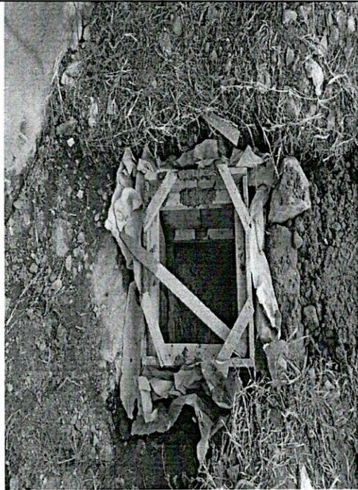
CAJA DOMICIALIARIA Y PROTECCIÓN DE EXCAVACIÓN
