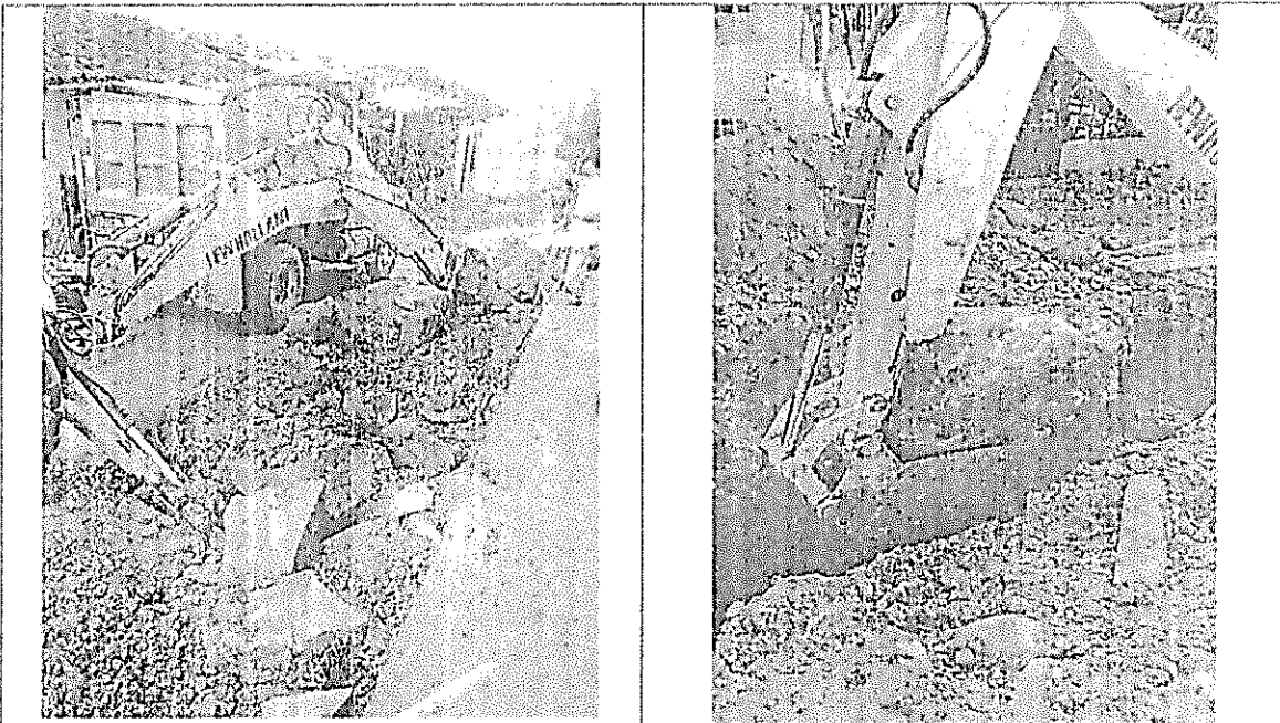
RETIRO DE ROCAS
