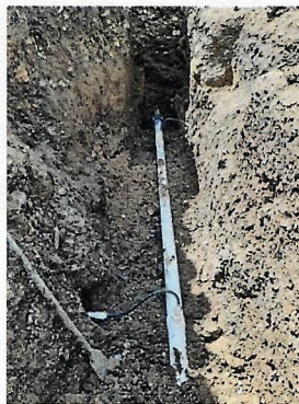
Imagen. Excavación en material común para reposición de tubería de acueducto.
