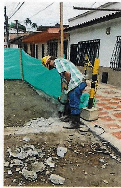
Imagen. Demolición de pavimento rígido
