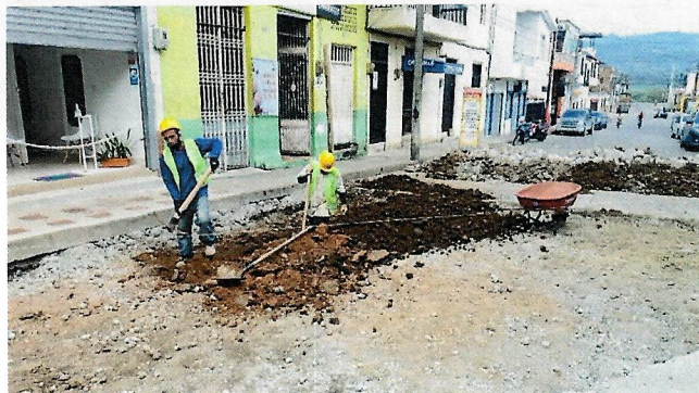
Imagen. Excavación en material común para reposición de tubería de acueducto.
