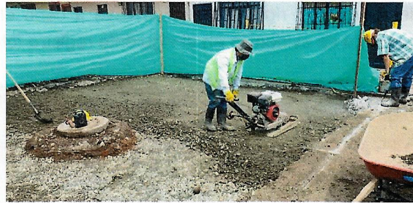
Imagen. Llenos con material granular subbase tipo INVIAS.
