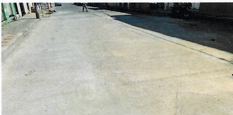
Imagen. Pavimentación final Calle 7 entre Carreras 7 Y 8.
