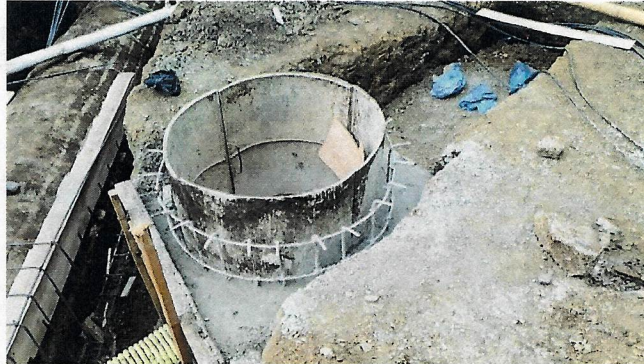
Imagen. Construcción cámara de caída.
