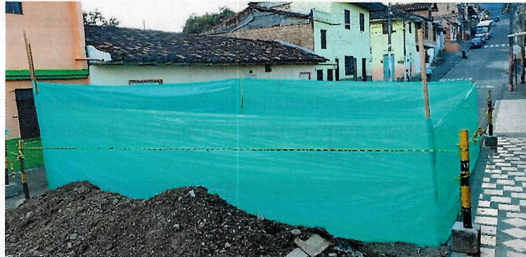
Imagen. Cerramiento con tela verde y soportes de guadua cada 2 metros.
