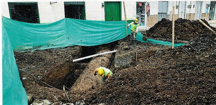
Imagen. Excavación en material conglomerado y material común.
