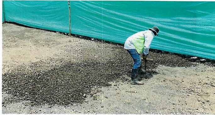
Imagen. Llenos con material granular subbase tipo INVIA
