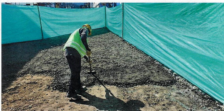
Imagen. Llenos con material granular subbase tipo INVIAS.
