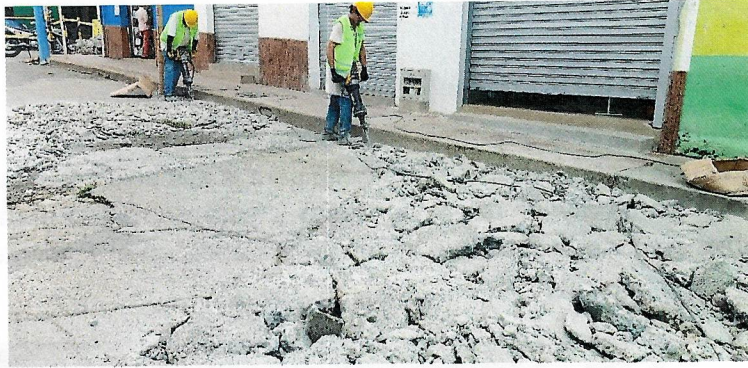
Imagen. Demolición de pavimento rígido
