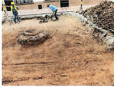
Imagen. Llenos compactados con material del sitio para conformación de la subrasante.
