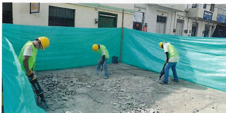
Imagen. Demolición de pavimento rígido
