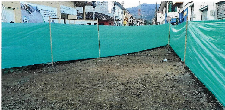
Imagen. Llenos compactados con material del sitio para conformación de la subrasante.
