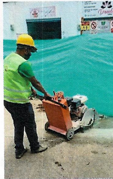
Imagen. Corte de pavimento rígido con maquina cortadora de disco.
