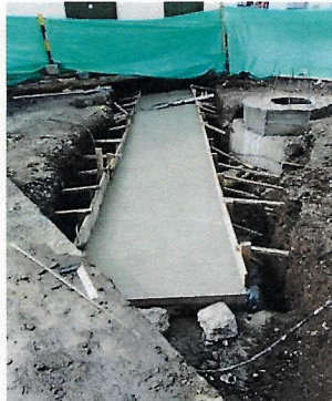
Imagen. Estructura en concreto reforzado para protección del Box Couvert
