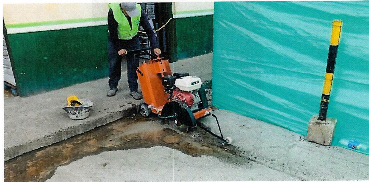
Imagen. Corte de pavimento rígido con maquina cortadora de disco.
