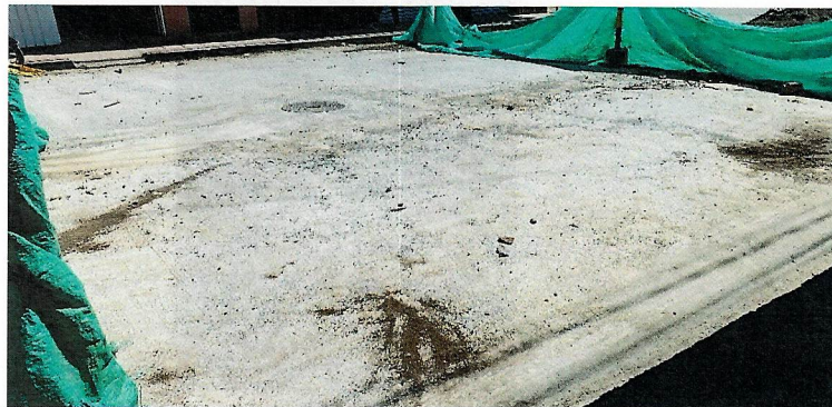
Imagen. Pavimentación final Carrera 7 Entre Calles 7 Y 6 - Frente a la Registraduría.
