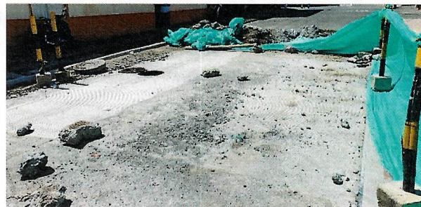
Imagen. Pavimentación final Calle 6 entre Carreras 6 Y 7.
