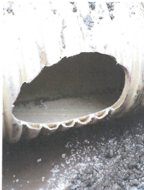
Instalación de silletas de 12" x 6" en tubería corrugada para domiciliaria
