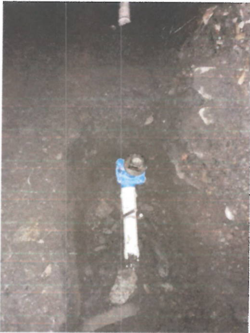
Instalación de válvula
