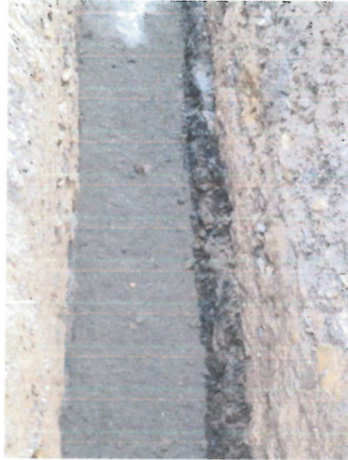
Cama de arena para tubería de izq. Acueducto y der. Alcantarillado
