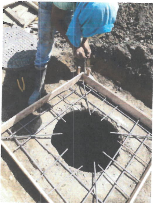
Acero de refuerzo para tapas de cámaras
