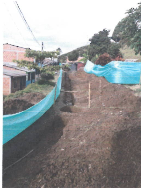
Cerramiento con tela verde y soporte de guadua (izq. Acueducto y der. Alcantarillado)
