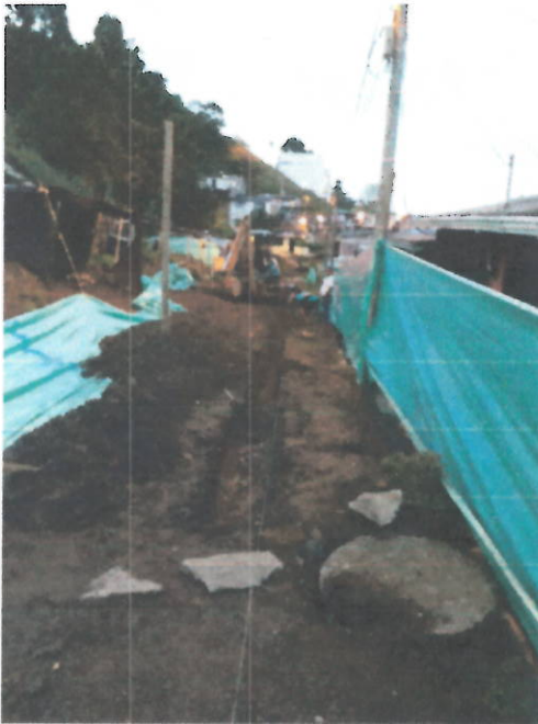
Cerramiento con tela verde y soporte de guadua (izq. Acueducto y der. Alcantarillado)
