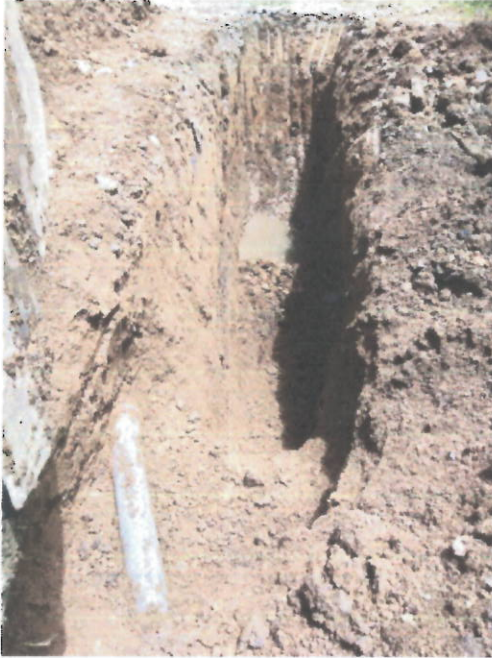
Excavación en material común
