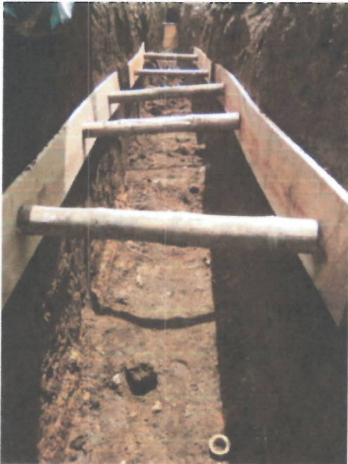
Entibado horizontal en excavación para tubería de alcantarillado
