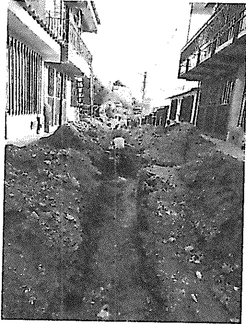
Excavación en conglomerado
