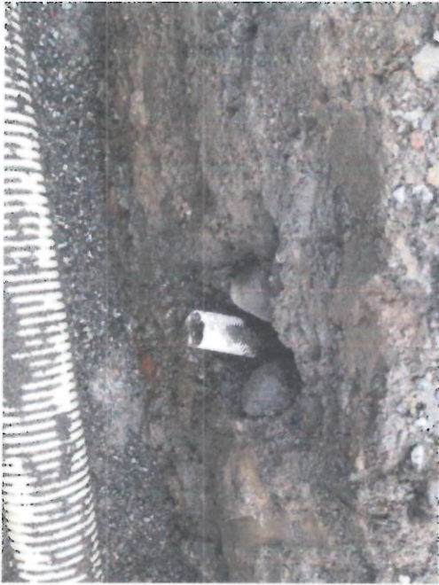
Instalación de tubería 6" para domiciliarias
