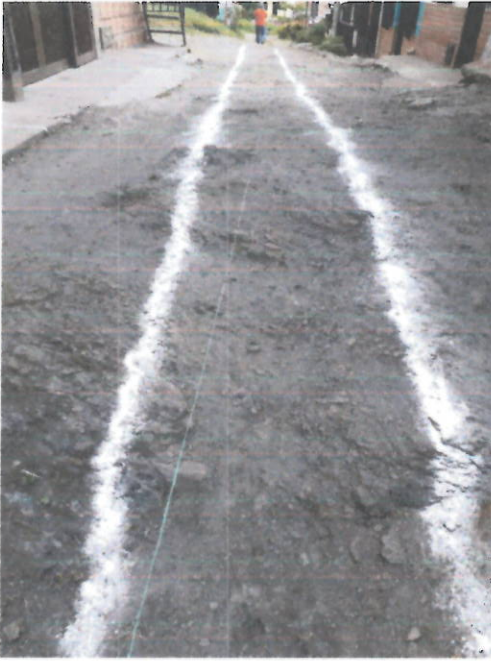
Localización y replanteo de las obras a realizarse
