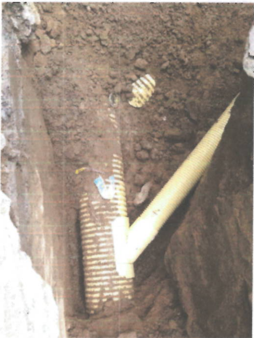
Instalación de silletas de 12" x 6" en tubería corrugada para domiciliaria
