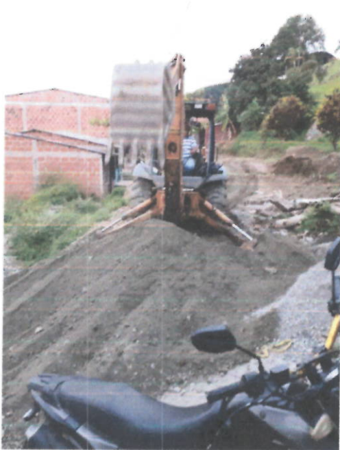
Sub base granular para los últimos 20 centímetros de la excavación
