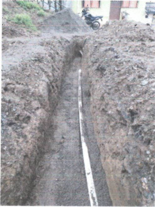
Cama de arena para tubería de izq. Acueducto y der. Alcantarillado
