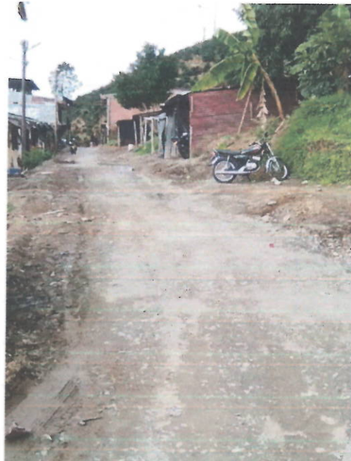
Sub base granular para los últimos 20 centímetros de la excavación
