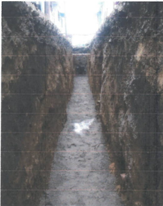
Instalación de arena limpia para tubería
