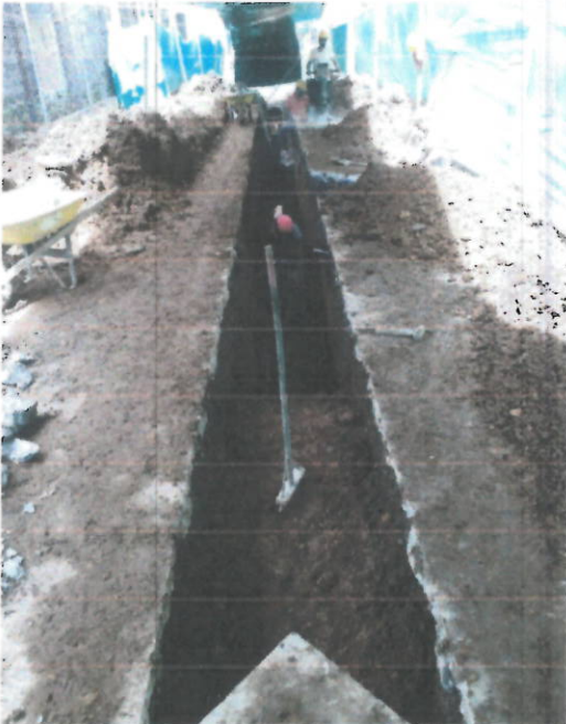
Lleno con material seleccionado de excavación
