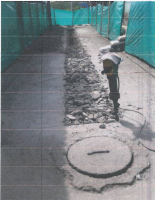
Demolición de pavimento con martillo hidráulico
