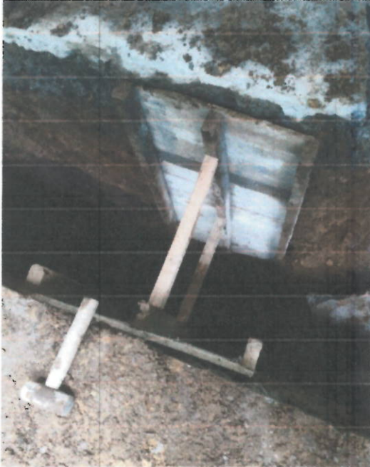
Entibado de la excavación para tubería
