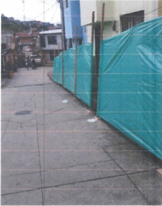
Corte mecanizado de pavimento
