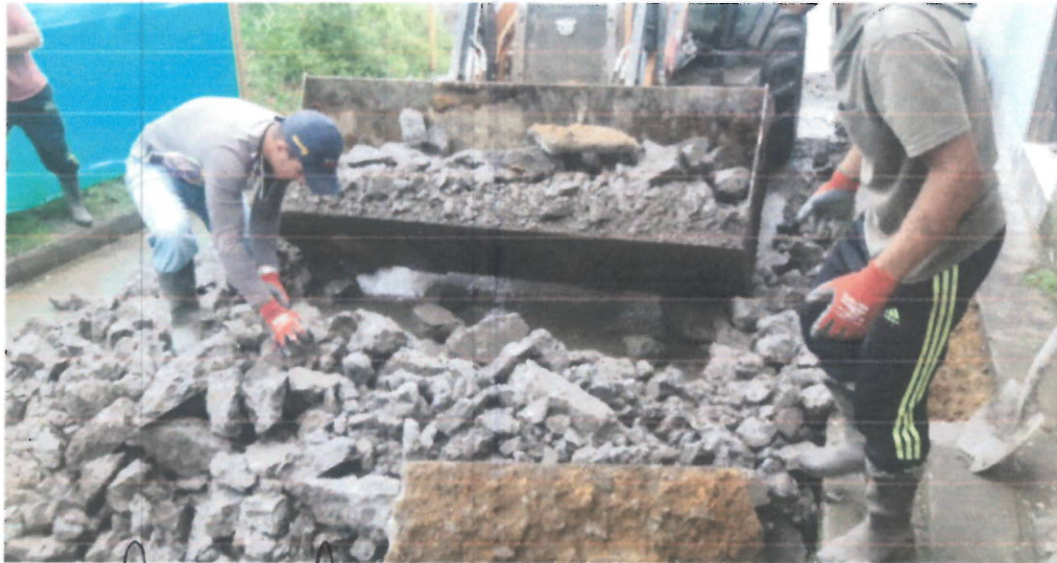
Retiro de escombros pertenecientes a la demolición
