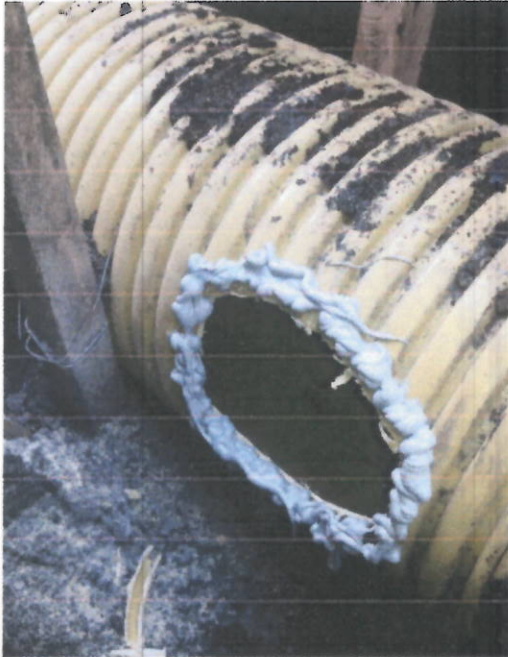
Instalación de silla Yee de 14 x 6"
