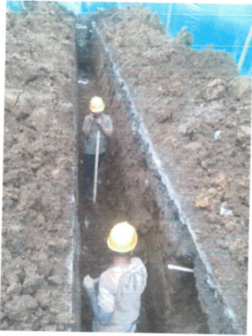
Excavación en material común
