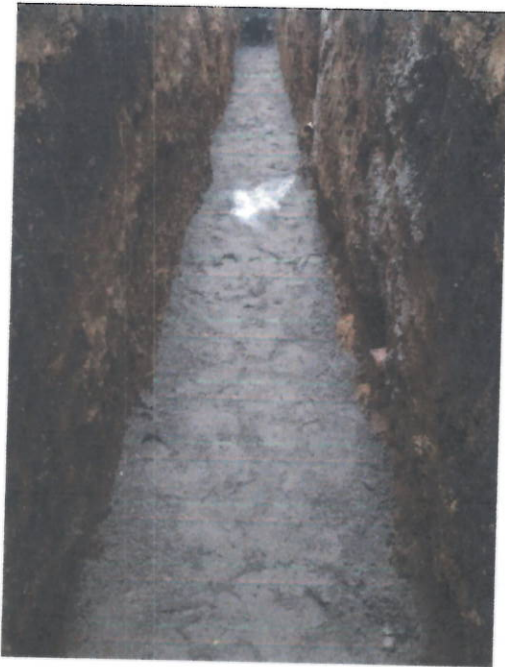
Suministro e instalación de arena
