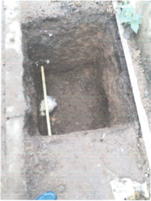
Excavación para construcción de caja para acometida
