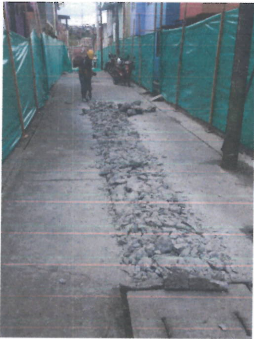
Demolición de pavimento
