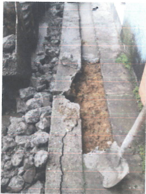
Demolición de andén
