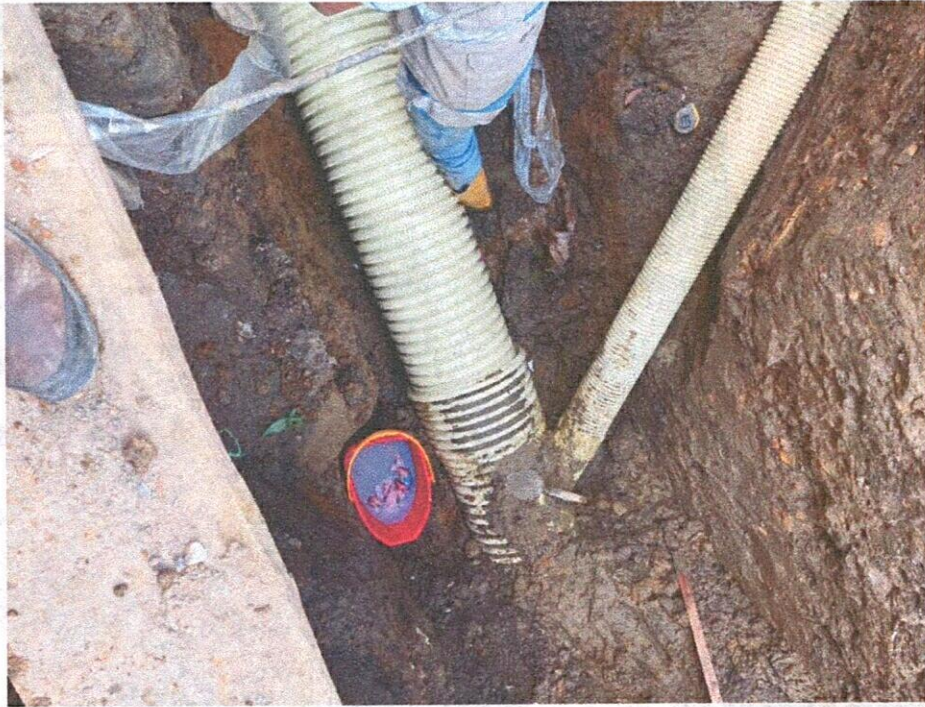
INSTALACIÓN DE TUBERÍA DE 6" CORRUGADA PARA DOMICILIARIA
