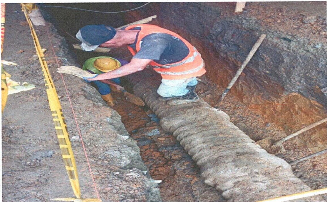
EXCAVACIÓN Y DEMOLICIÓN DE LA TUBERÍA EXISTENTE
