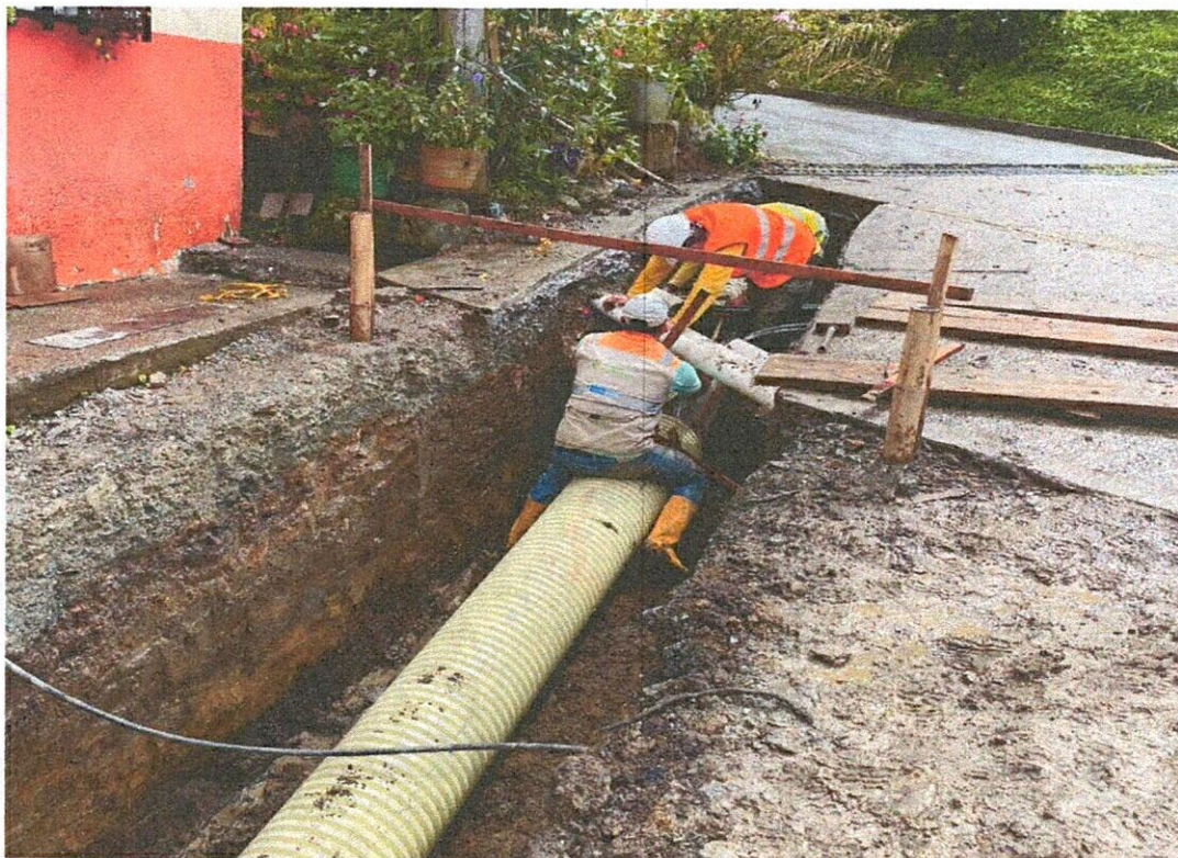
INSTALACIÓN DE TUBERÍA 16" CORRUGADA
