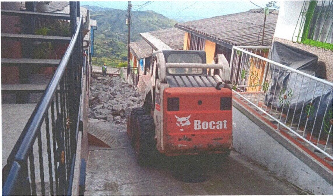
DEMOLICIÓN CON EQUIPO MECÁNICO
