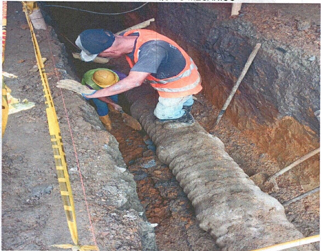
EXCAVACIÓN Y DEMOLICIÓN DE LA TUBERÍA EXISTENTE
