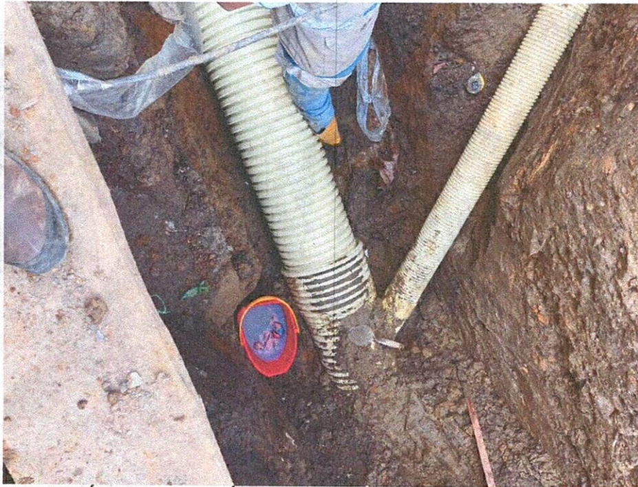
INSTALACIÓN DE TUBERÍA DE 6" CORRUGADA PARA DOMICILIARIA
