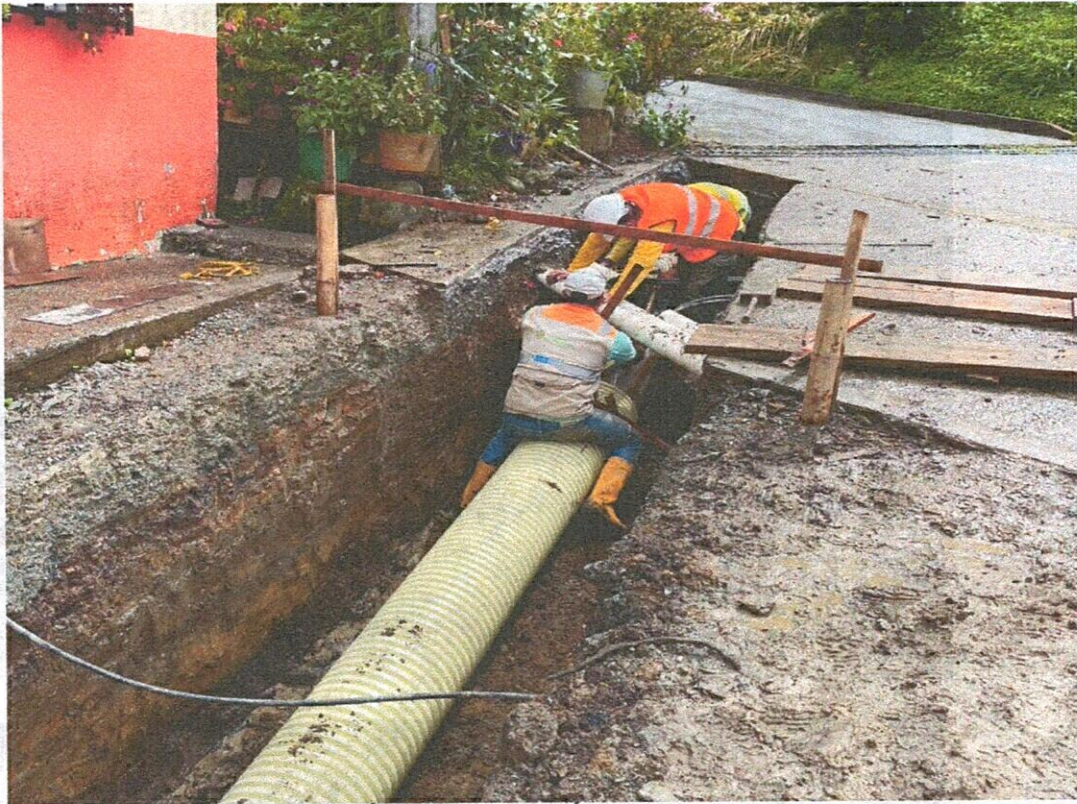
INSTALACIÓN DE TUBERÍA 16" CORRUGADA
