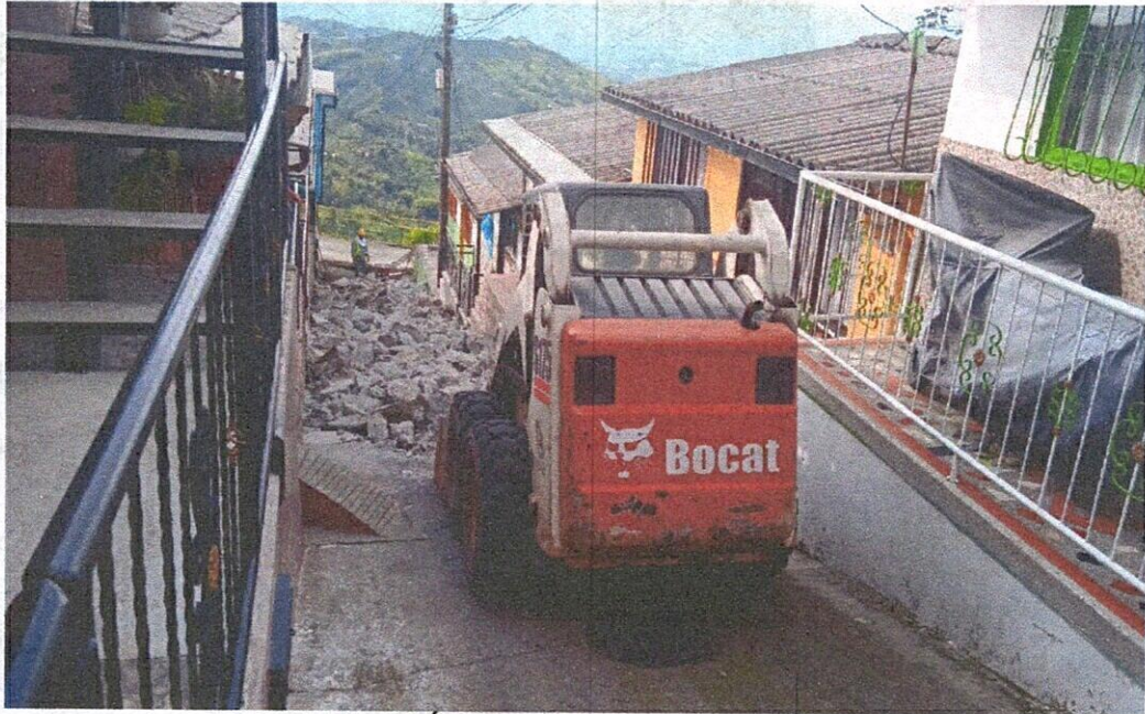
DEMOLICIÓN CON EQUIPO MECÁNICO
