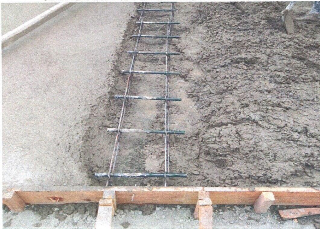
PROCESO DE VACIADO DE CONCRETO Y DOVELAS
