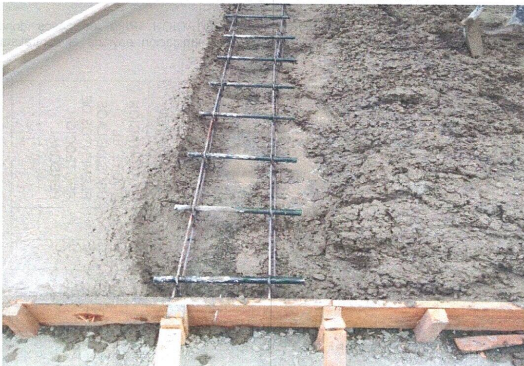
PROCESO DE VACIADO DE CONCRETO Y DOVELAS
