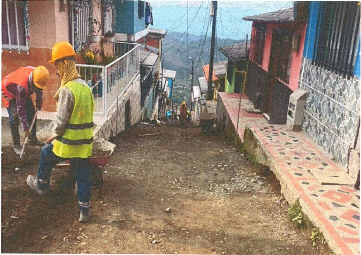
SERIADO CON EQUIPO MECÁNICO CON SUBBASE
