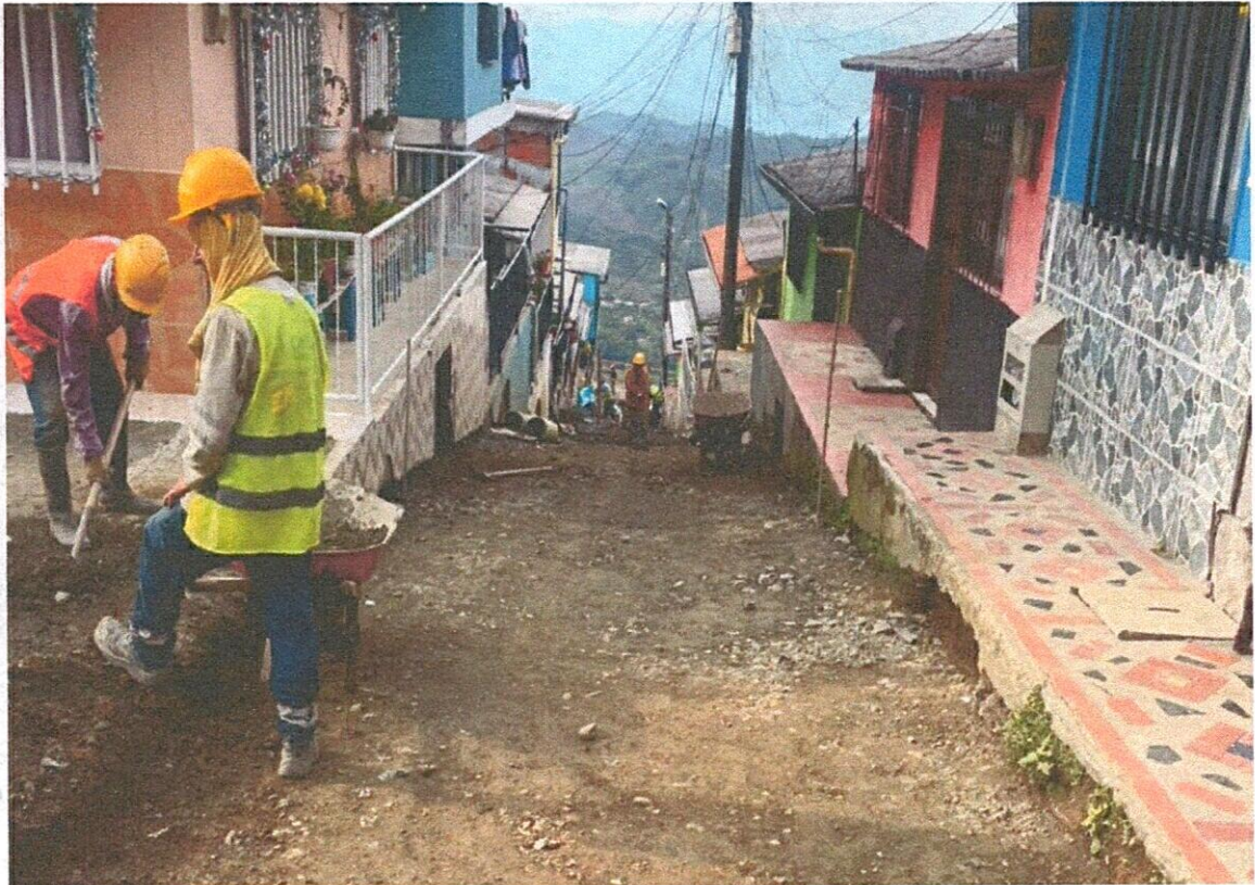
SERIADO CON EQUIPO MECÁNICO CON SUBBASE
