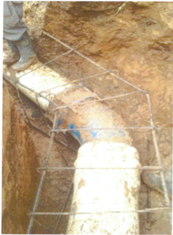
ACERO DE REFUERZO PARA ANCLAJE EN CONCRETO CODO 45
