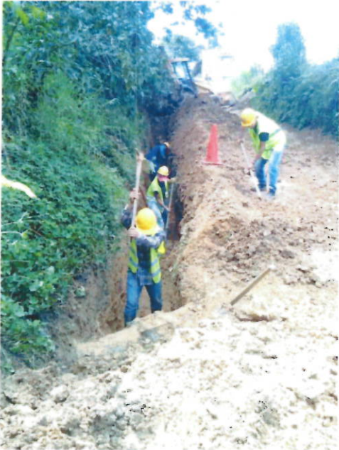
EXCAVACIONES EN CONGLOMERADO E INSTALACION TUBERIA
