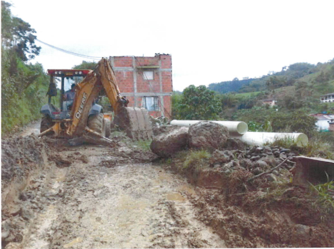
EXCAVACIONES EN CONGLOMERADO - ROCA
