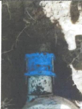
Foto N°10 Empalme entre tubería PVC y tubería de AC Finca Villa Milia
