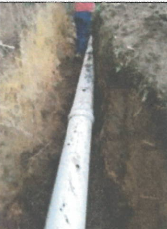
Foto N°6 Empalme tubo a tubo
