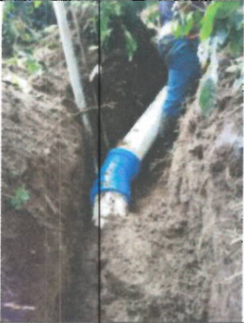
Foto N°9 Instalación de tercer accesorio codo de 22.5° Finca Villa Milia
