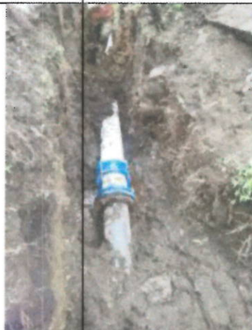
Foto N°5 Empalme 1 Finca San Antonio
