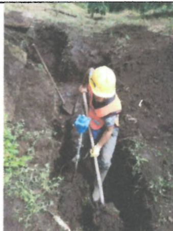
Foto N°2 Proceso de excavación de la tubería de AC
