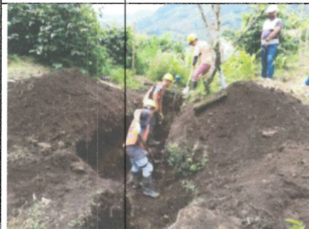
Foto N°3 Proceso de excavación uso de EPP
