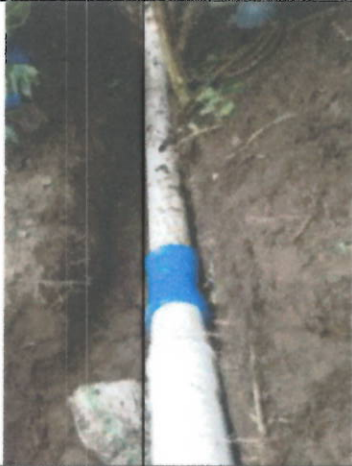
Foto N°7 Instalación de accesorio Codo de 22.5° Finca San Antonio
