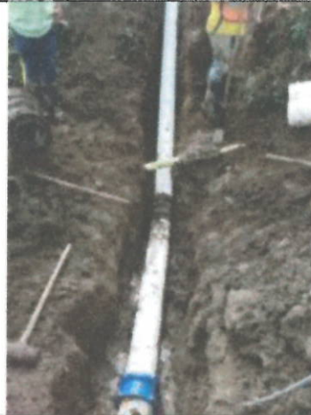
Foto N°8 Instalación de segundo accesorio codo de 22.5° y unión de empalme camino
