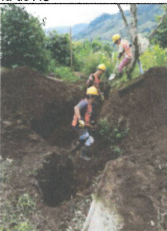
Foto N°4 Proceso de excavación en la línea de conducción
