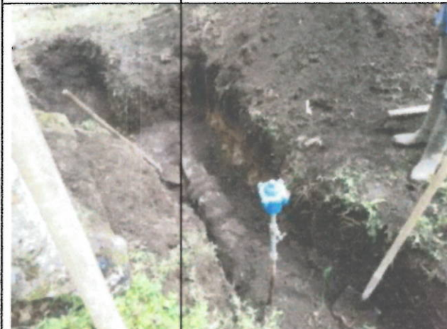
Foto N°1 Excavación zona empalme AC y Polietileno
