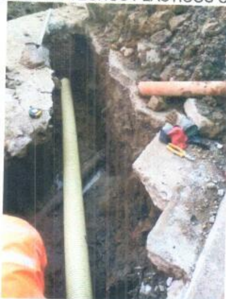
INSTALACION DE DOMICILIARIAS
