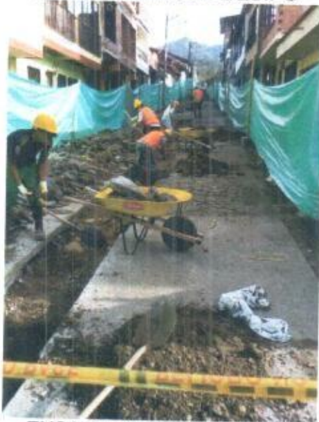
EXCAVACIONES EN ZANJA
