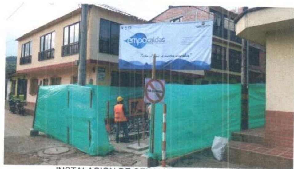
INSTALACION DE SEÑALES PREVENTIVAS
