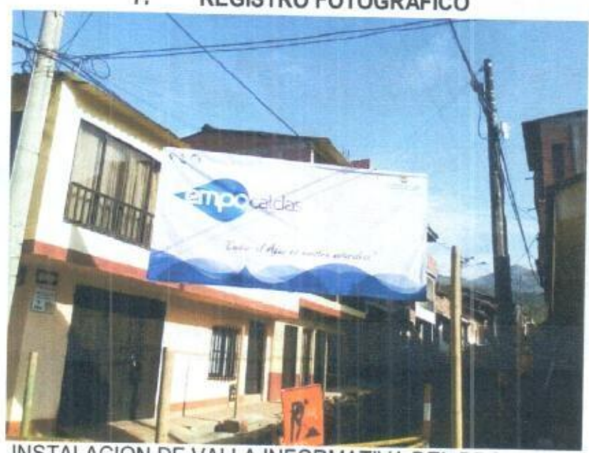
INSTALACION DE VALLA INFORMATIVA DEL PROYECTO
