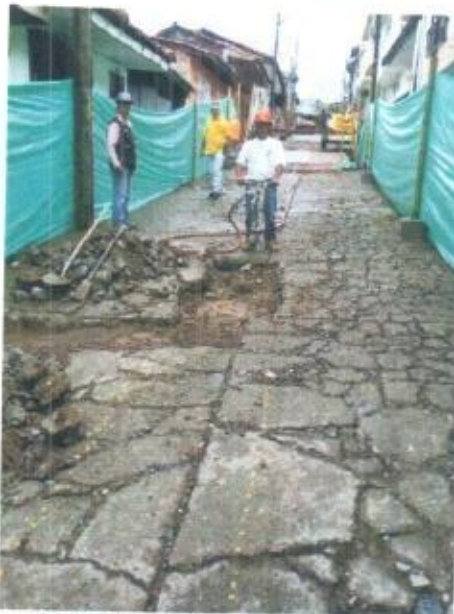
DEMOLICION CON EQUIPO
