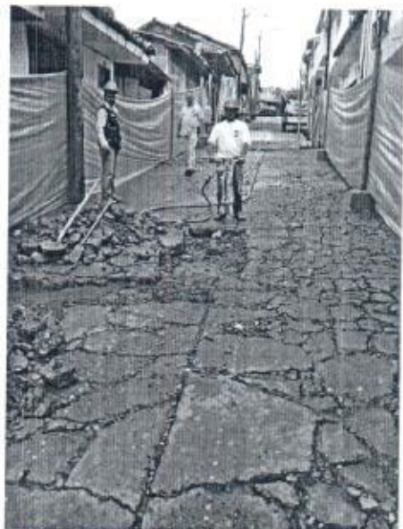
DEMOLICION CON EQUIPO
