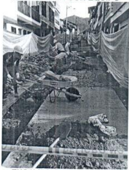
EXCAVACIONES EN ZANJA
