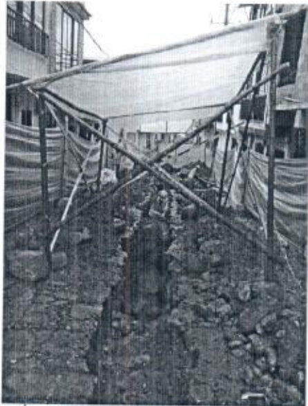
COSNTRUCCIÓN DE TECHOS PLASTICOS CON GUADUA
