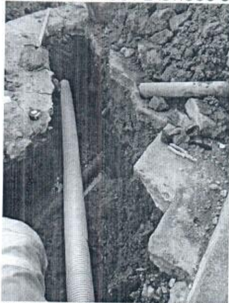
INSTALACION DE DOMICILIARIAS
