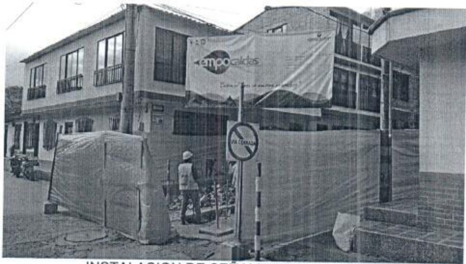
INSTALACION DE SEÑALES PREVENTIVAS
