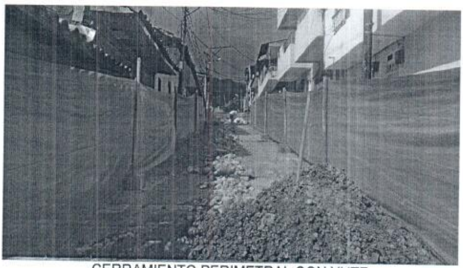
CERRAMIENTO PERIMETRAL CON YUTE
