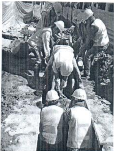
EXCAVACIONES CON PRESENCIA DE ROCA
