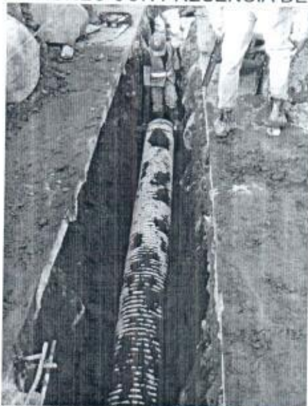
INSTALACION DE TUBERIA NOVAFORT
