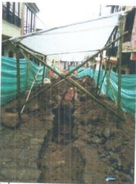
COSNTRUCCIÓN DE TECHOS PLASTICOS CON GUADUA
