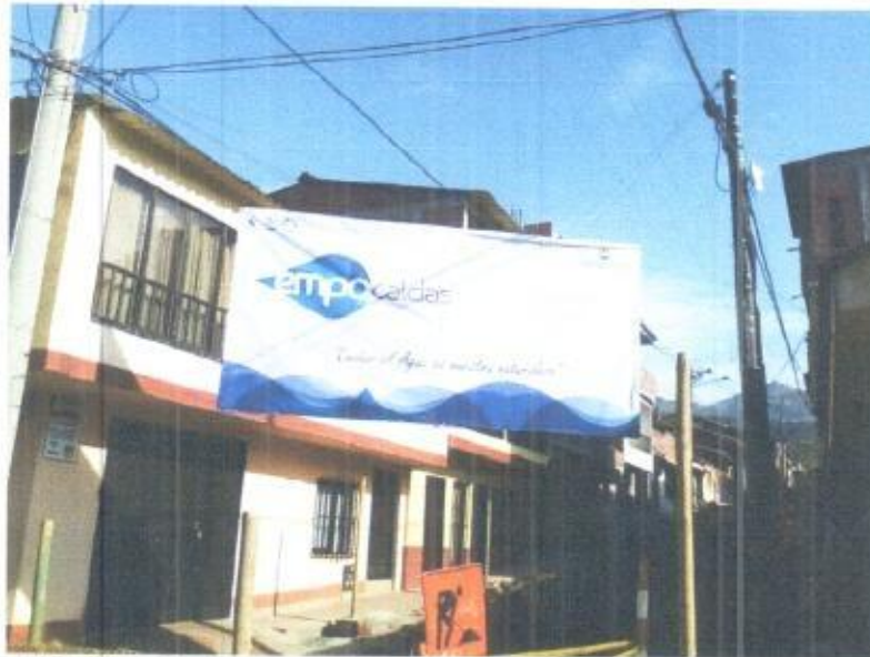
INSTALACION DE VALLA INFORMATIVA DEL PROYECTO
