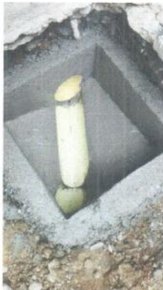
CONSTRUCCION DE CAJAS PARA ALCANTARILLADO
