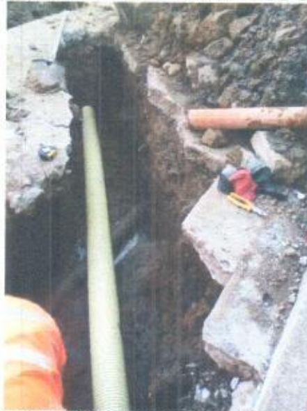
INSTALACION DE DOMICILIARIAS
