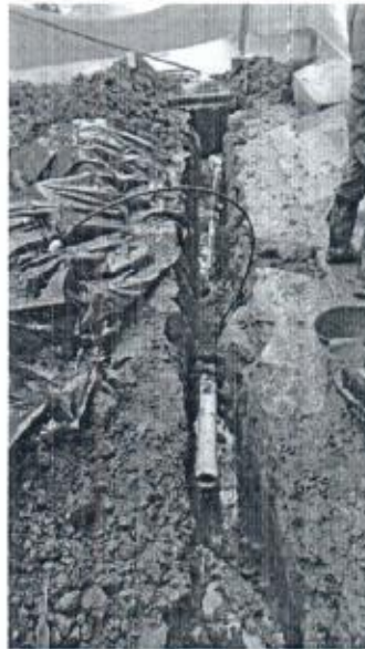
INSTALACION RED PRINCIPAL DE ACUEDUCTO
