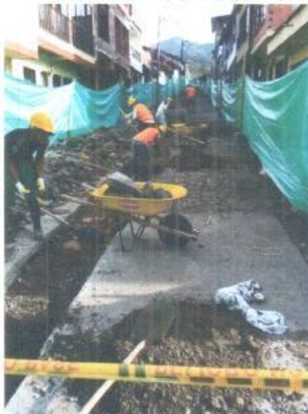
EXCAVACIONES EN ZANJA
