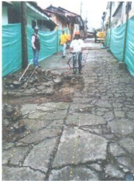
DEMOLICION CON EQUIPO
