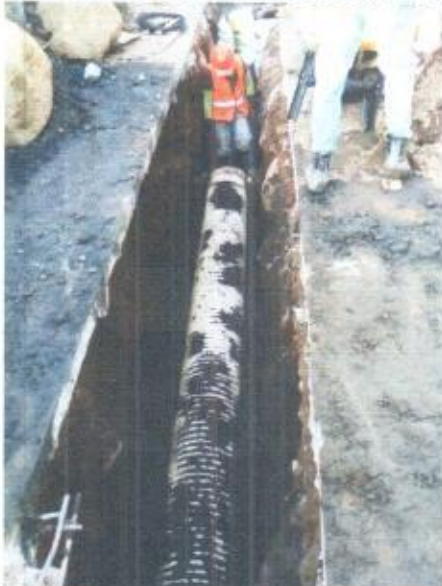
INSTALACION DE TUBERIA NOVAFORT
