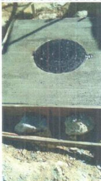
TAPA Y LOSA DE CAMARA CIRCULAR
