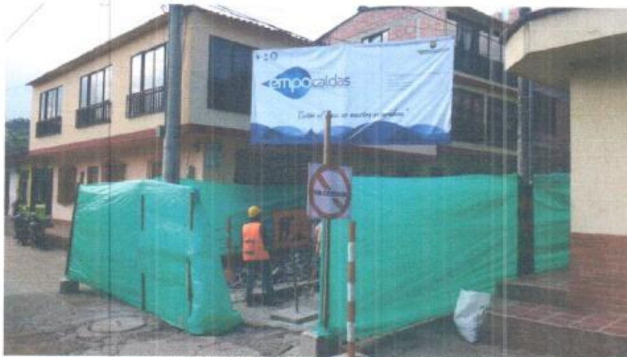
INSTALACION DE SENALES PREVENTIVAS
