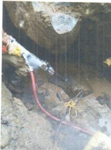
DEMOLICION CON EQUIPO MECANICO
