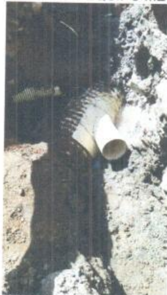
INSTALACION DE SILLETAS
