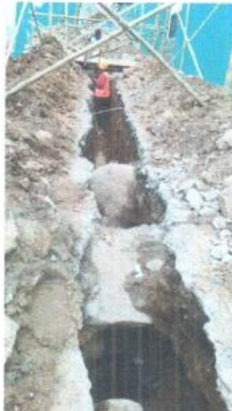
EXCAVACION EN ROCA
