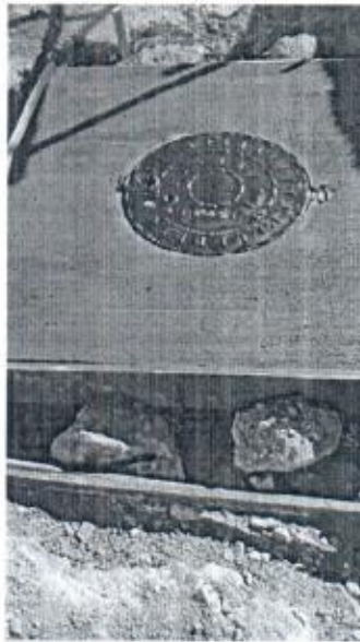
INSTALACION DE TAPA CAMARA
