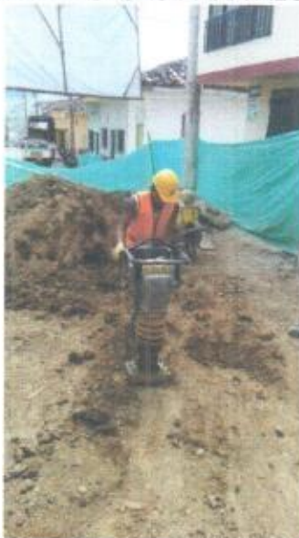
COMPACTACION DE LLENO
