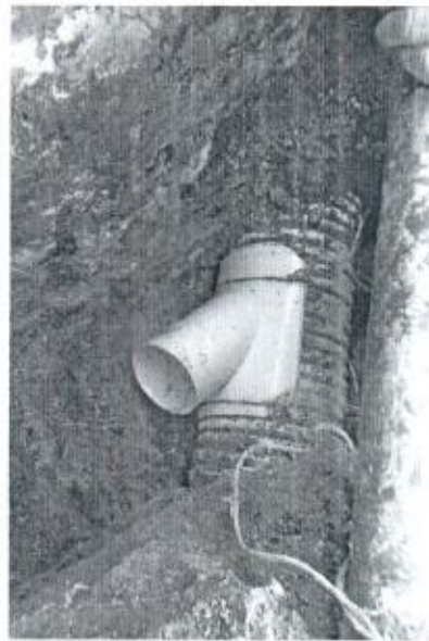
INSTALACION DE SILLETAS
