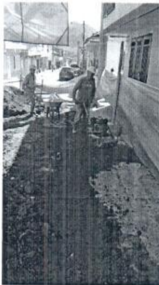
LLENOS Y COMPACTACION
