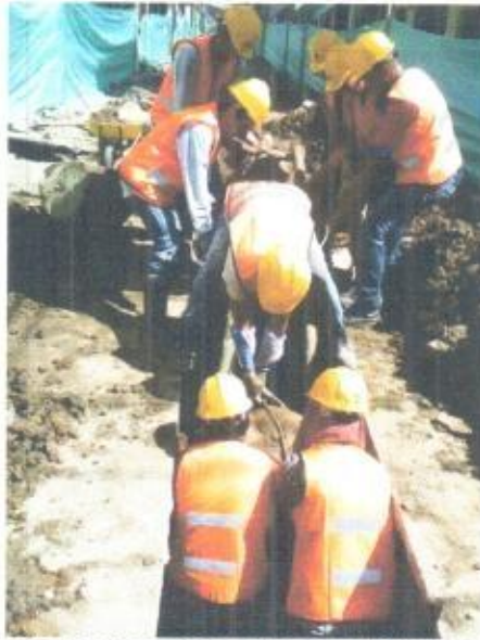
EXCAVACIONES CON PRESENCIA DE ROCA
