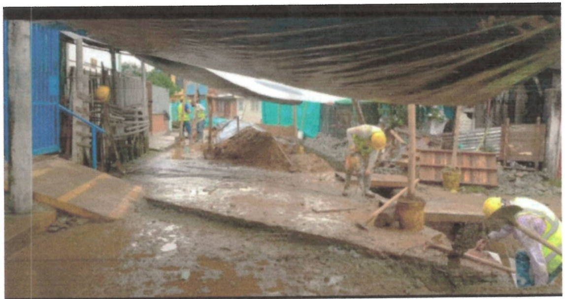
COMPACTACIÓN DE MATERIAL Y TECHADO DE OBRA POR OLA INVERNAL
