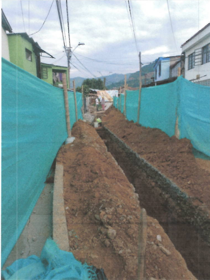
EXCAVACIONES PARA INSTALACIÓN DE TUBERÍAS
