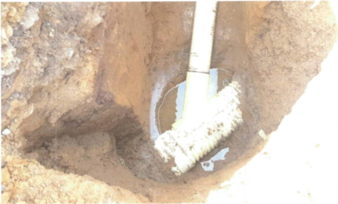
INSTALACIÓN DE TUBERÍA DE ALCANTARILLADO
