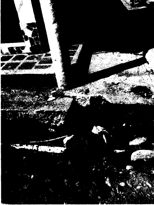
Cama de arena tubería Ø= 3" PVC acueducto
